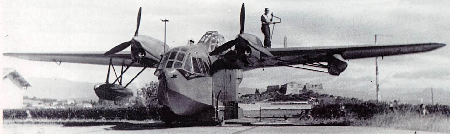
Déverrouillage des ailes à la manivelle et par André Coste, avant leur repliage, devant le Fort Carré d'Antibes.
