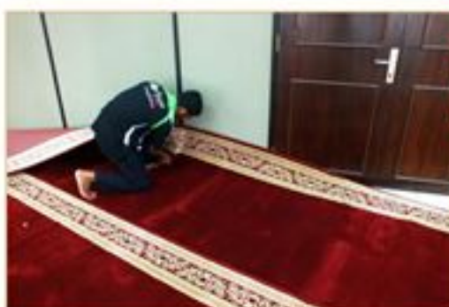
Pemotongan karpets sesuai dengan bentuk ruangan
