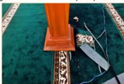
Pemotongan coakan tiang dengan rapi & presisi
