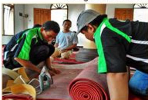
Proses Penyambungan dengan lem khusus
