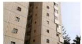
קשיש כבן 70 נפל מהקומה ה-11, אל פיר חדר המדרגות שבבניין, ונפצע באורח אנוש (צילום: יח'צ)
