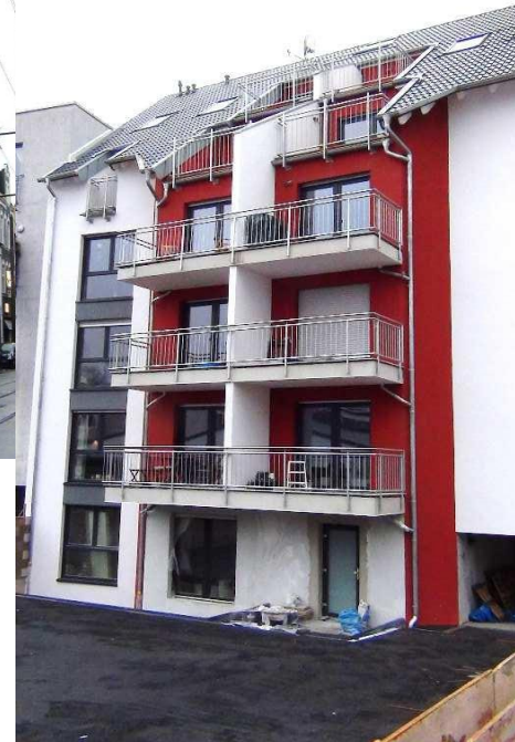
mehrfamilien-wohnhaus neusser str, köln-weidenpesch 2013
