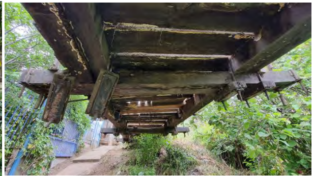
Imagen 08: Detalle de Estructura.
