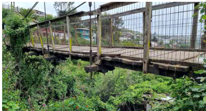
Imagen 10: Barandas de Contención.
