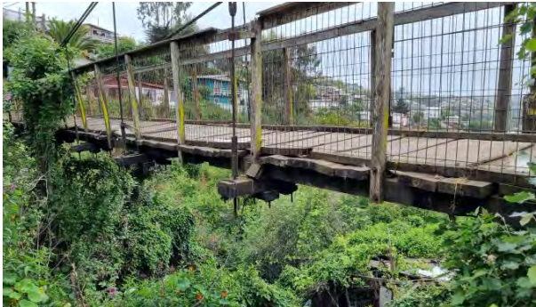
Imagen 07: Estructura de Pasarela.
