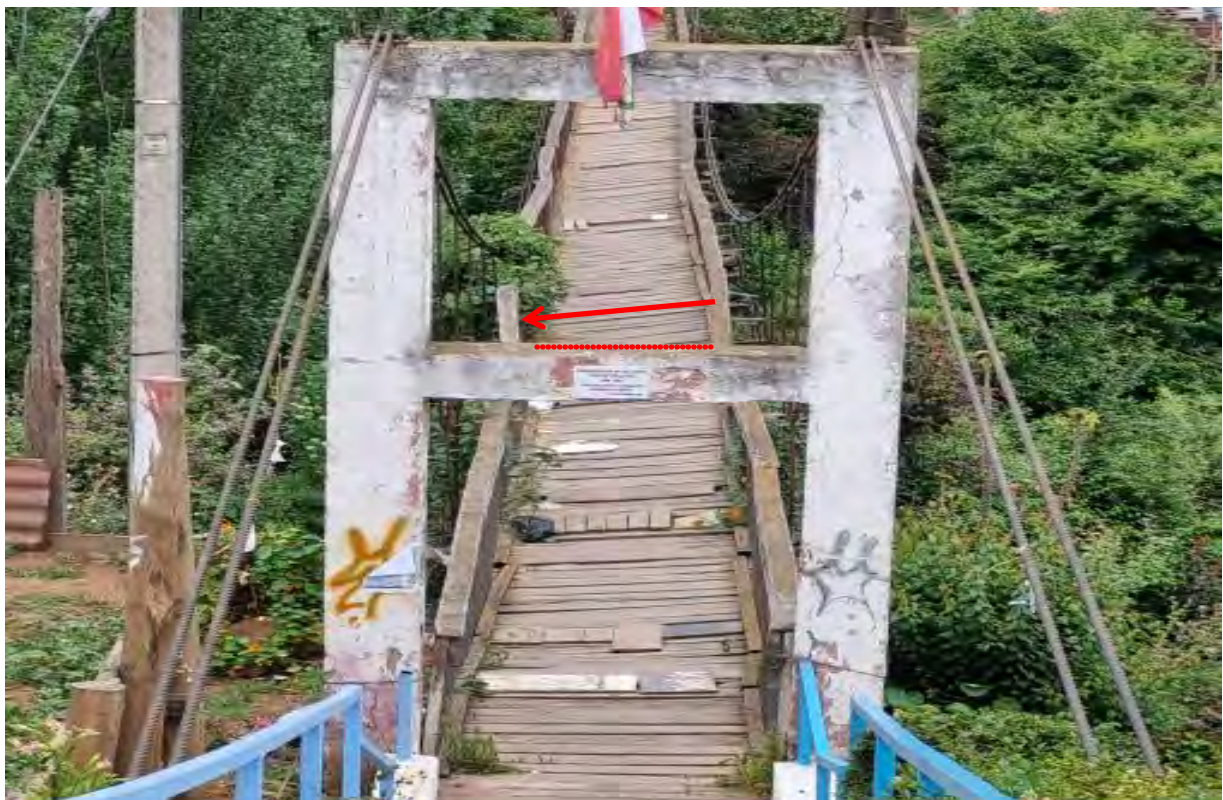
Imagen 04: Vista desde calle Hermanos Carrera con inclinación al Poniente.
