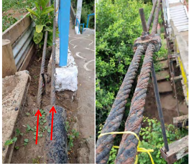
Imagen 03: Cables anclados hacia calle Hermanos Carrera
