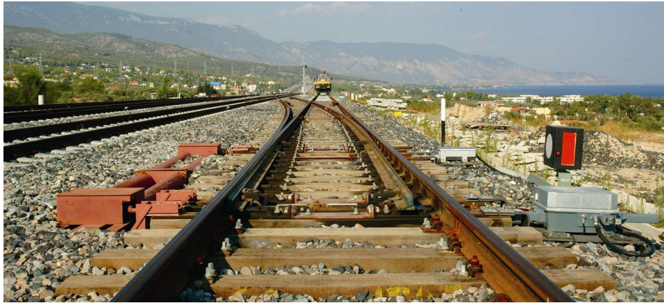
Σχήμα 2.5: Σύνδεση παραλλήλων γραμμών (διαγώνιος ή crossover)
