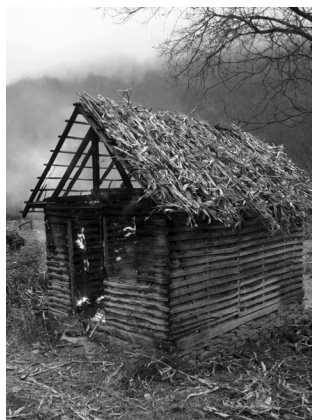
Слика 5 – Северни део објекта након великог пламена остаје нетакнут
