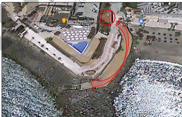
Aliviadero de emergencia en DPMT de la EBAR Torviscas (edificio de techo rojizo)
