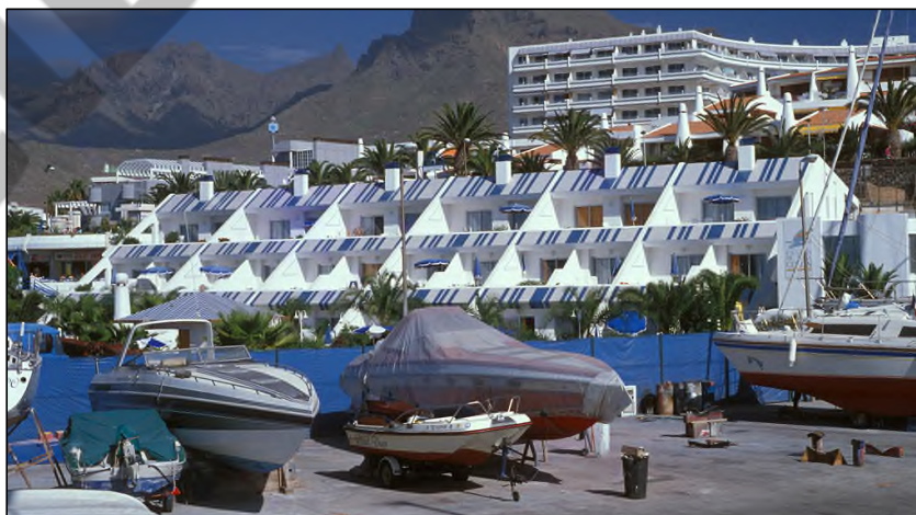
Edificio de uso habitacional en DPMT traspasado
