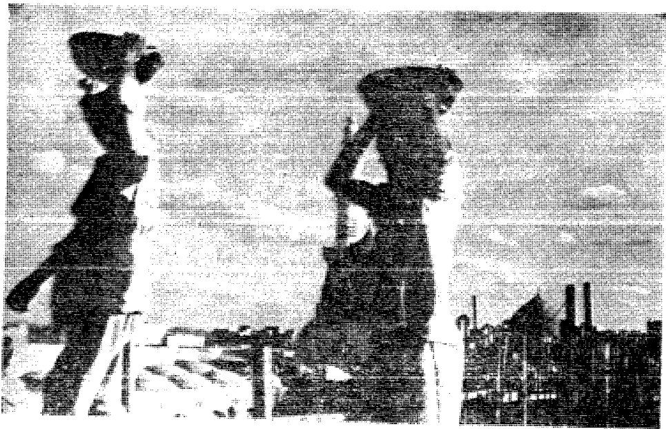
العمال أثناء تأديتهم عملهم يمرّون فوق السقاييل الخشبية فعمارة المسجد النبوي الشريف
