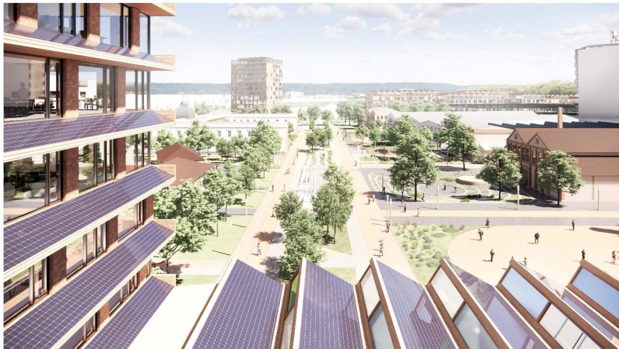
Pogled sa krova Mašinske radionice ka javnoj površini
