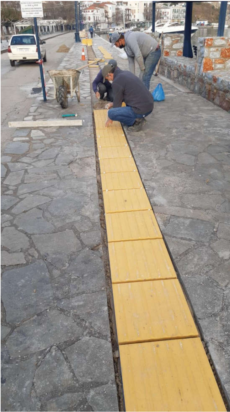
(Εργασίες διαμόρφωσης παραλιακού μετώπου Σκοπέλου )
