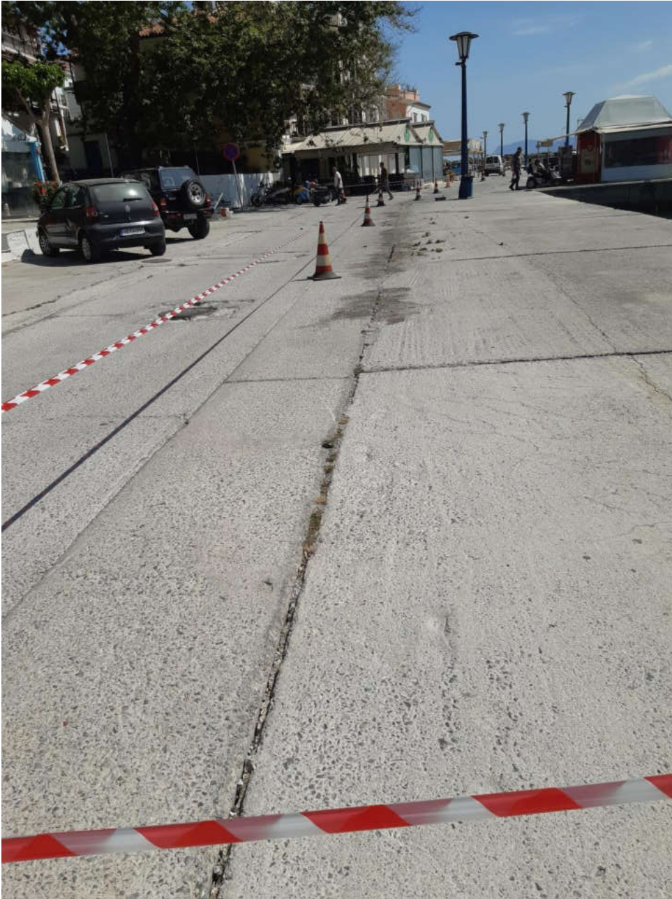
(Εργασίες επισκευής στο λιμένα Σκοπέλου)
