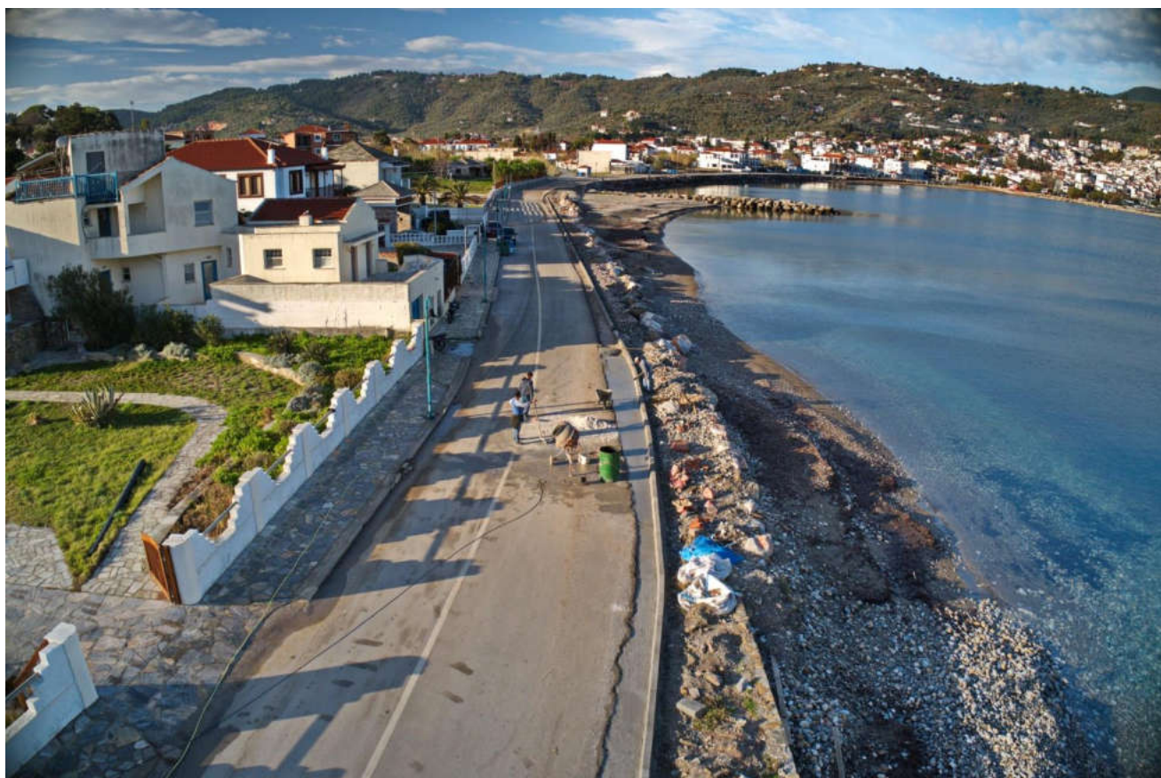
(Κατασκευή πεζοδρομίου στην περιοχή της Αμπελικής)
