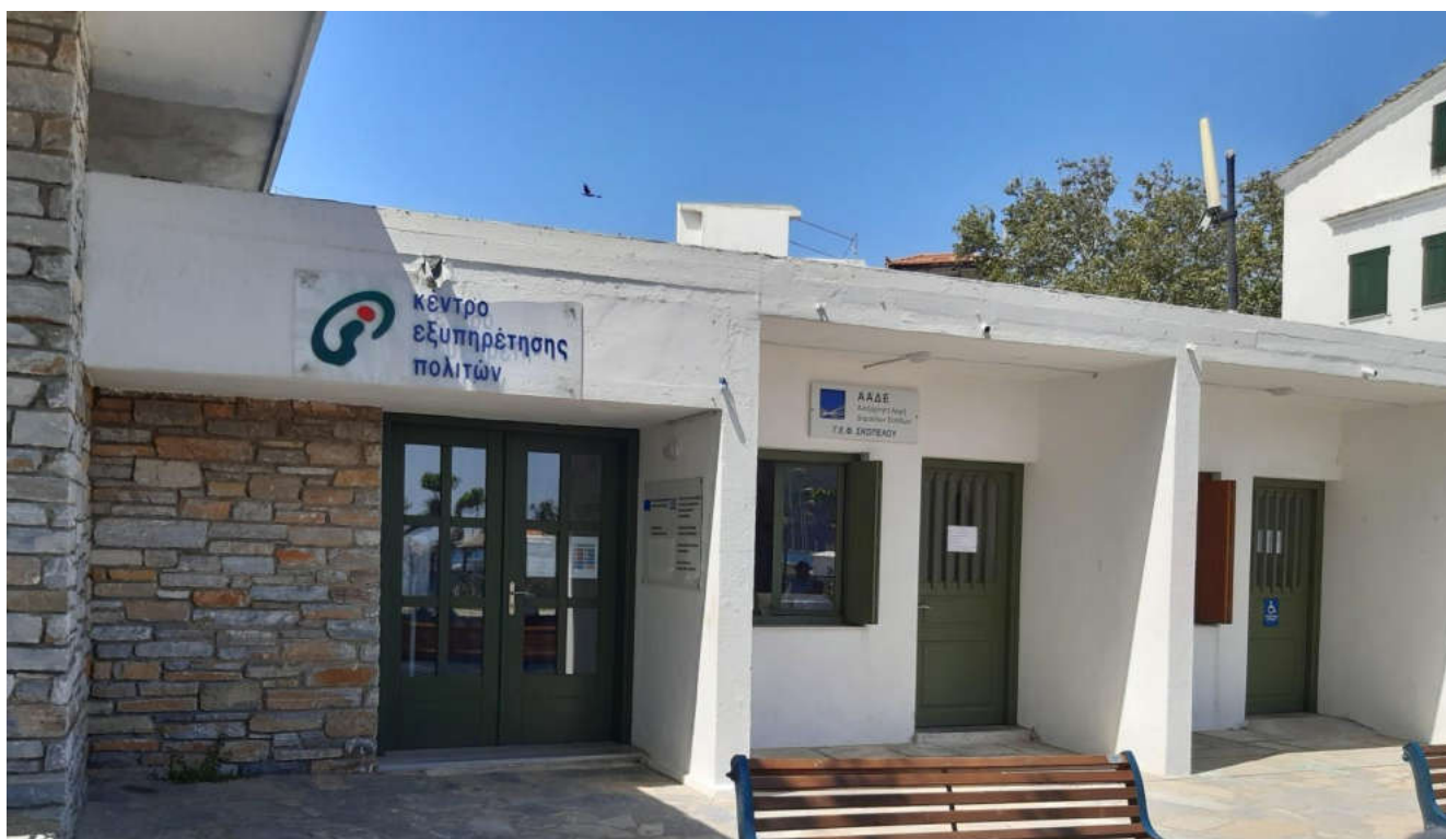
(Εγκατάσταση της υπηρεσίας ΚΕΠ Σκοπέλου στο κτήριο του Ξενία)
