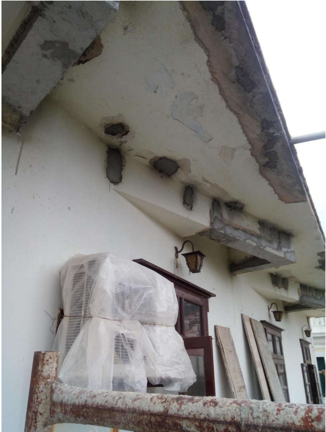
(Εργασίες πρώην στο κτίριο του ΚΑΠΗ)
