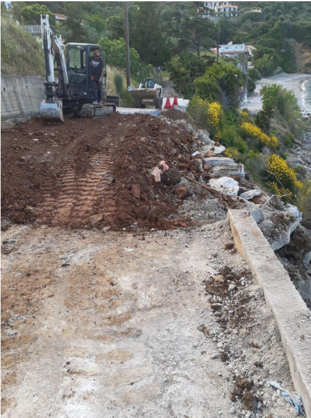
(Εργασίες στην περιοχή Αγ. Κωνσταντίνου)
