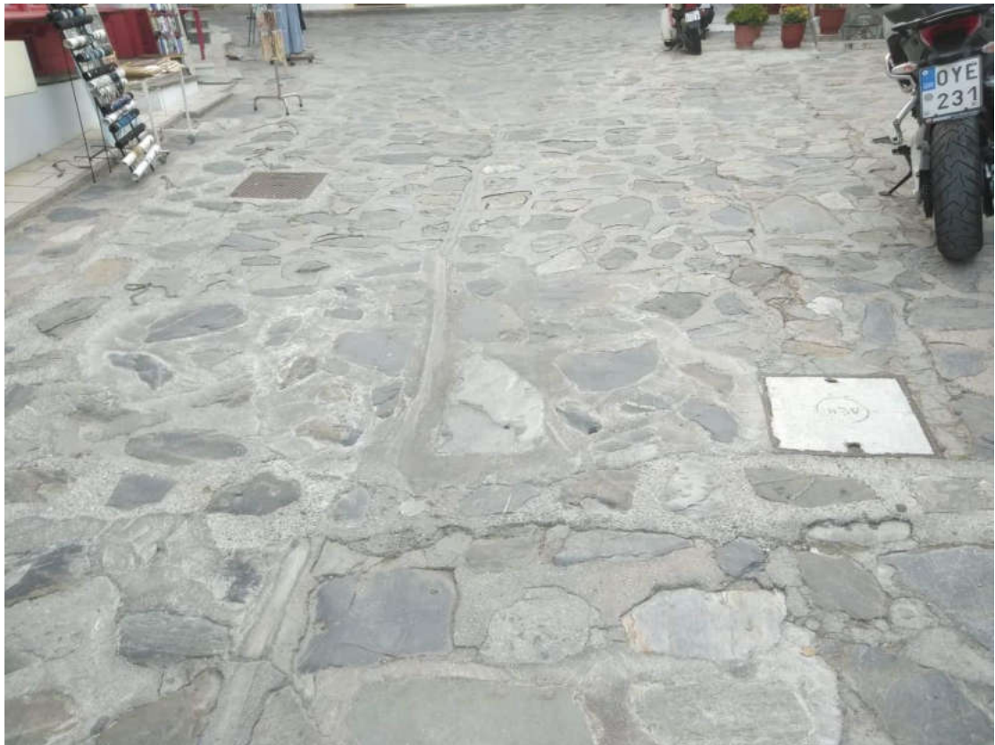
(Εργασίες αποκατάστασης πλακόστρωτου)
