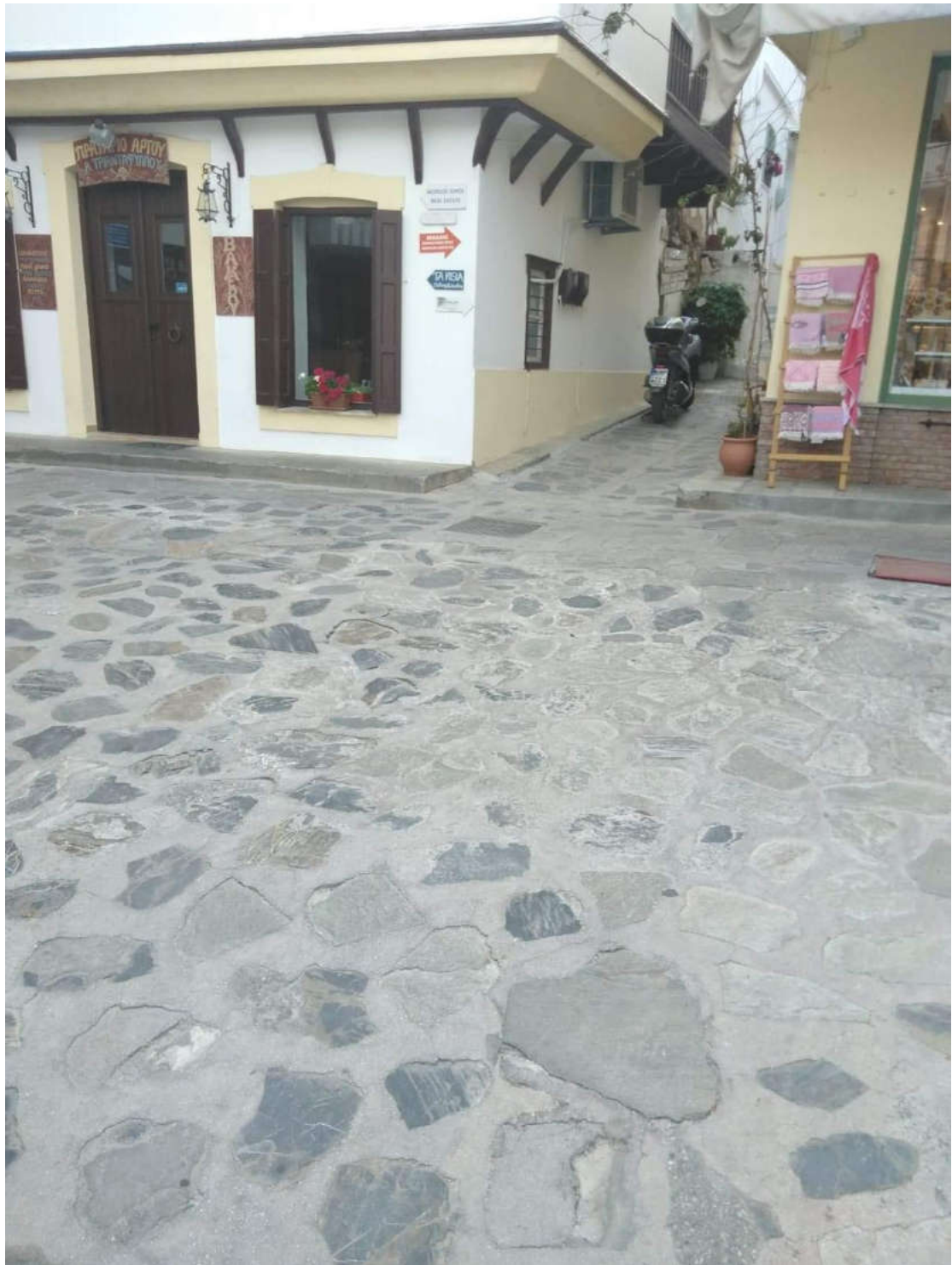
(Εργασίες αποκατάστασης πλακόστρωτου)
