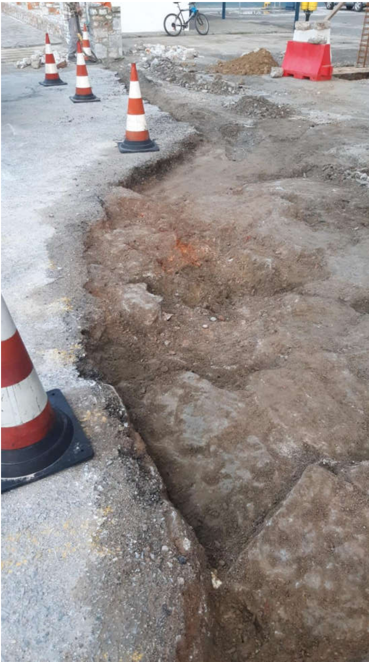
(Εργασίες διαμόρφωσης στην Είσοδο του λιμένα Σκοπέλου)
