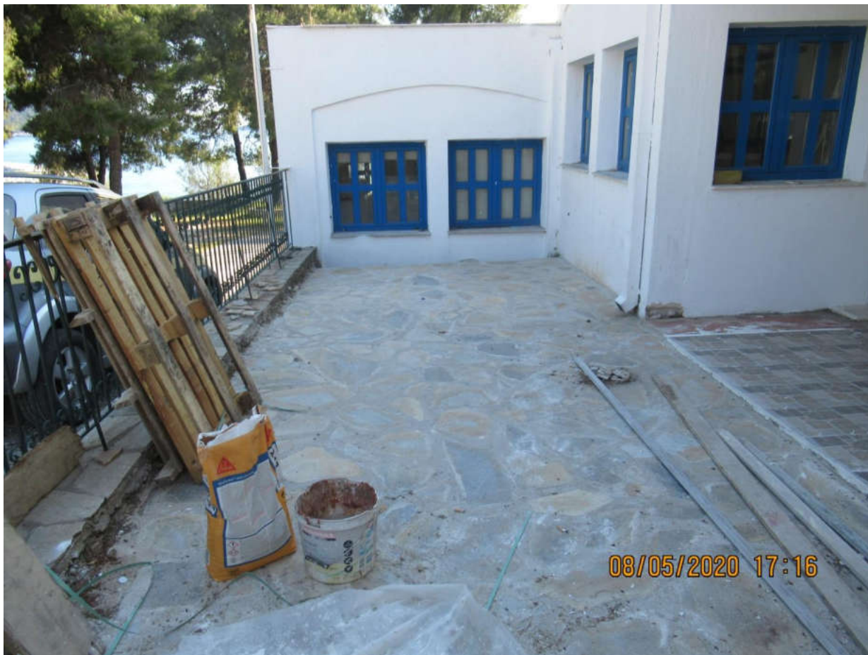
(Εργασίες στο Ιατρείο του Νέου κλήματος)
