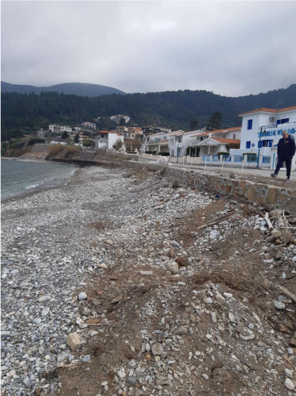
(Κατασκευή πεζοδρόμησης στην περιοχή της Αμπελικής)
