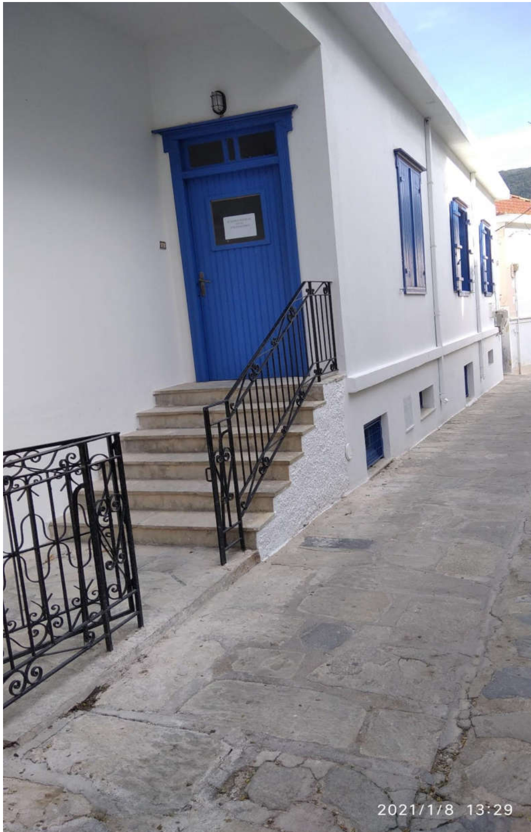
(Εργασίες ελαιοχρωματισμού - κτίριο ΒΟΥΓΙΑΛΑ - πρώην ΚΑΠΗ)
