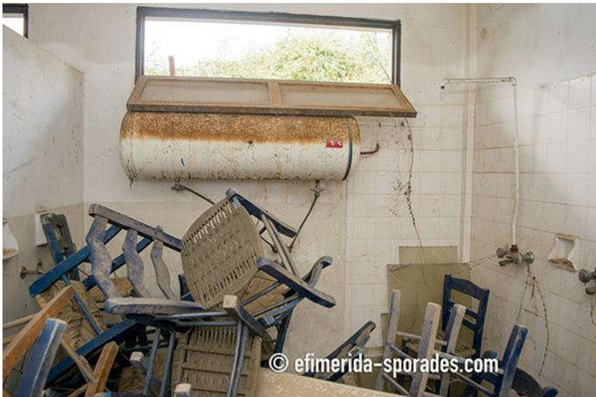
(Πριν - Κτίριο πλησίον Κέντρου υγείας Σκοπέλου 2019)
