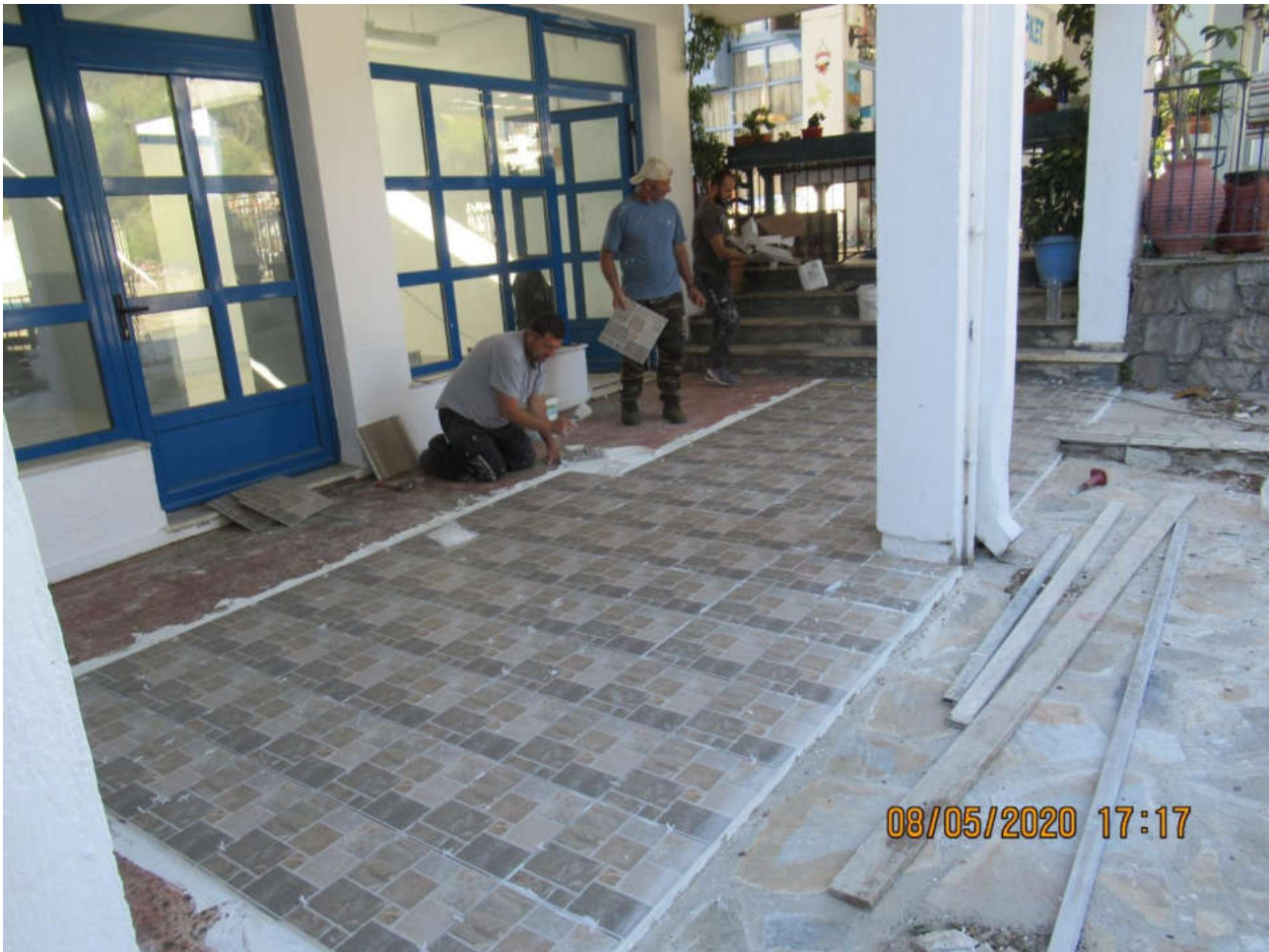
(Εργασίες στο Ιατρείο του Νέου κλήματος)
