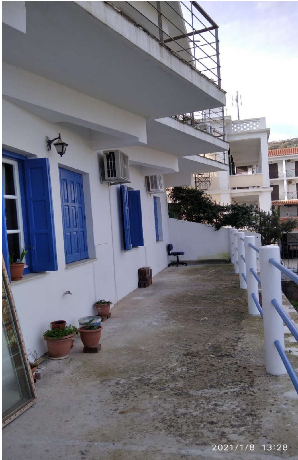
(Εργασίες ελαιοχρωματισμού - κτίριο ΒΟΥΓΙΑΛΑ - πρώην ΚΑΠΗ)
