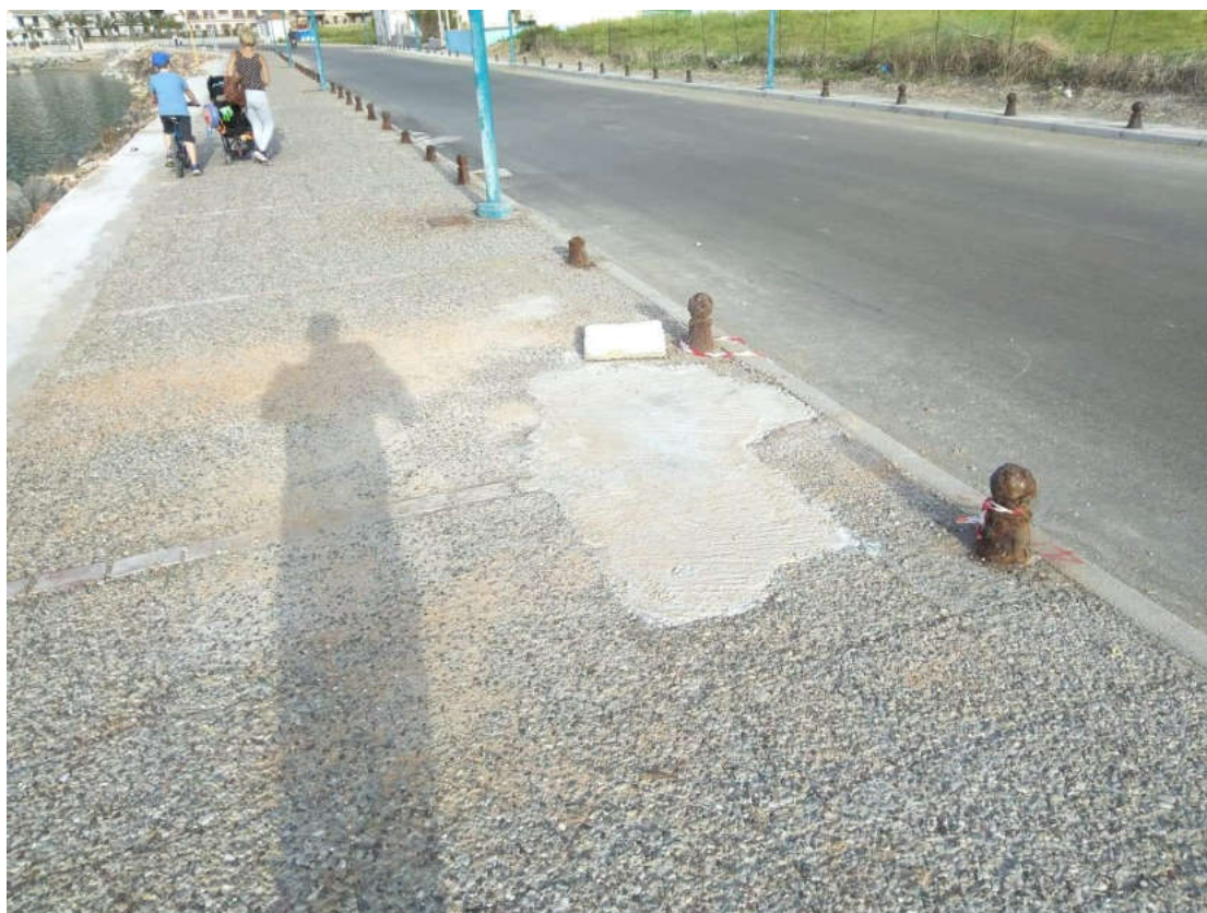
(Εργασίες αποκατάστασης πεζόδρομου )
