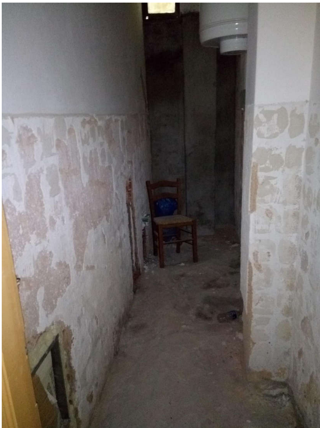
(Εργασίες πρώην στο κτίριο του ΚΑΠΗ)
