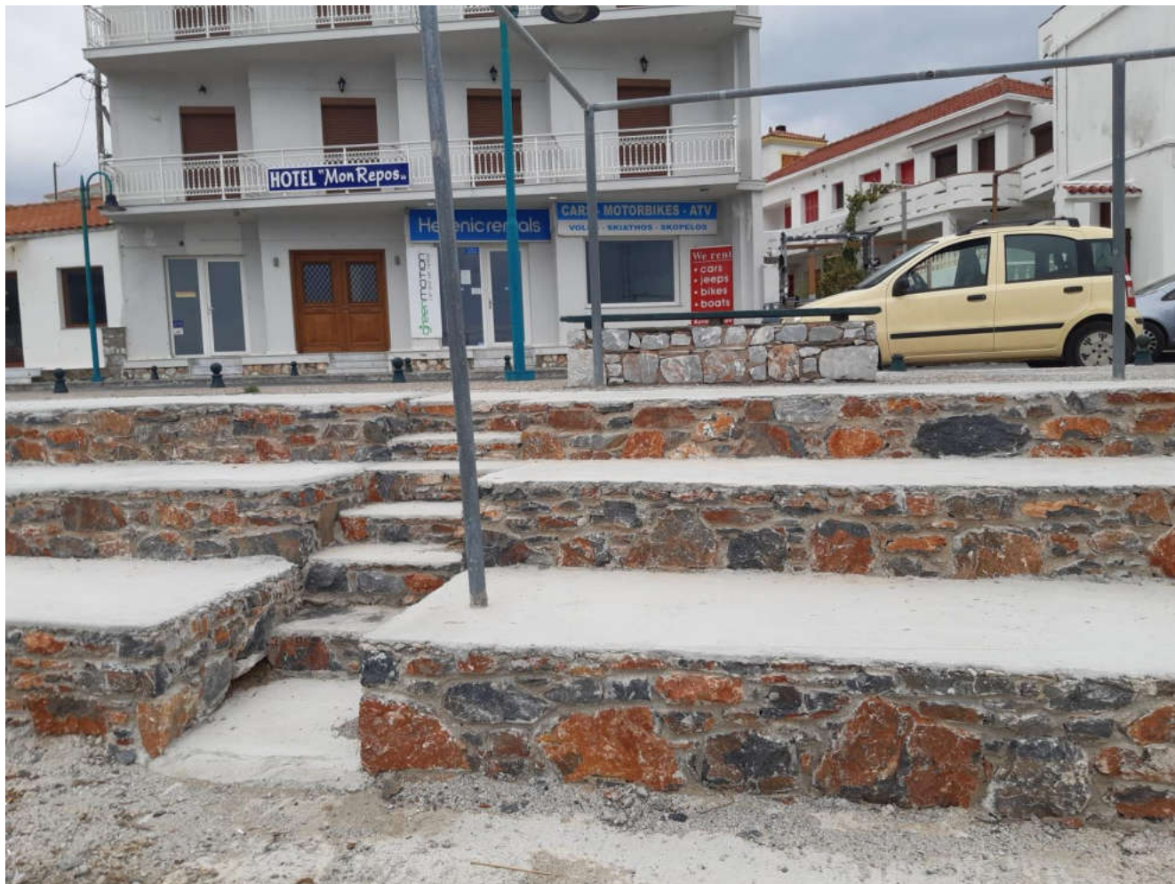
(Ανακατασκευή κερκίδων στην παραλία Σκοπέλου)
