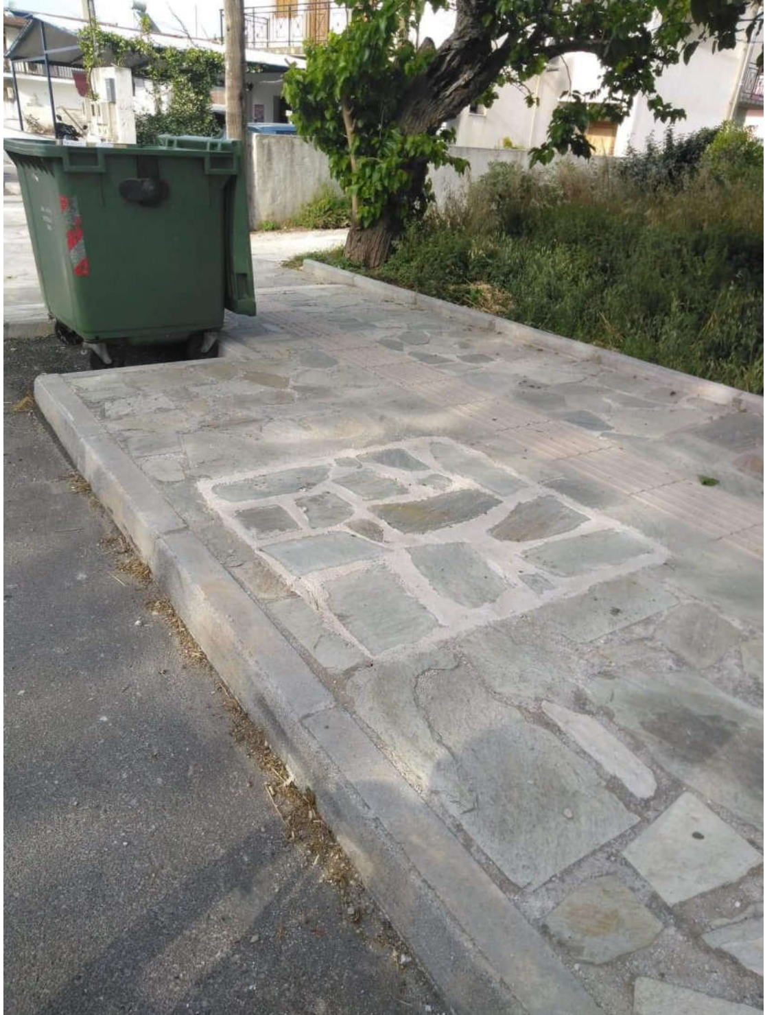
(Εργασίες αποκατάστασης πεζόδρομου)
