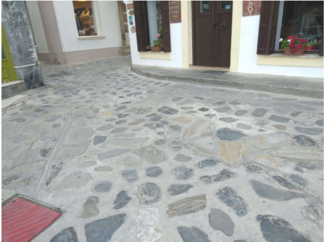
(Εργασίες αποκατάστασης πλακόστρωτου)
