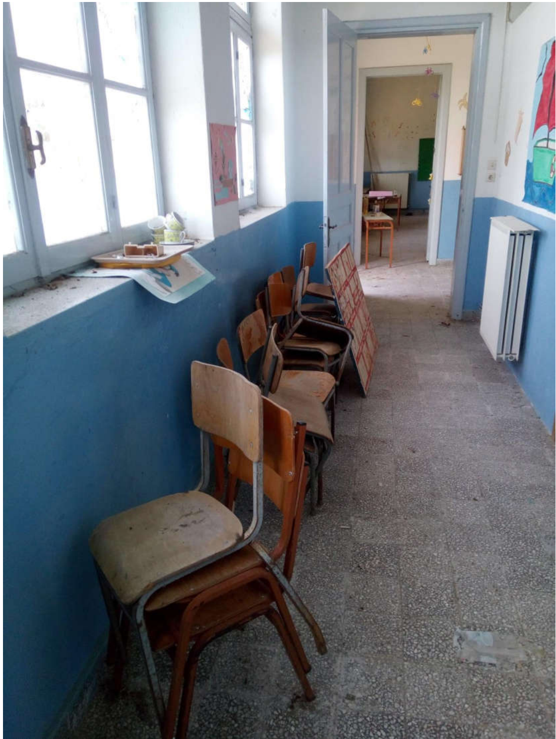
(Δημοτικό σχολείο Παλαιού Κλήματος)
