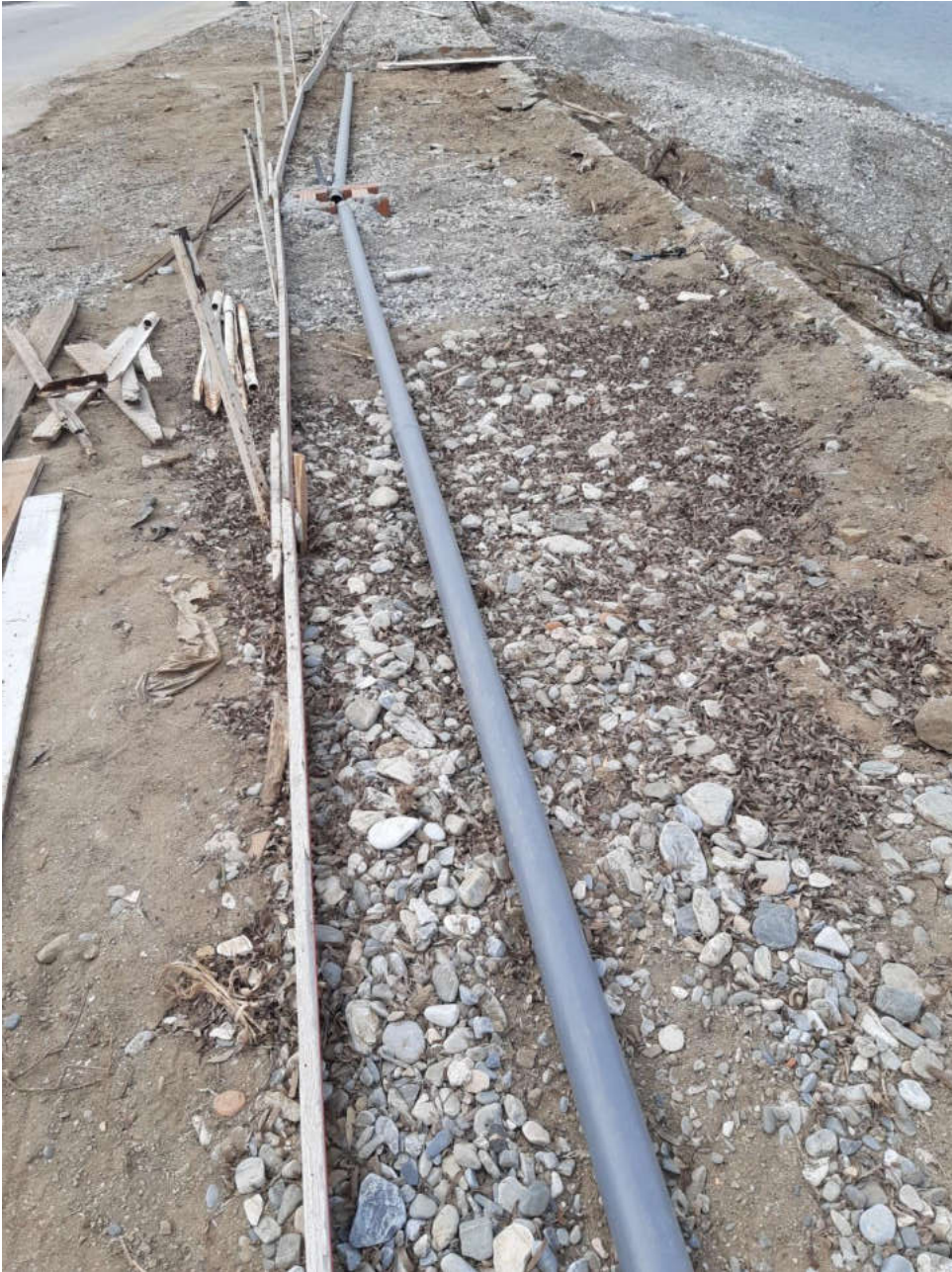
(Κατασκευή πεζοδρόμησης στην περιοχή της Αμπελικής)
