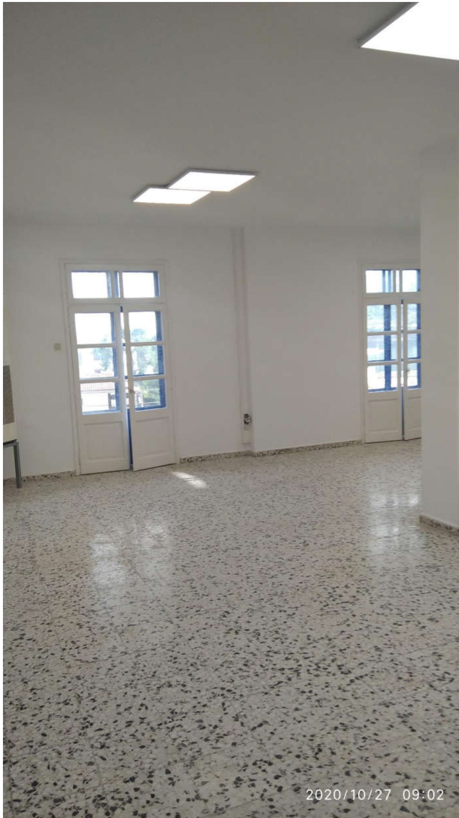
(ΟΛΟΚΛΗΡΩΣΗ ΕΡΓΑΣΙΩΝ ΚΤΙΡΙΟ ΒΟΥΓΙΑΛΑ – ΠΡΩΗΝ ΚΑΠΗ)
