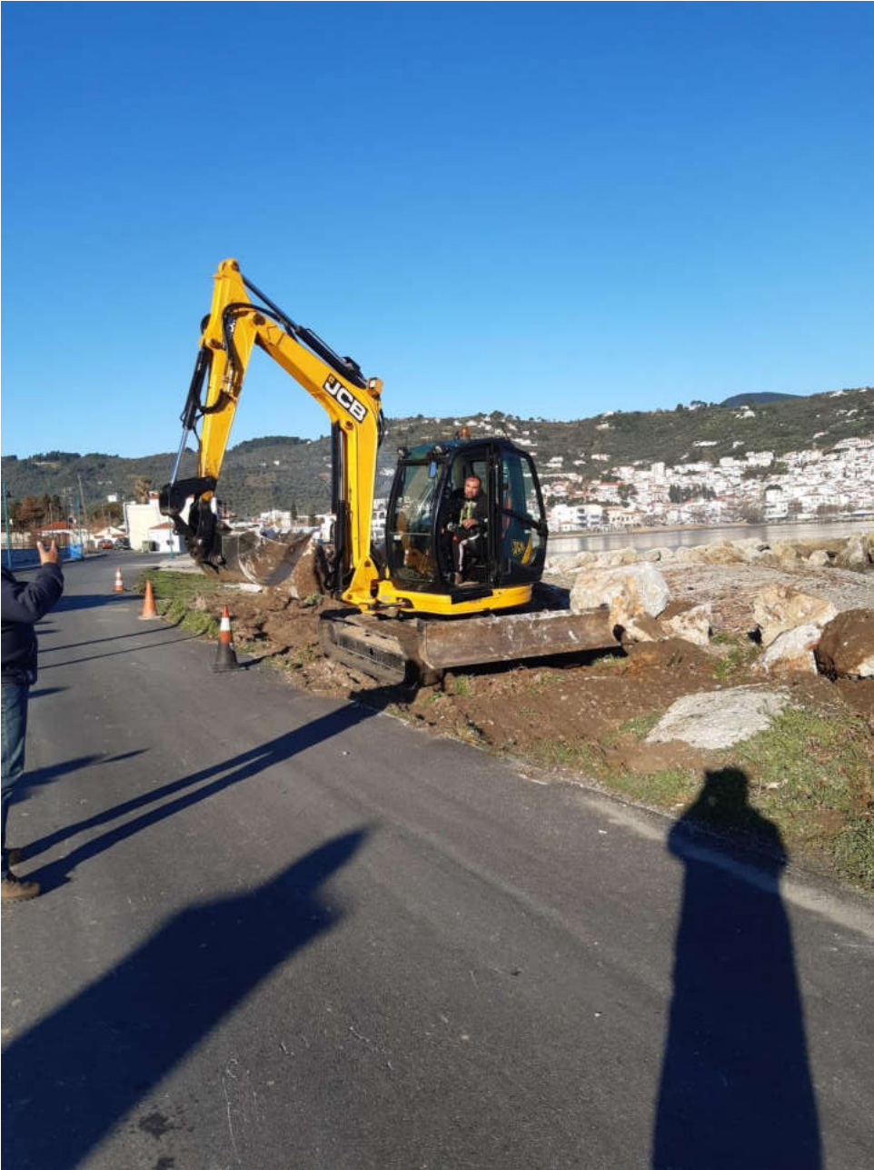
(Κατασκευή πεζοδρομίου στην περιοχή της Αμπελικής)
