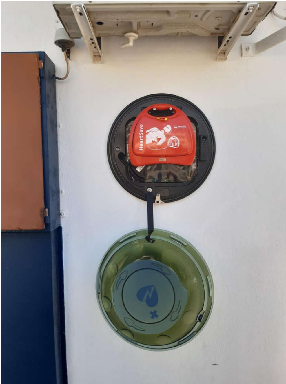
(Τοποθέτηση Απινιδωτή στο Λιμενικό Φυλάκιο Λουτρακίου)
