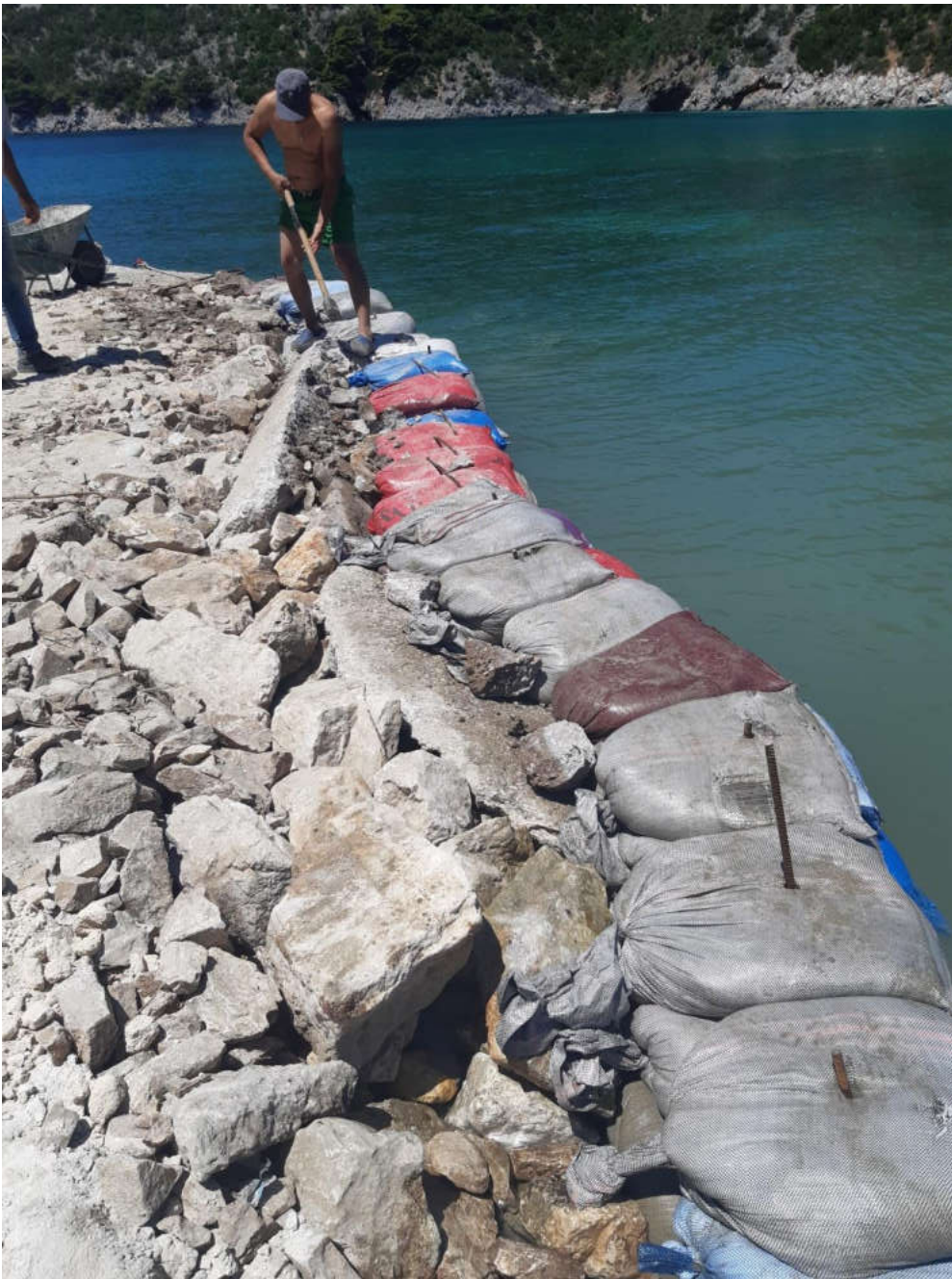
(Εργασίες στην περιοχή Λιμνοάρι)
