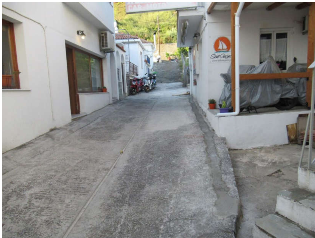
( Κατασκευή αγωγού όμβριων στο Λουτράκι )
