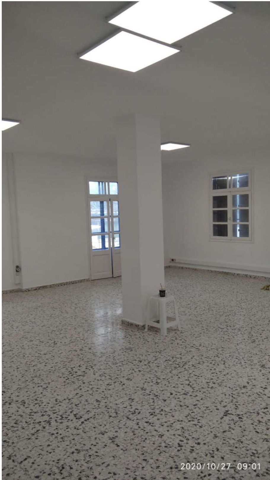
(Εργασίες στο κτίριο ΒΟΥΓΙΑΛΑ - πρώην ΚΑΠΗ)
