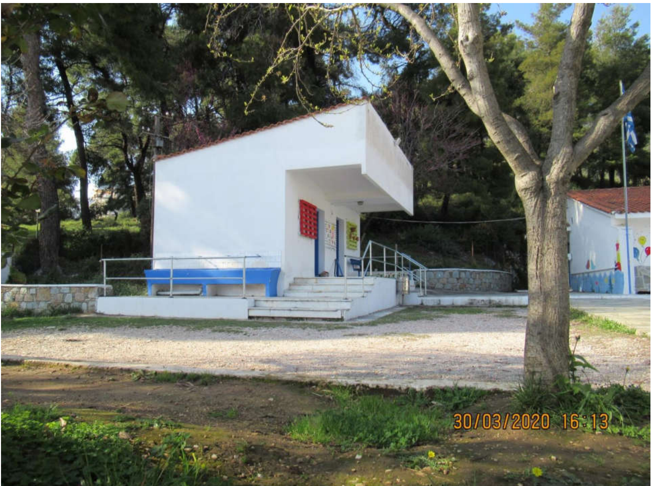
(Σχολείο Ν. Κλήματος μετά την τοποθέτηση κιγκλιδωμάτων ασφαλείας)
