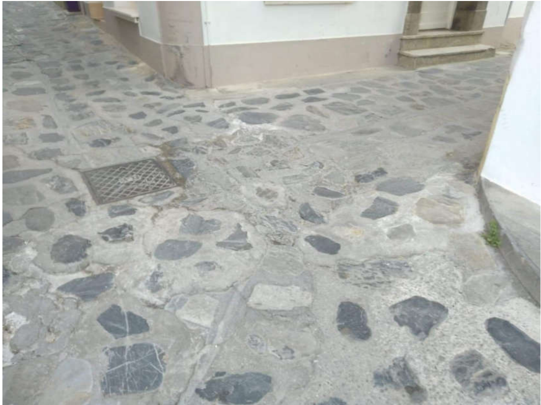
(Εργασίες αποκατάστασης πλακόστρωτου)
