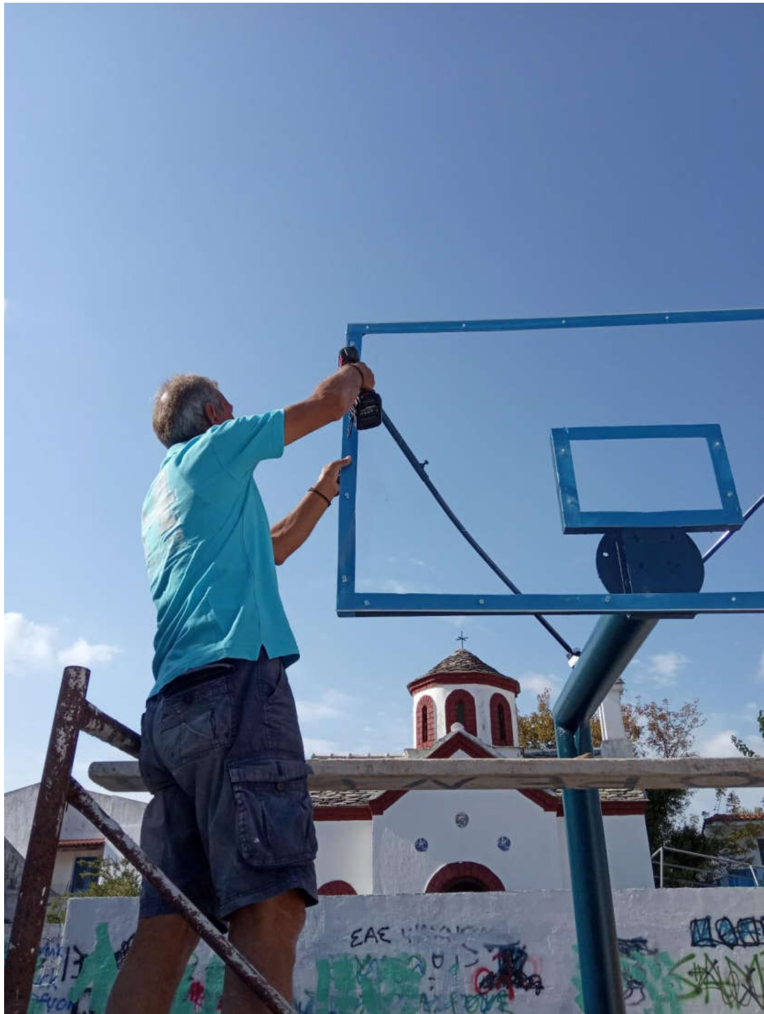
(ΕΠΙΣΚΕΥΗ ΜΠΑΣΚΕΤΑΣ ΣΤΟ ΓΗΠΕΔΟ ΤΗΣ ΣΚΟΠΕΛΟΥ)
