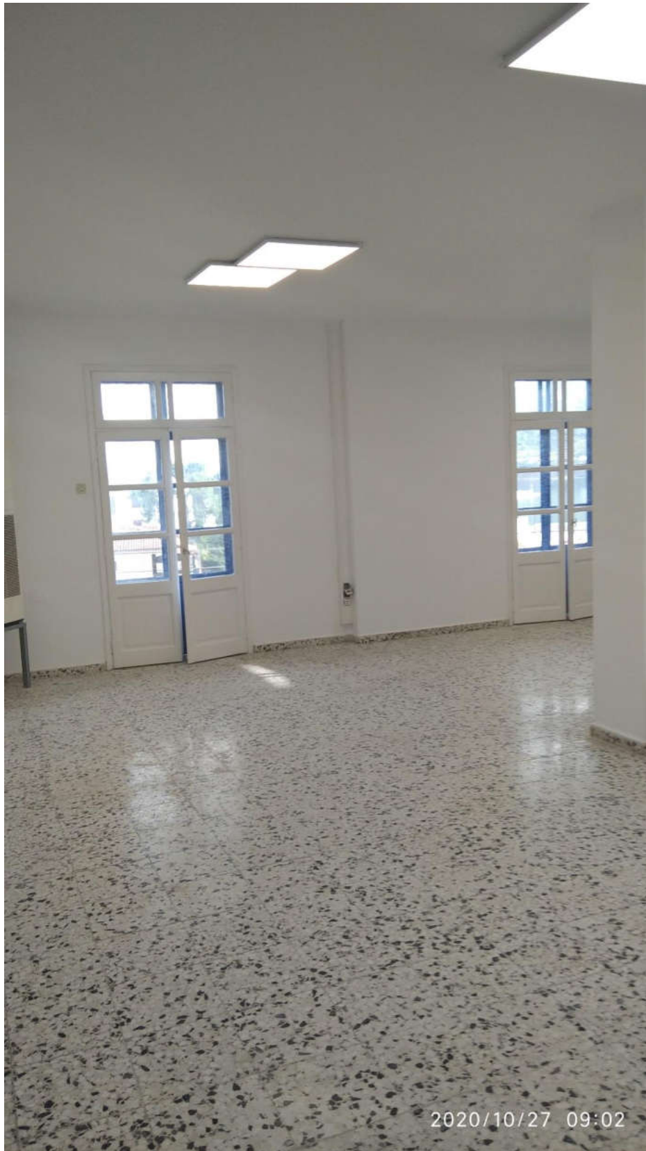
(Εργασίες στο κτίριο ΒΟΥΓΙΑΛΑ - πρώην ΚΑΠΗ)
