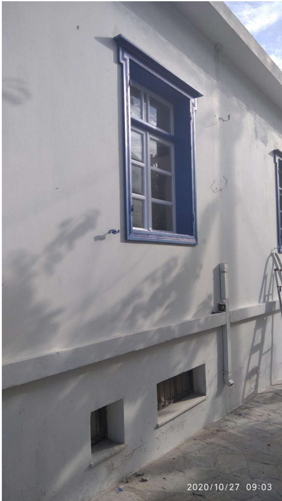
(ΟΛΟΚΛΗΡΩΣΗ ΕΡΓΑΣΙΩΝ ΚΤΙΡΙΟ ΒΟΥΓΙΑΛΑ – ΠΡΩΗΝ ΚΑΠΗ)
