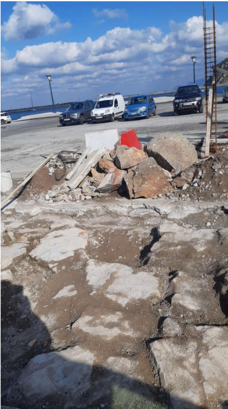
(Εργασίες διαμόρφωσης στο λιμένα Σκοπέλου)
