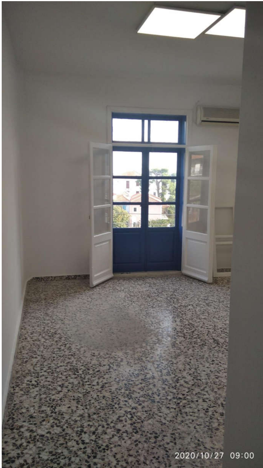
(ΟΛΟΚΛΗΡΩΣΗ ΕΡΓΑΣΙΩΝ ΚΤΙΡΙΟ ΒΟΥΓΙΑΛΑ – ΠΡΩΗΝ ΚΑΠΗ)
