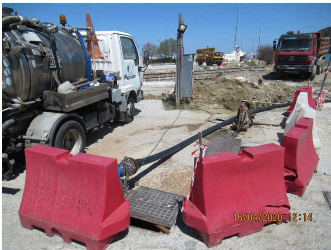
(Εργασίες στο λιμένα Σκοπέλου)
