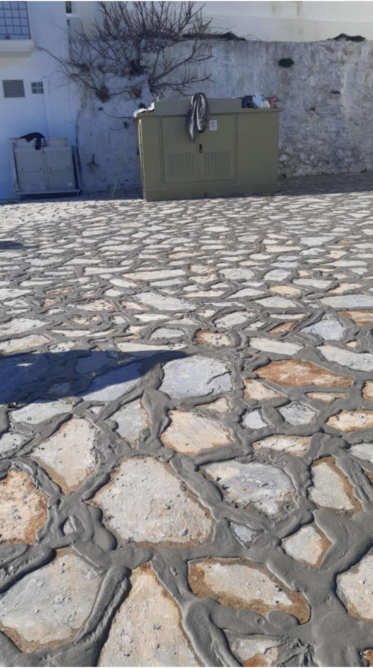
(Εργασίες διαμόρφωσης παραλιακού μετώπου Σκοπέλου )
