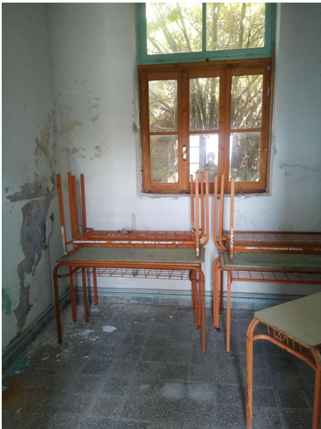
(Δημοτικό σχολείο Παλαιού Κλήματος)
