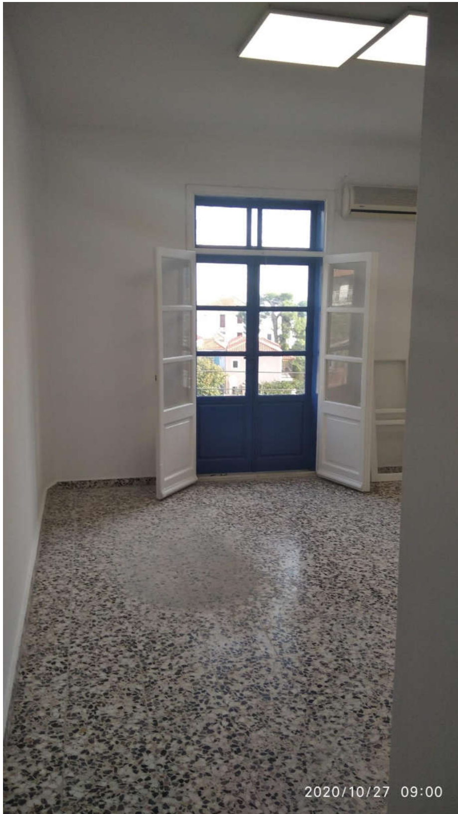
(ΟΛΟΚΛΗΡΩΣΗ ΕΡΓΑΣΙΩΝ ΚΤΙΡΙΟ ΒΟΥΓΙΑΛΑ – ΠΡΩΗΝ ΚΑΠΗ)
