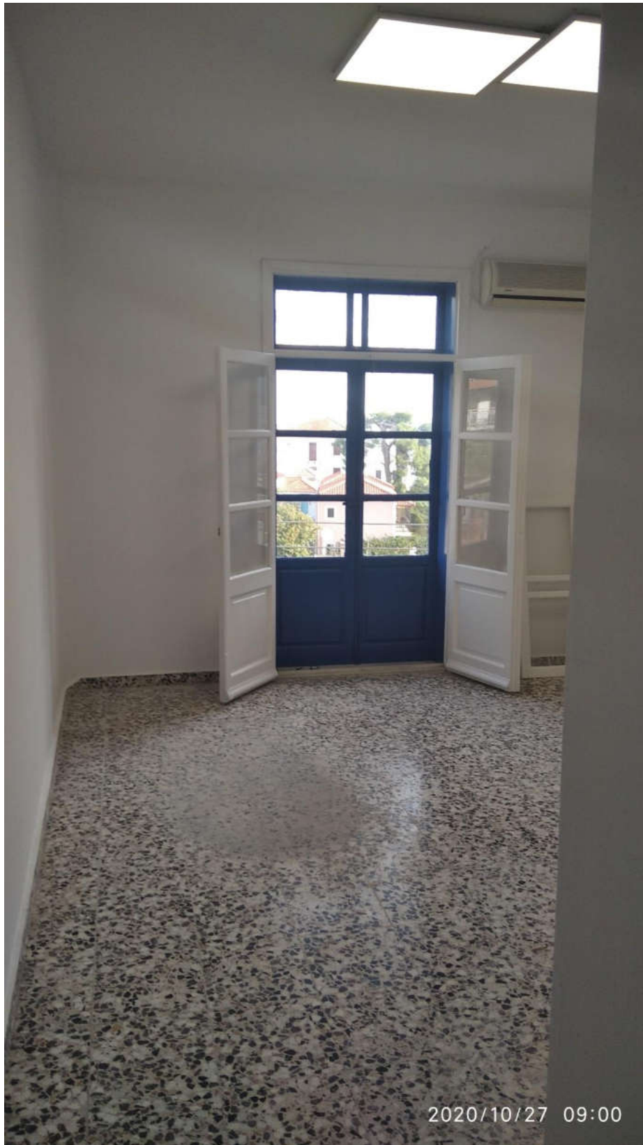
(Εργασίες στο κτίριο ΒΟΥΓΙΑΛΑ - πρώην ΚΑΠΗ)
