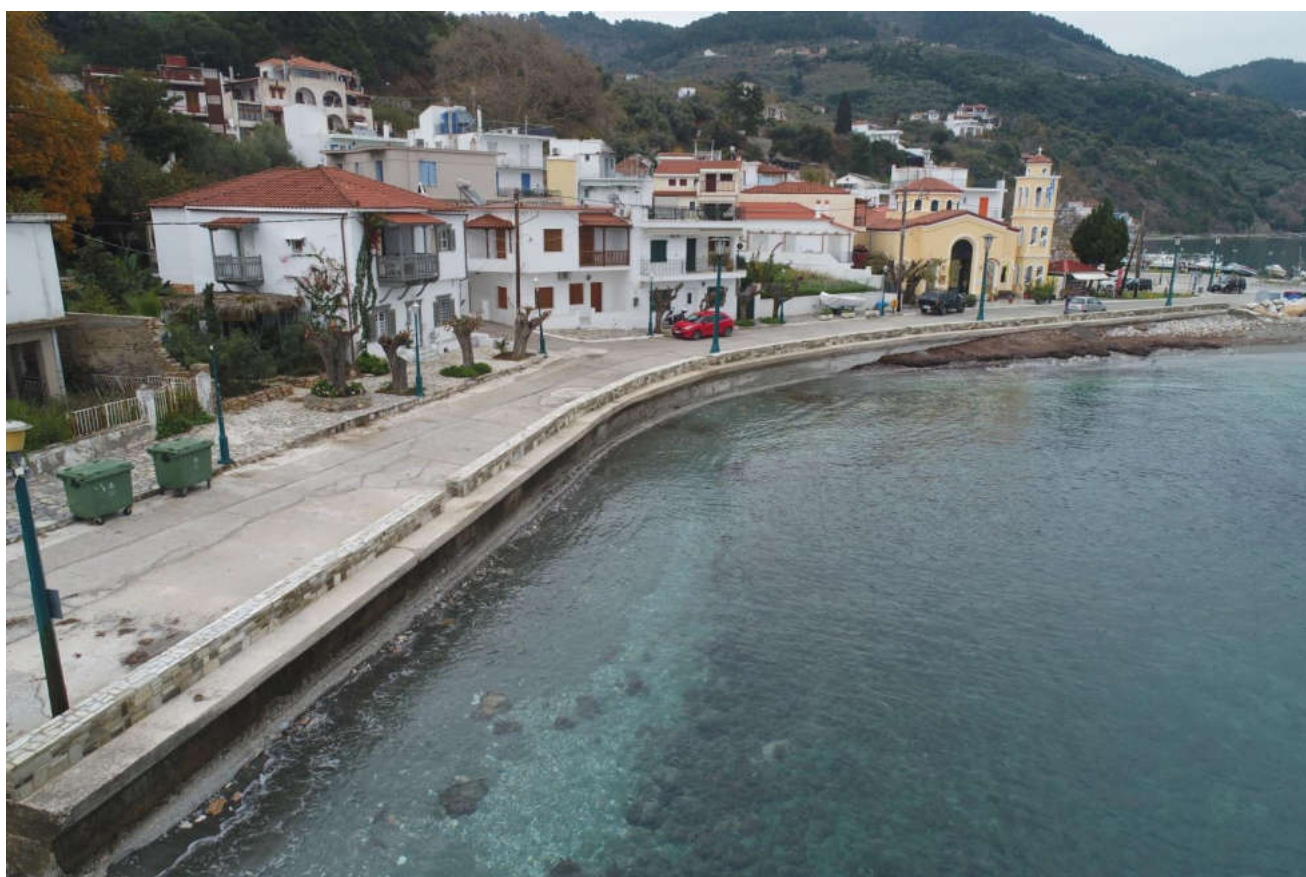
(Κατασκευή τοιχίου προστασίας έμπροσθεν Αγ. Νικολάου στην περιοχή Λουτρακίου)
