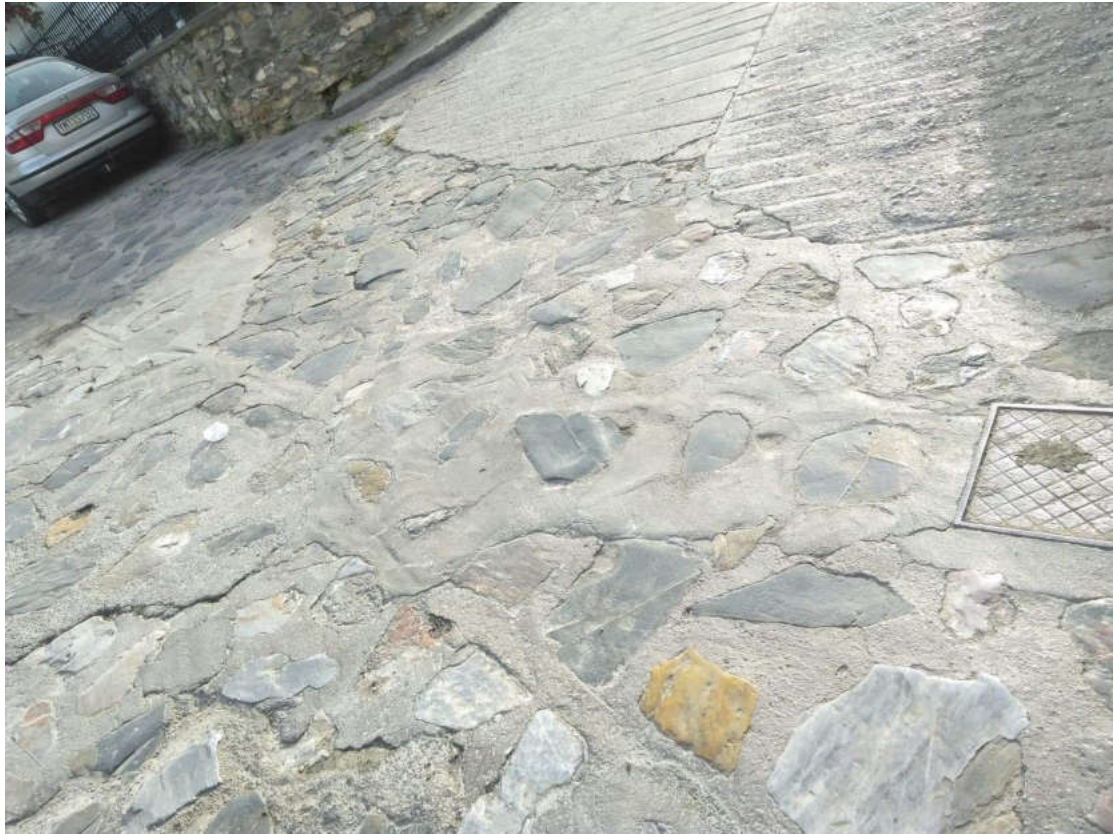
(Εργασίες αποκατάστασης πλακόστρωτου)
