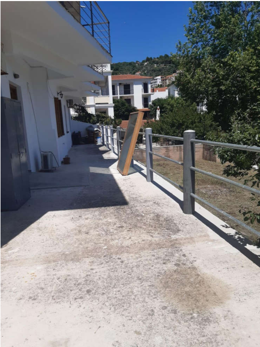
(Εργασίες στο κτίριο του ΚΑΠΗ)
