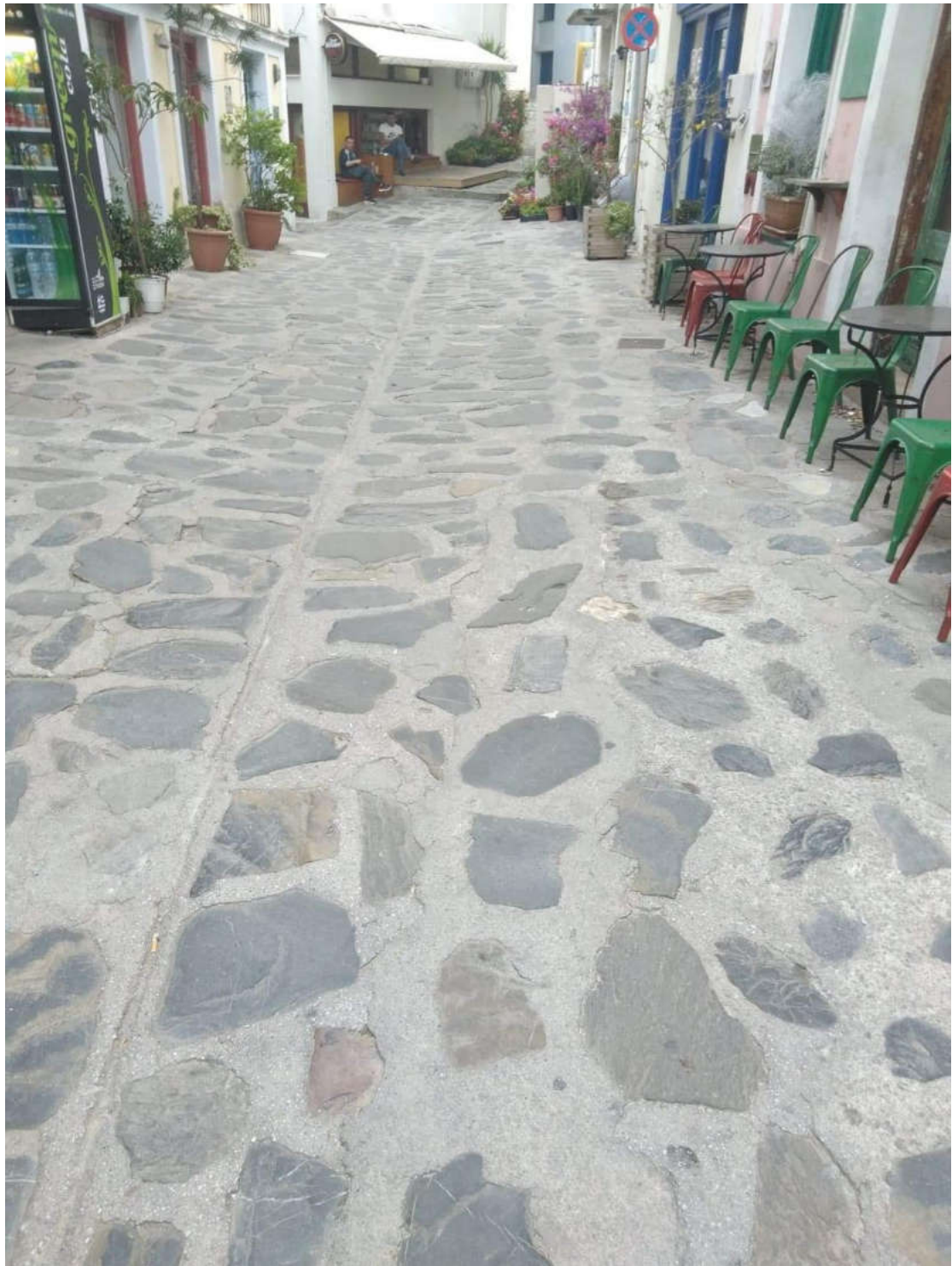
(Εργασίες αποκατάστασης πλακόστρωτου)
