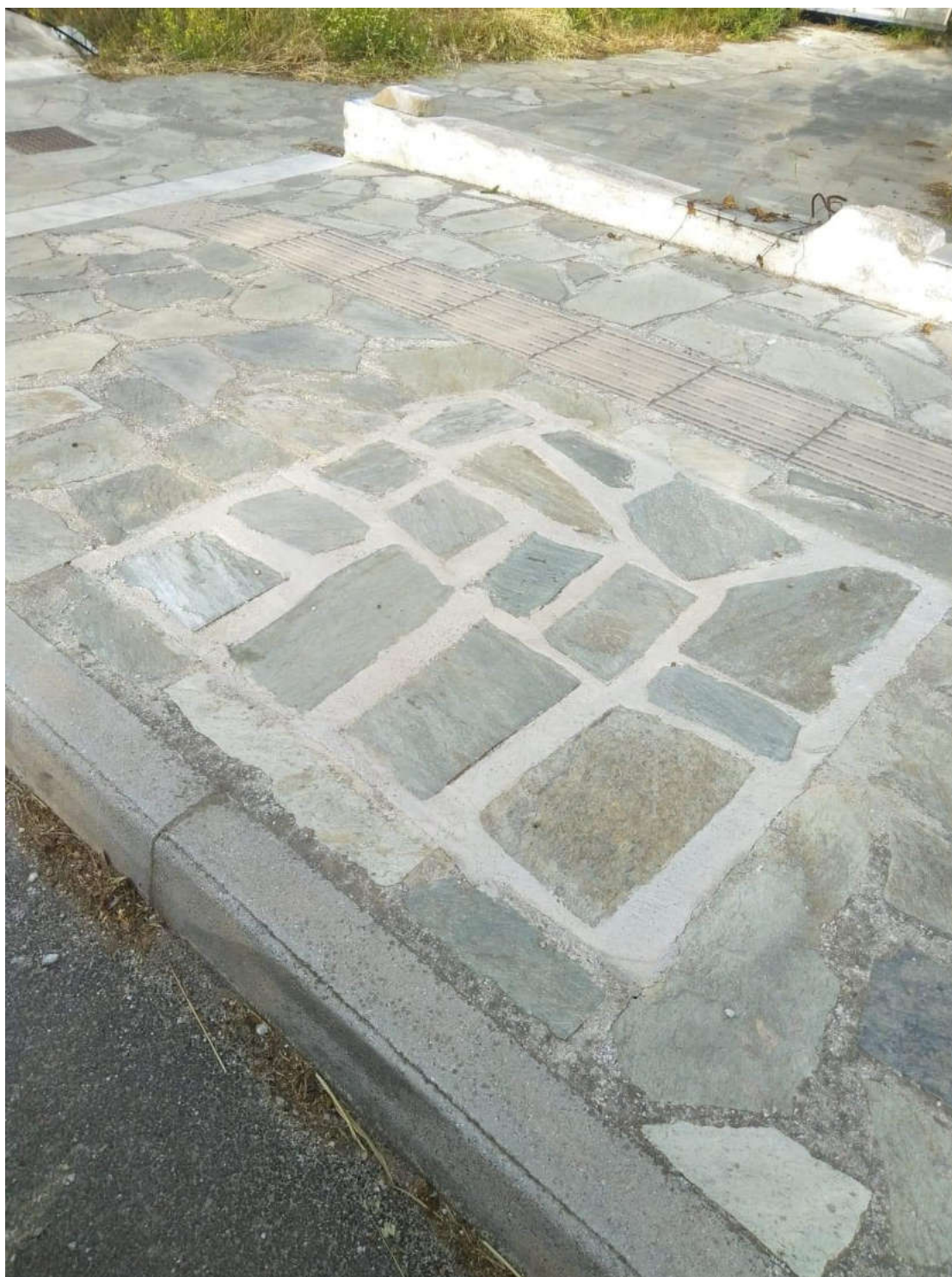
(Εργασίες αποκατάστασης πεζόδρομου)
