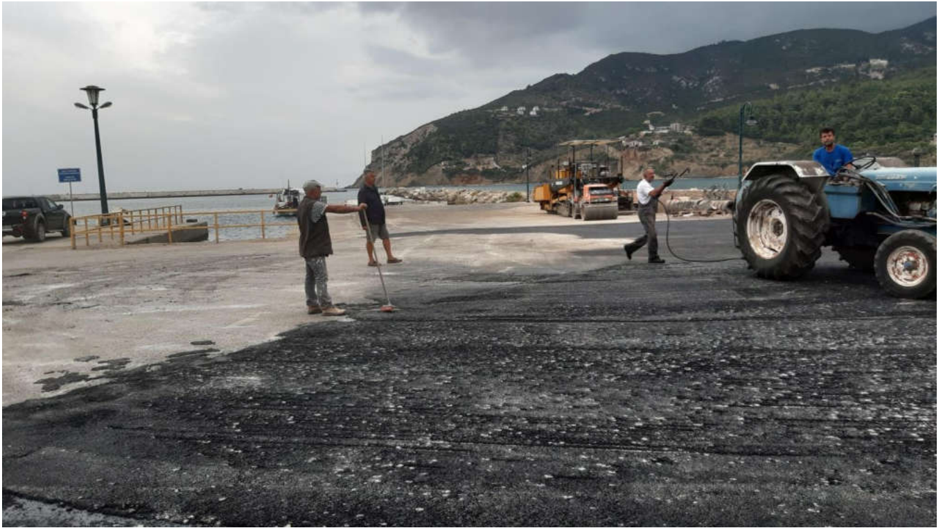
(Εργασίες στο λιμένα Σκοπέλου)
