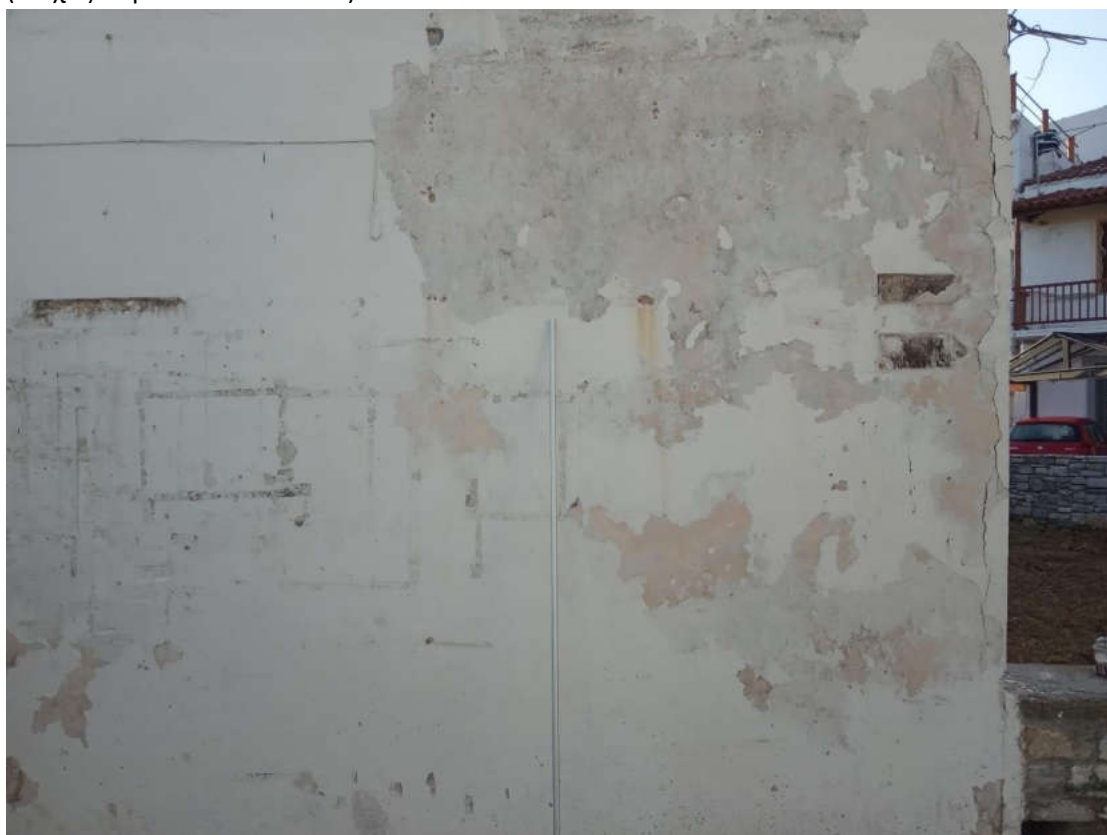
(Τοίχος κτιρίου ΞΕΝΙΑ- ΠΡΙΝ)
