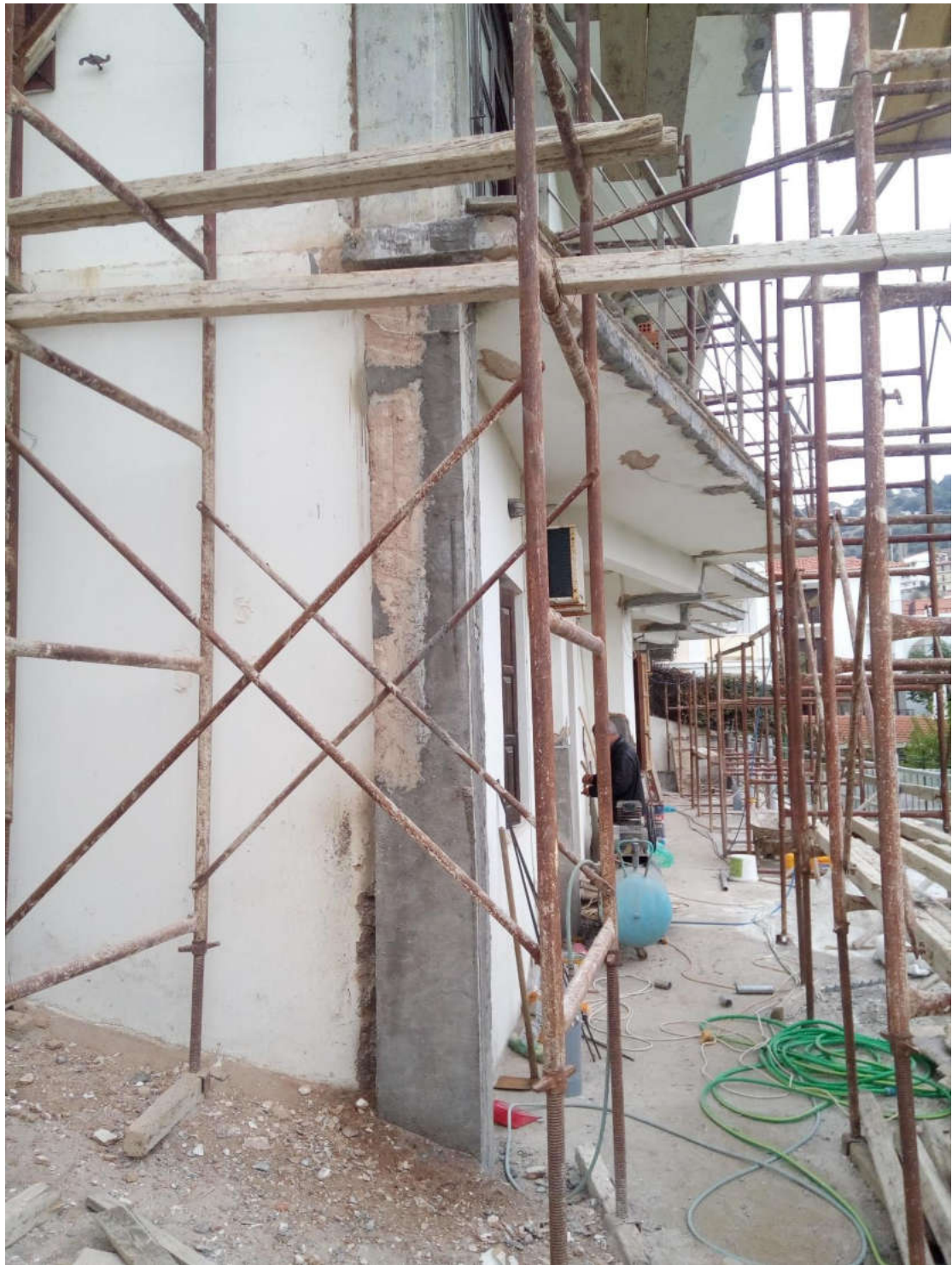
(Εργασίες πρώην στο κτίριο του ΚΑΠΗ)
