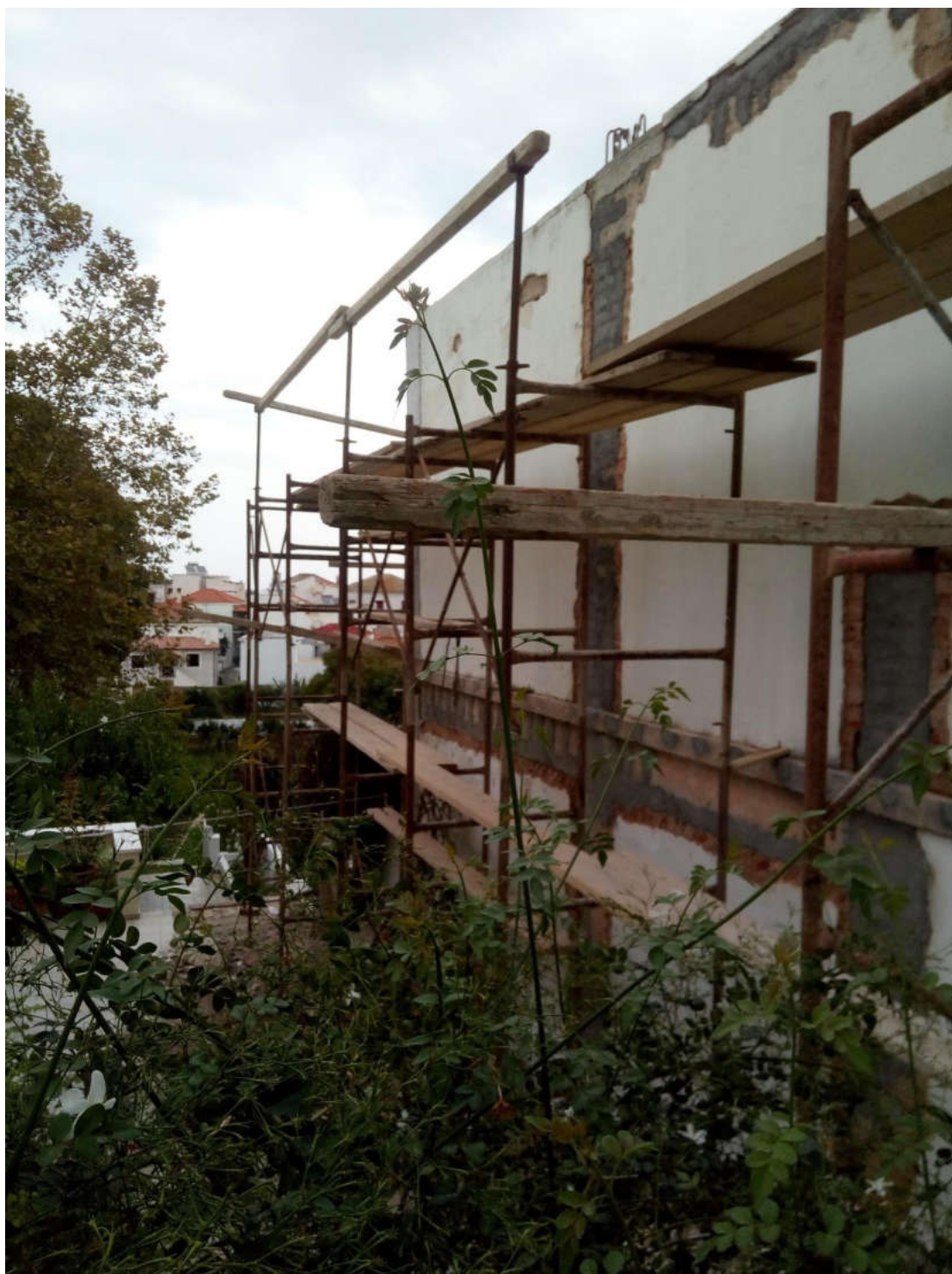
(Εργασίες πρώην στο κτίριο του ΚΑΠΗ)
