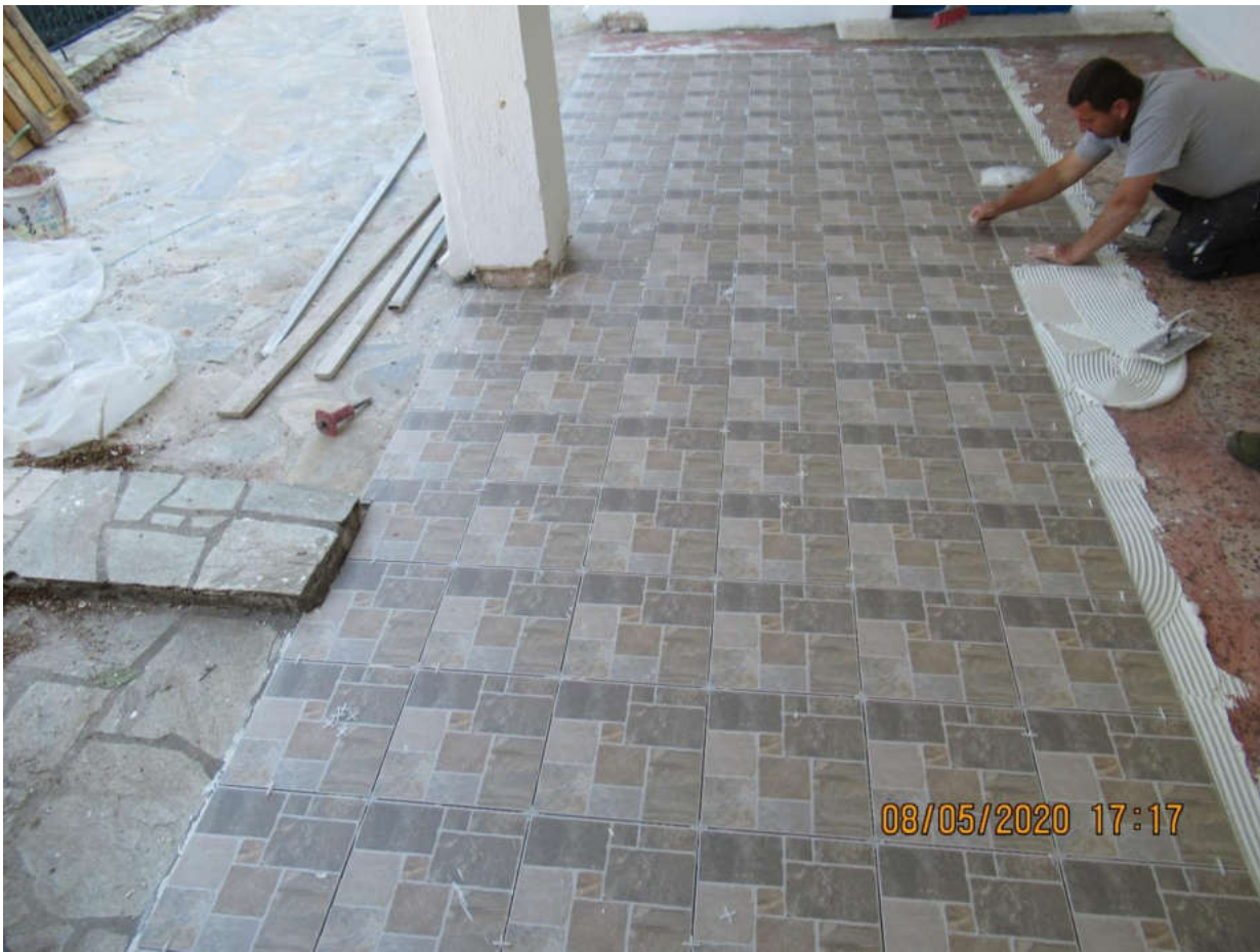
(Εργασίες στο Ιατρείο του Νέου κλήματος)
