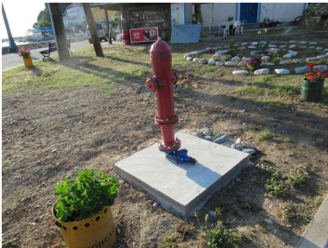
( Τοποθέτηση ΝΕΟΥ Πυροσβεστικού κρουνού στο λιμένα του Λουτρακίου )
