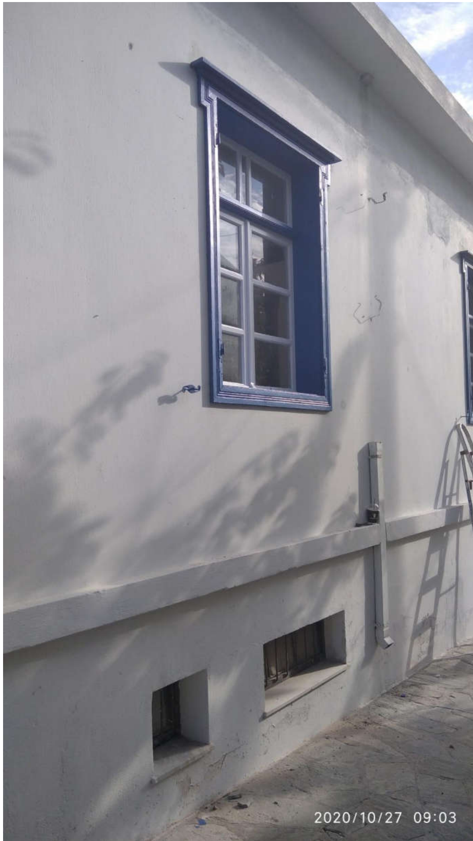
(Εργασίες στο κτίριο ΒΟΥΓΙΑΛΑ - πρώην ΚΑΠΗ)
