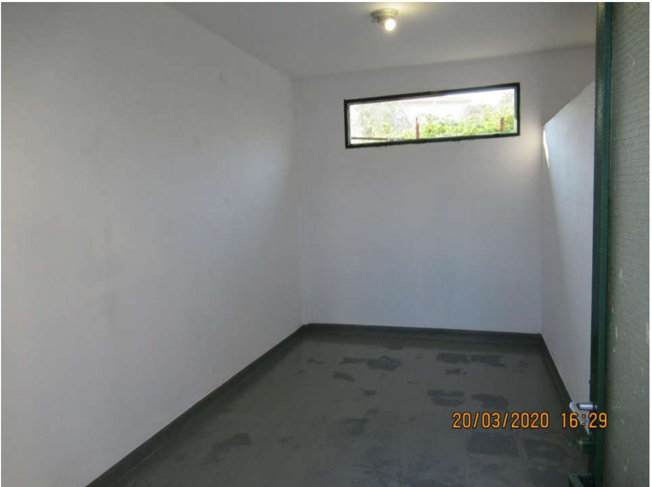
(Μετά - Κτίριο πλησίον Κέντρου υγείας Σκοπέλου)
