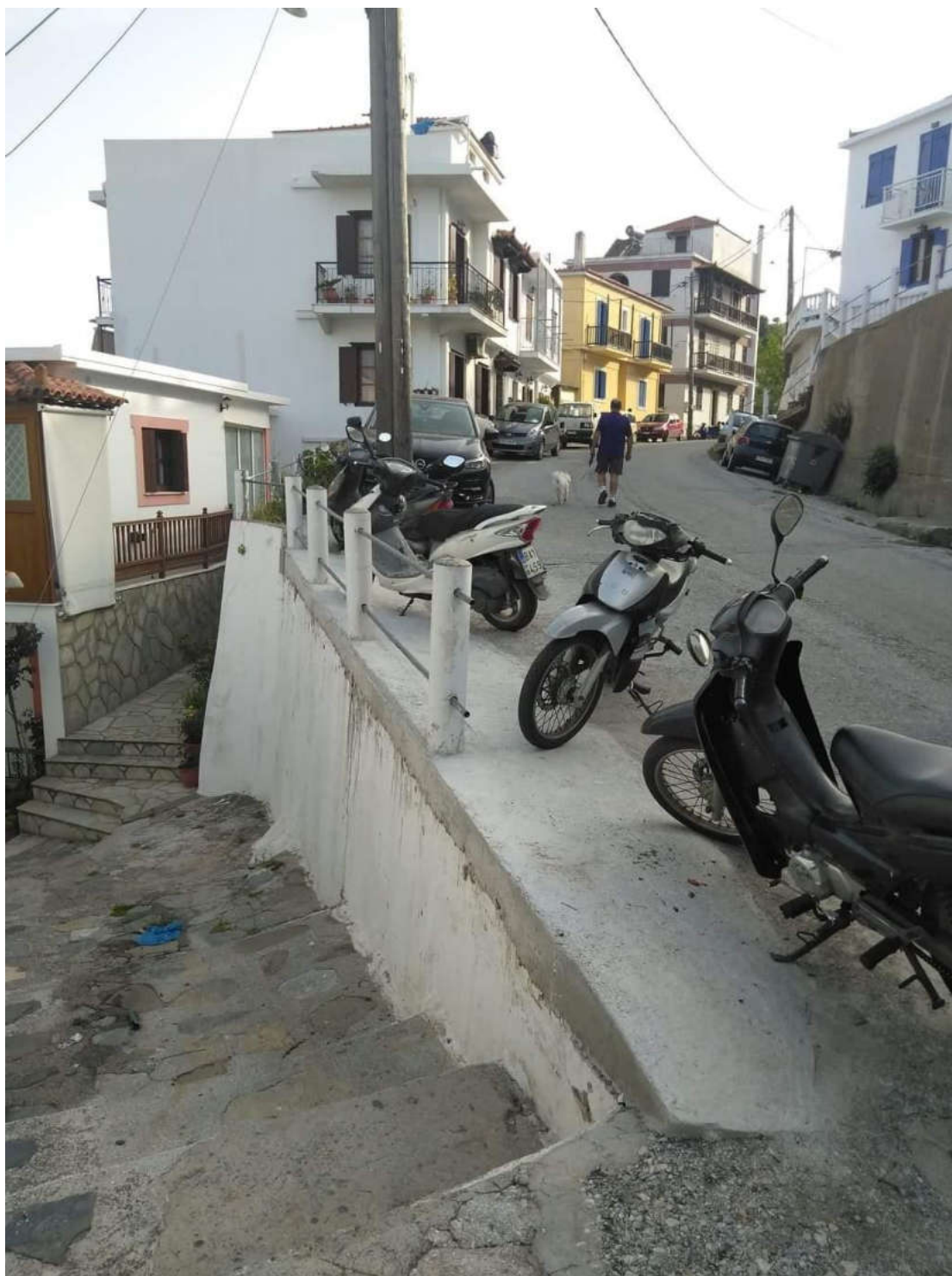
(Εργασίες αποκατάστασης πλακόστρωτου)
