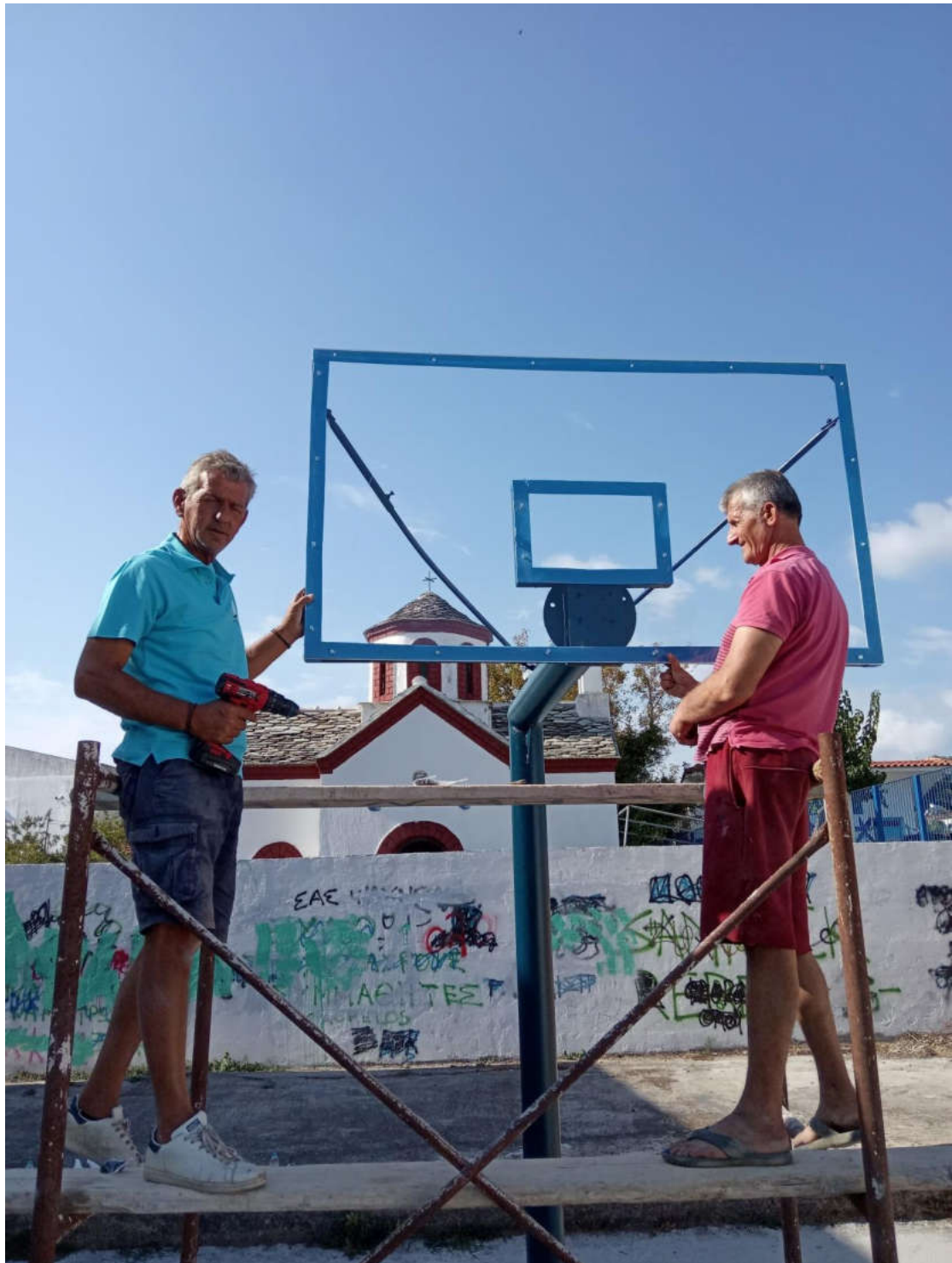
(ΕΠΙΣΚΕΥΗ ΜΠΑΣΚΕΤΑΣ ΣΤΟ ΓΗΠΕΔΟ ΤΗΣ ΣΚΟΠΕΛΟΥ)
