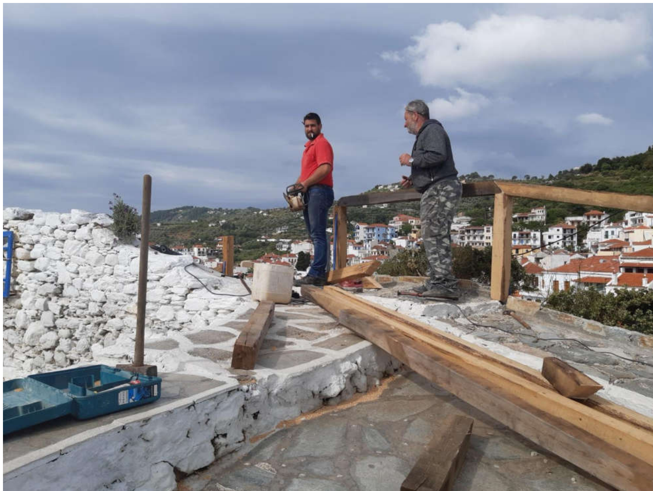
(Εργασίες στην περιοχή του Κάστρου)
