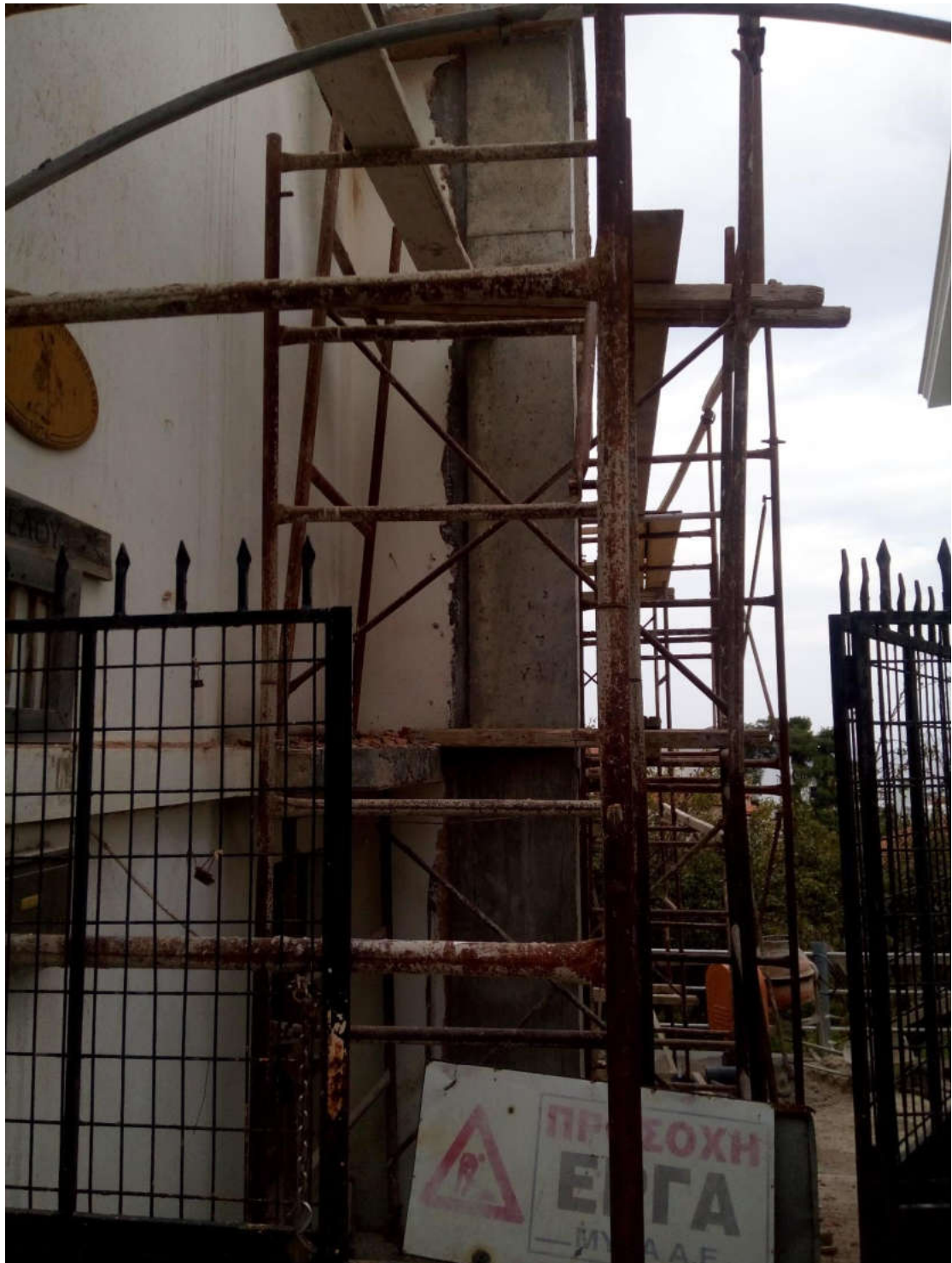
(Εργασίες πρώην στο κτίριο του ΚΑΠΗ)
