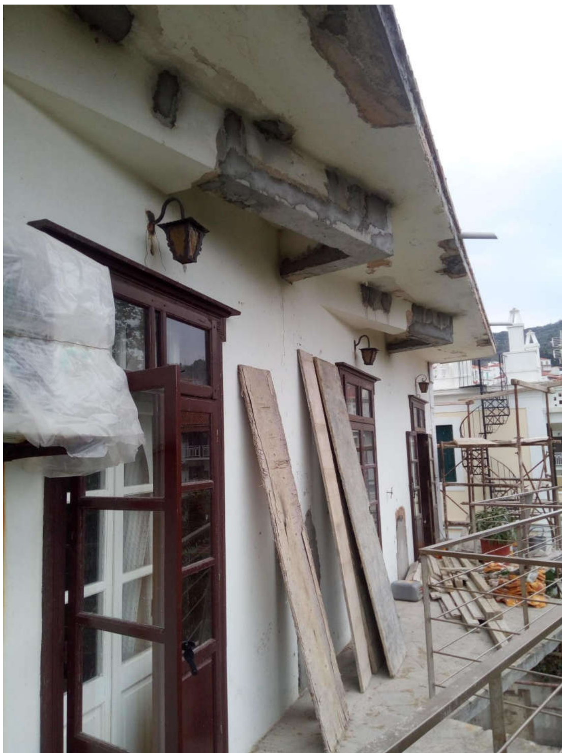
(Εργασίες πρώην στο κτίριο του ΚΑΠΗ)
