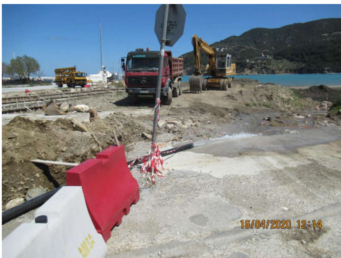
(Εργασίες στο λιμένα Σκοπέλου)
