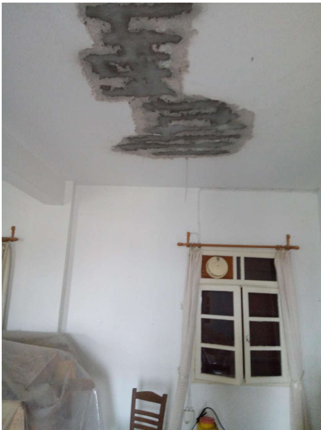
(Εργασίες πρώην στο κτίριο του ΚΑΠΗ)
