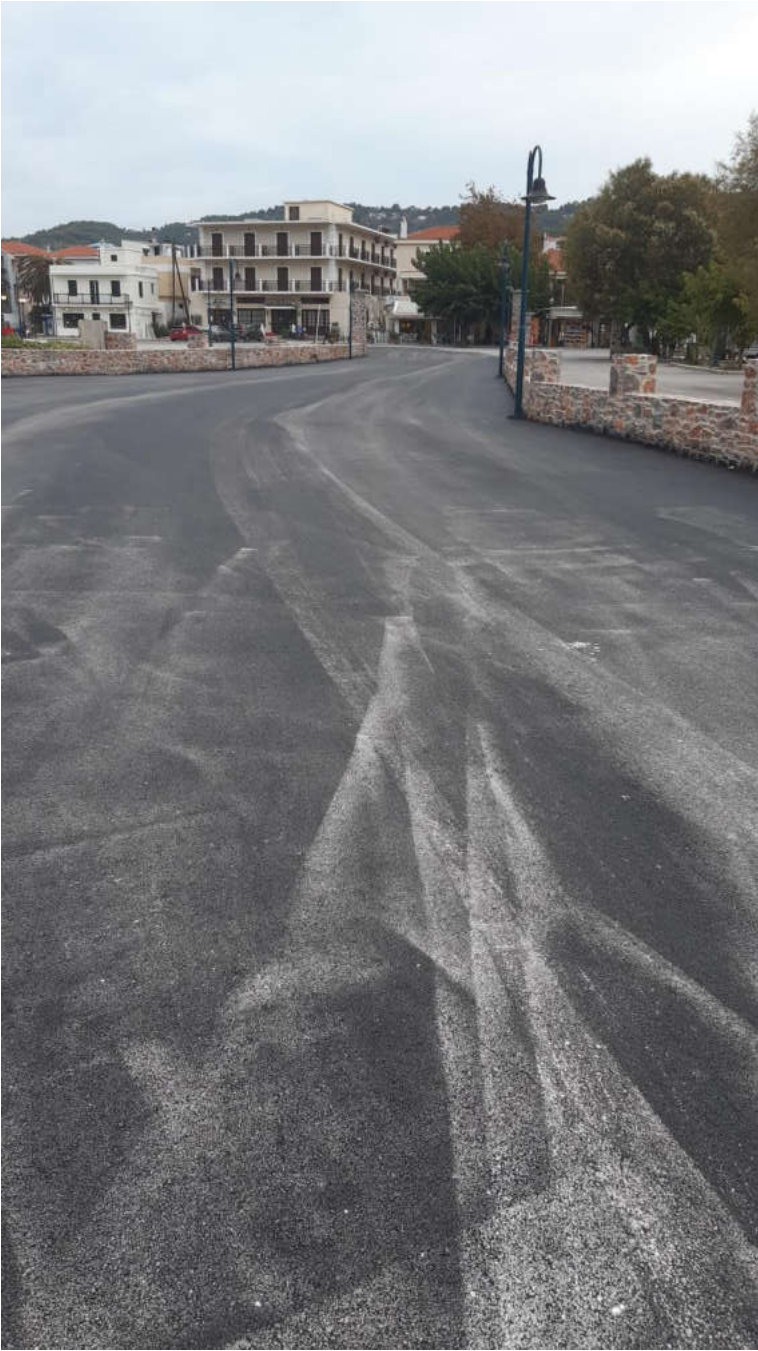
(Εργασίες στο λιμένα Σκοπέλου)
