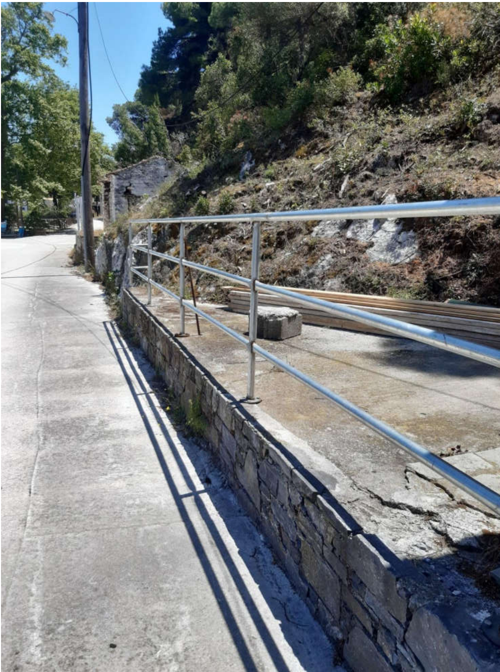
(Τοποθέτηση κιγκλιδωμάτων στον Αγνώντα)
