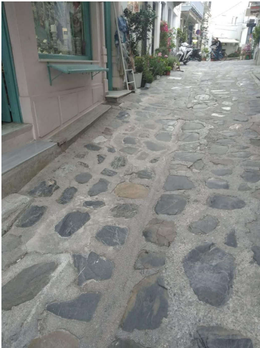
(Εργασίες αποκατάστασης πλακόστρωτου)
