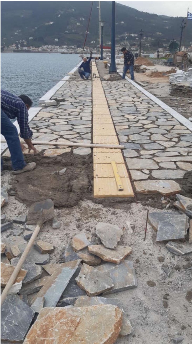
(Εργασίες διαμόρφωσης παραλιακού μετώπου Σκοπέλου)
