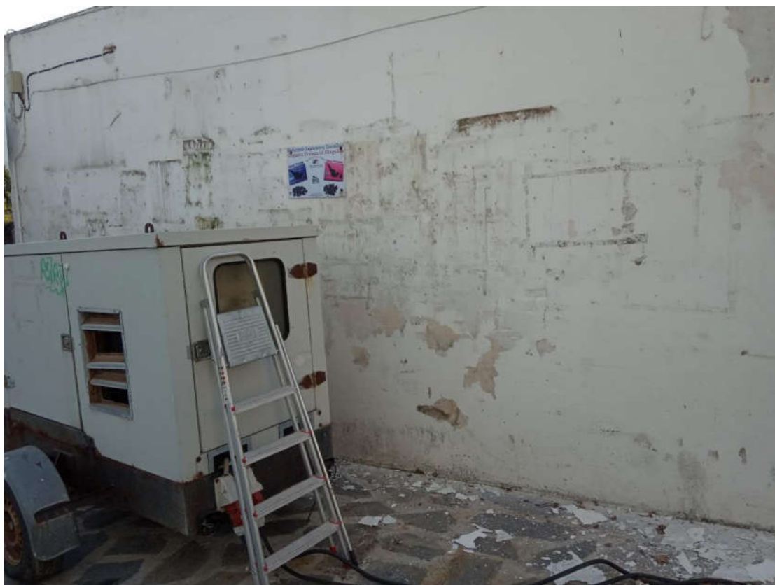
(Τοίχος κτιρίου ΞΕΝΙΑ - ΠΡΙΝ)
