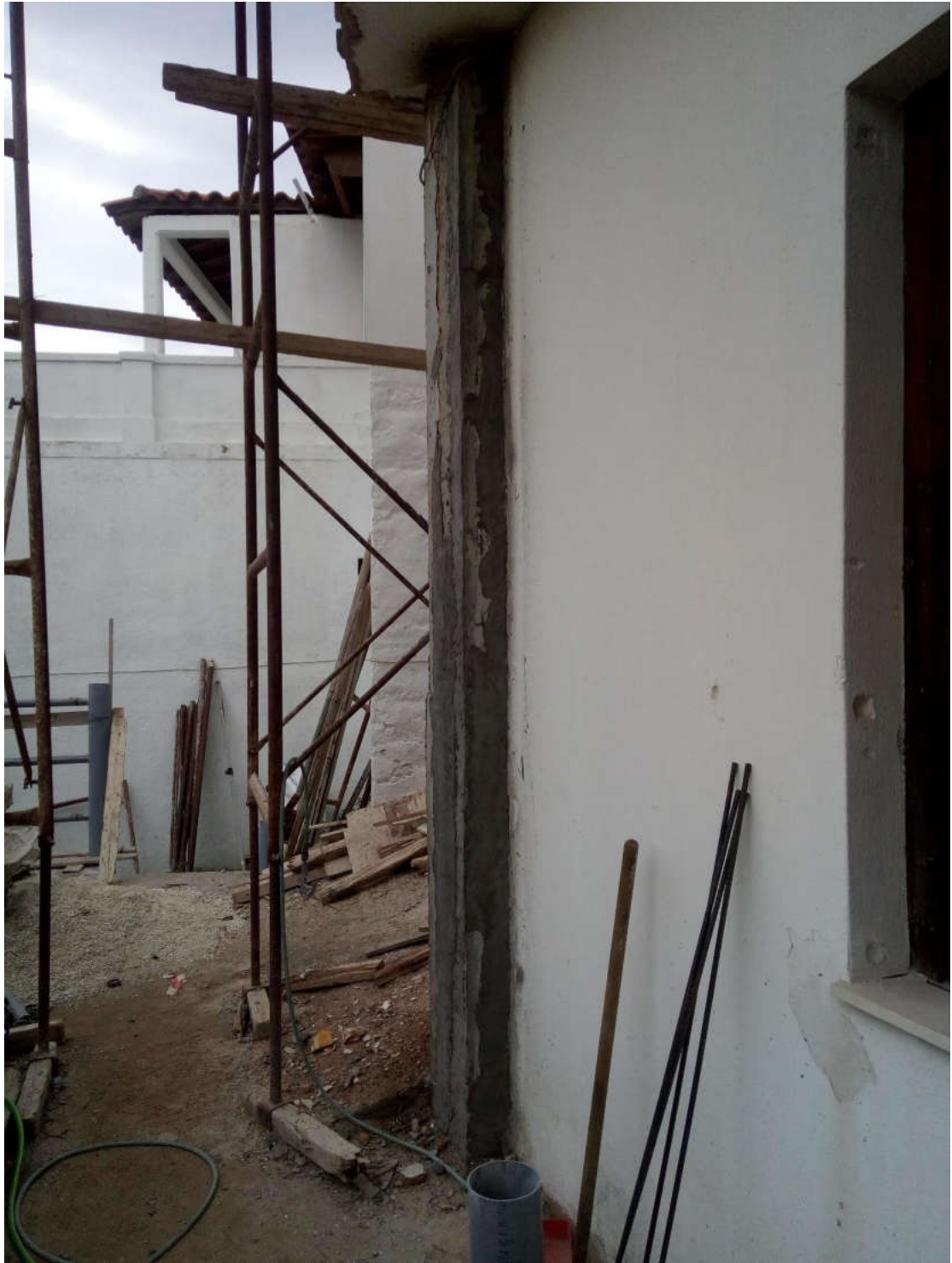
(Εργασίες πρώην στο κτίριο του ΚΑΠΗ)
