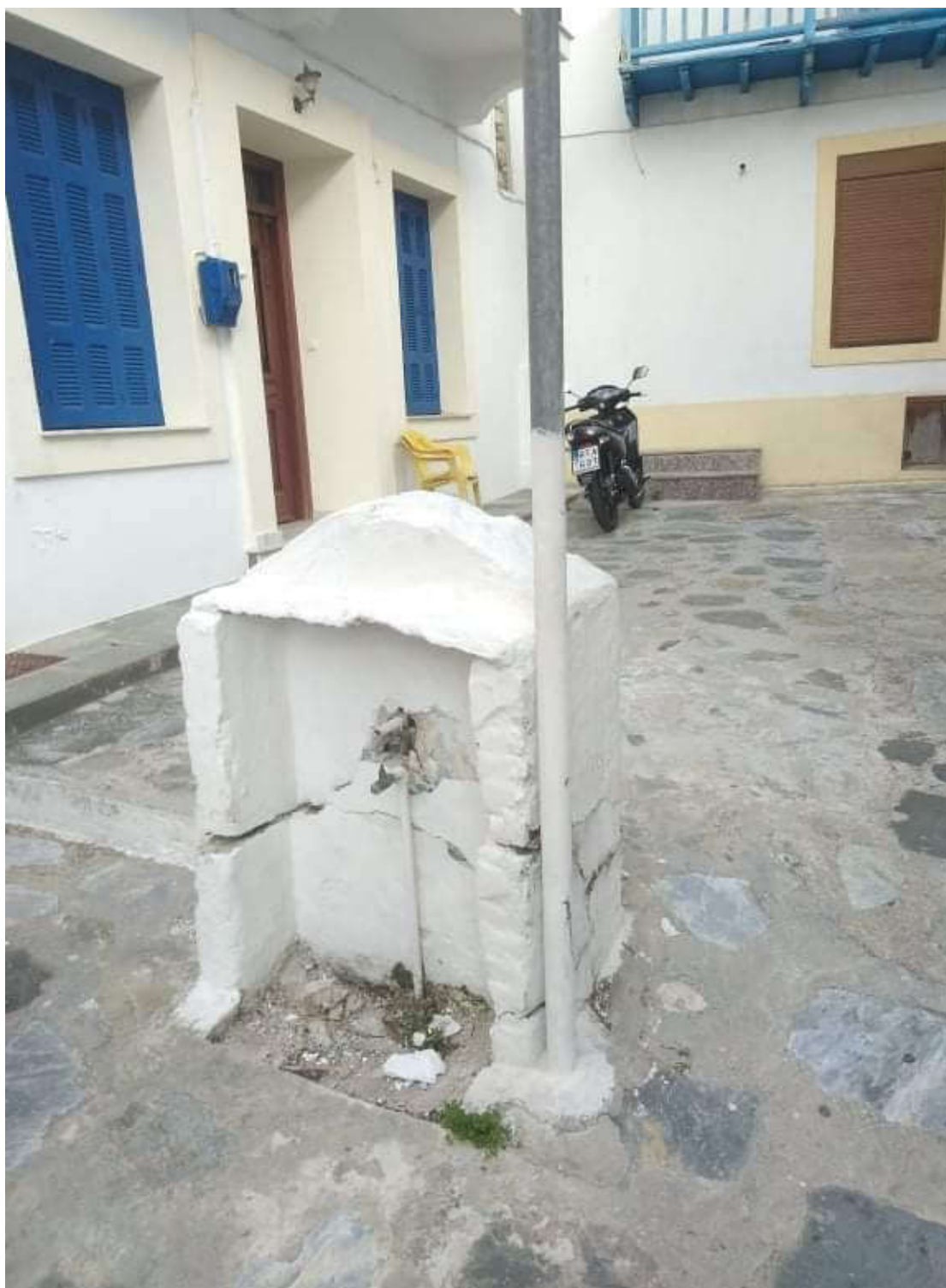
(Βρύση στον οικισμό της Σκοπέλου - ΠΡΙΝ)
