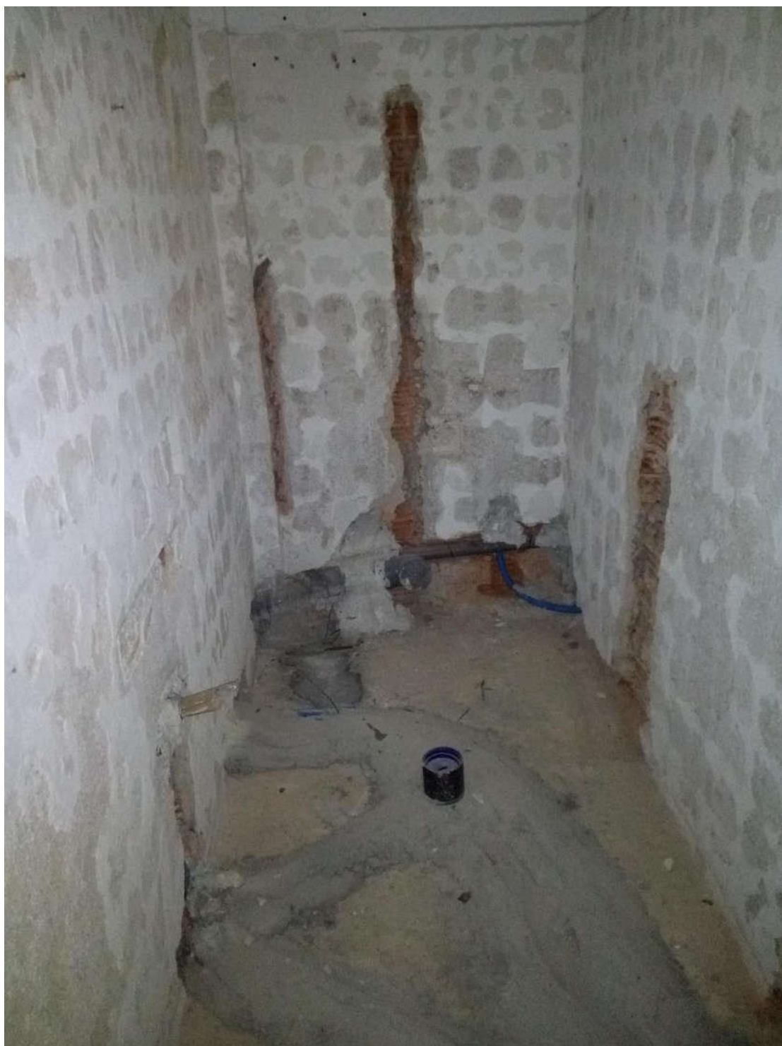
(Εργασίες πρώην στο κτίριο του ΚΑΠΗ)
