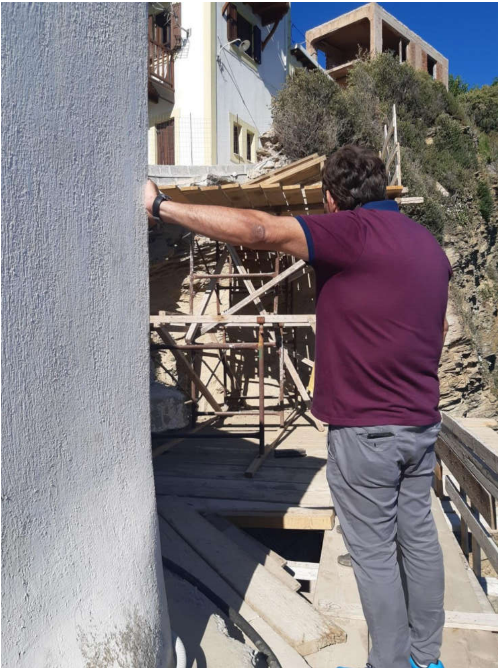
(Εργασίες στον Αγ. Νικόλαο, περιοχή Κάστρου Σκοπέλου)
