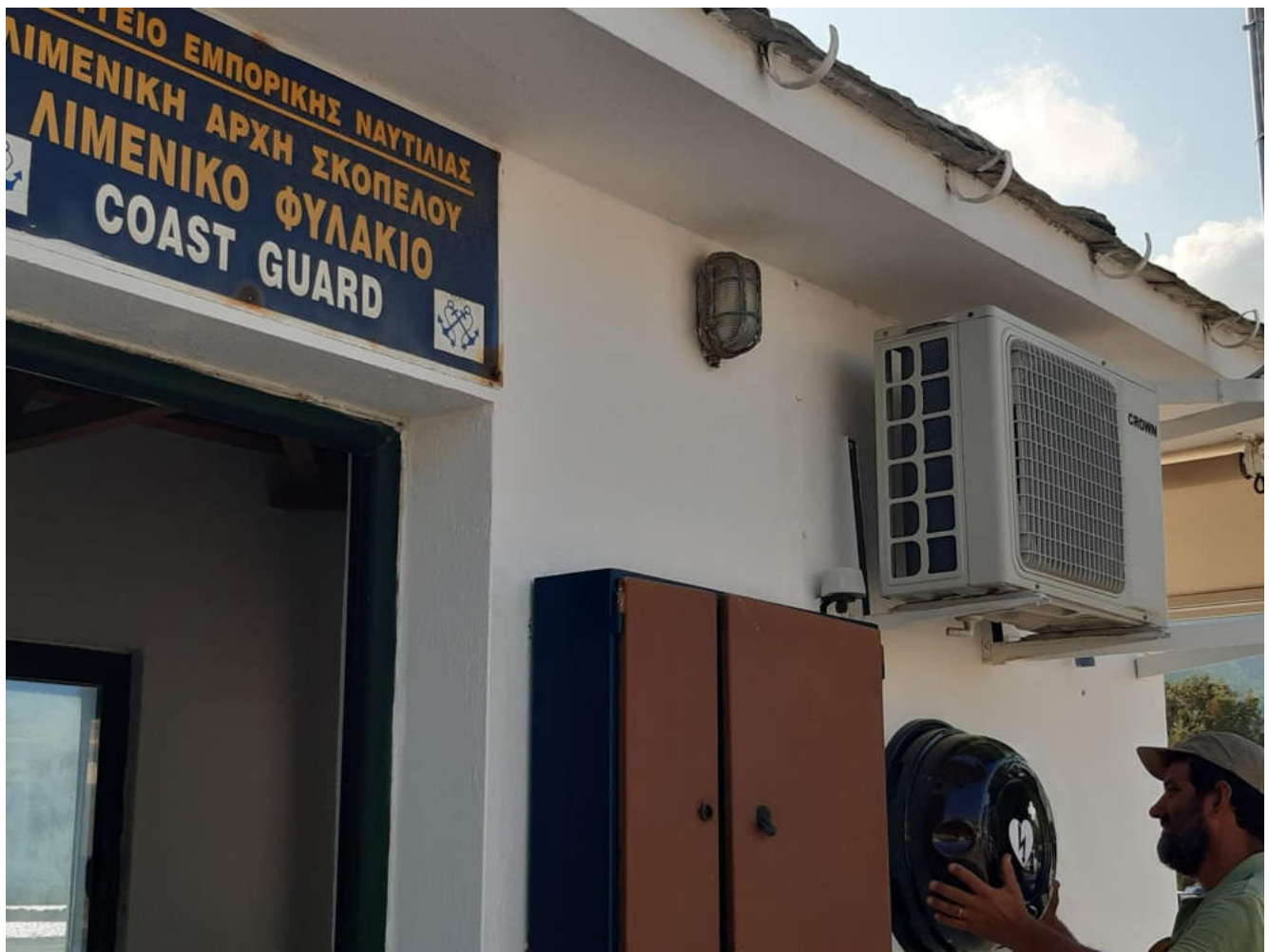
(Τοποθέτηση Απινιδωτή στο Λιμενικό Φυλάκιο Λουτρακίου)
