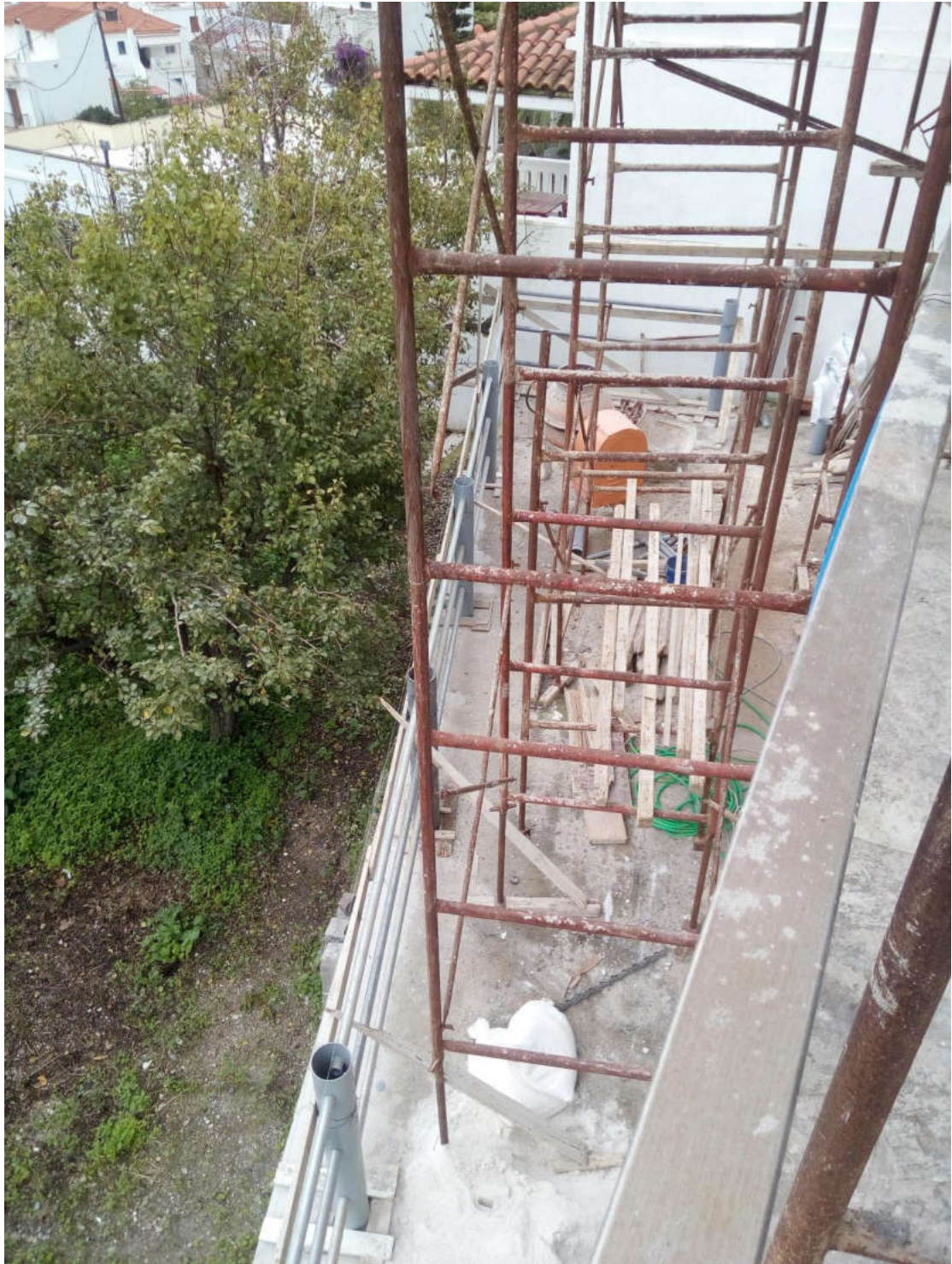
(Εργασίες πρώην στο κτίριο του ΚΑΠΗ)
