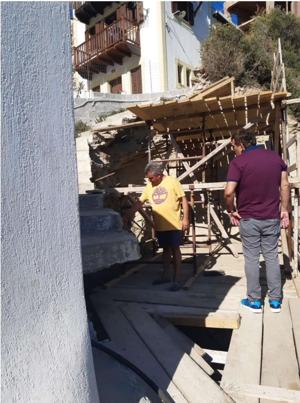
(Εργασίες στον Αγ. Νικόλαο, περιοχή Κάστρου Σκοπέλου)
