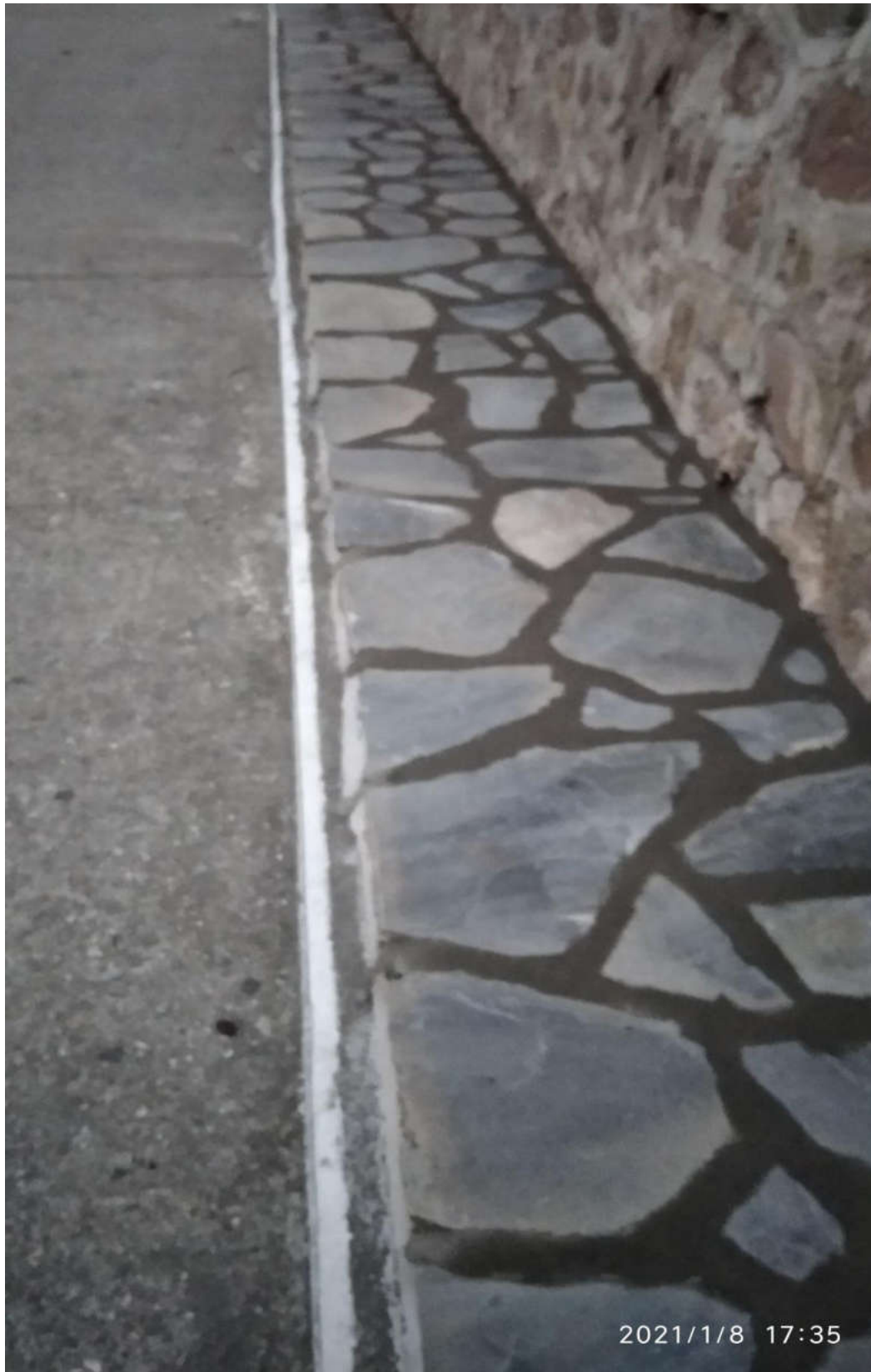
(Εργασίες στο λιμένα Λουτρακίου)
