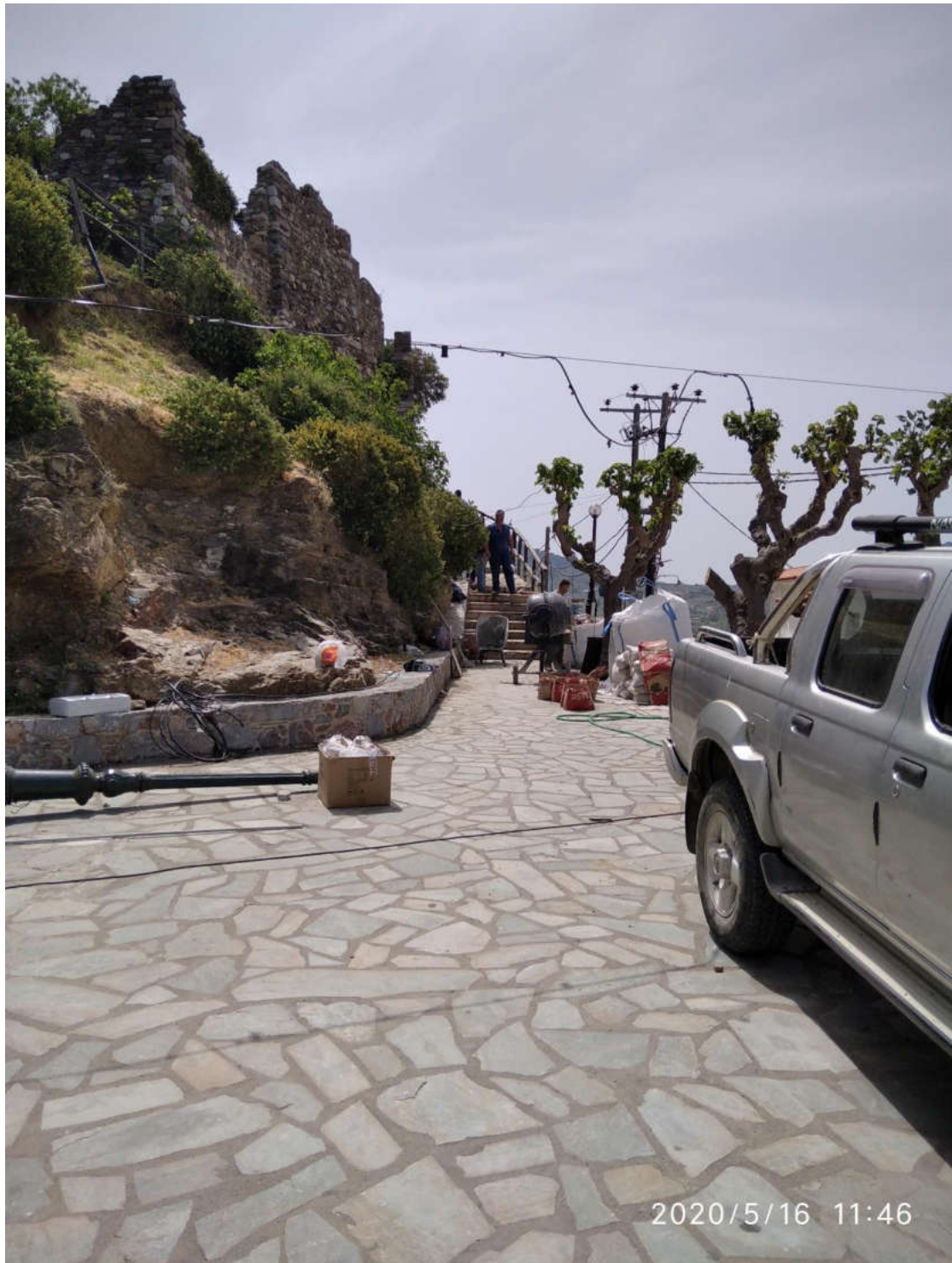
(ΗΛΕΚΤΡΟΛΟΓΙΚΕΣ ΕΡΓΑΣΙΕΣ ΚΑΣΤΡΟ)
