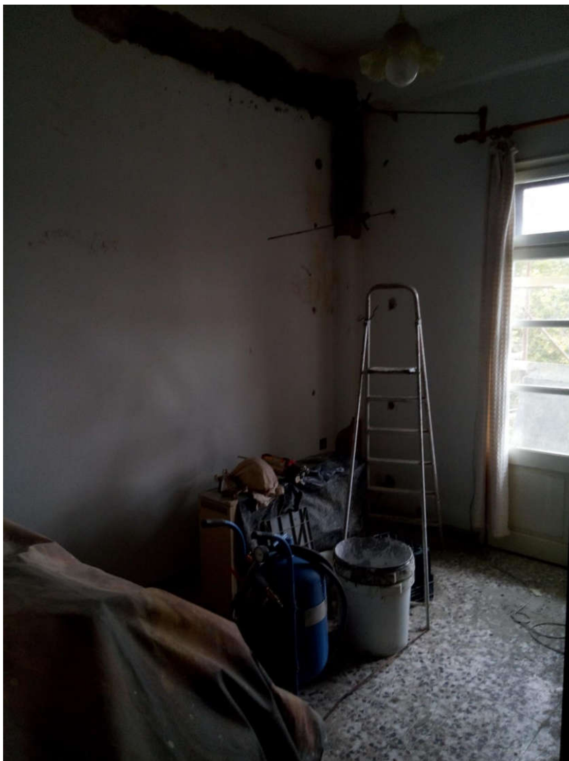
(Εργασίες πρώην στο κτίριο του ΚΑΠΗ)
