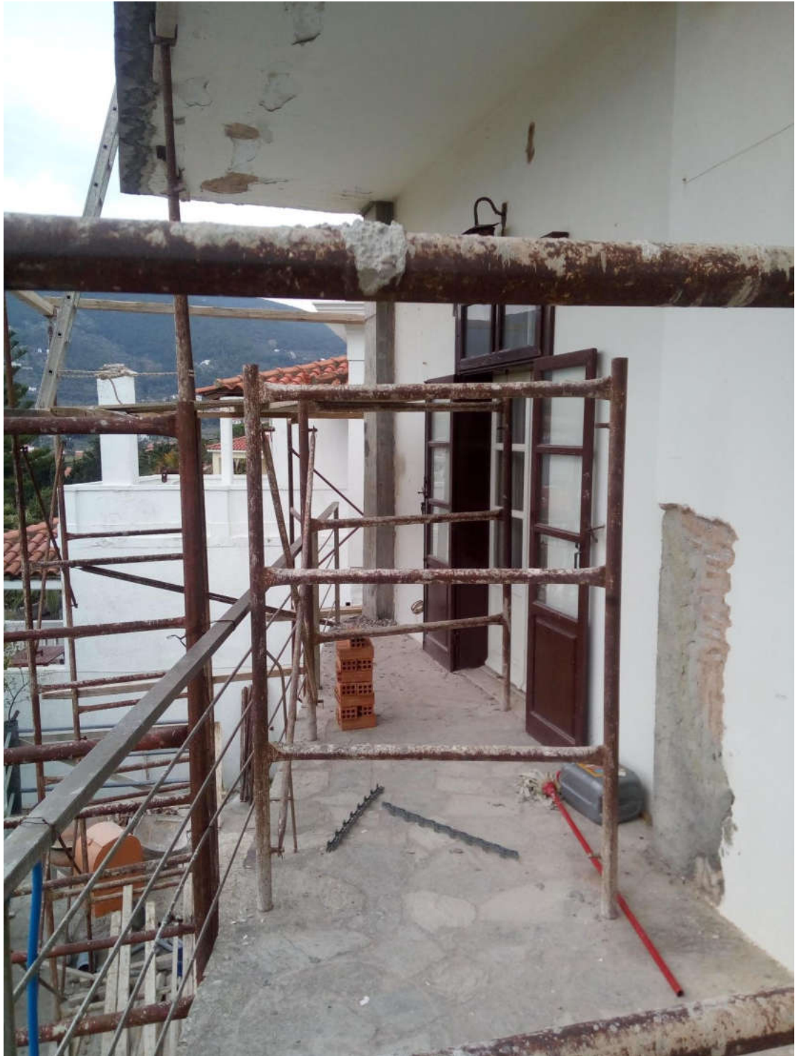
(Εργασίες πρώην στο κτίριο του ΚΑΠΗ)
