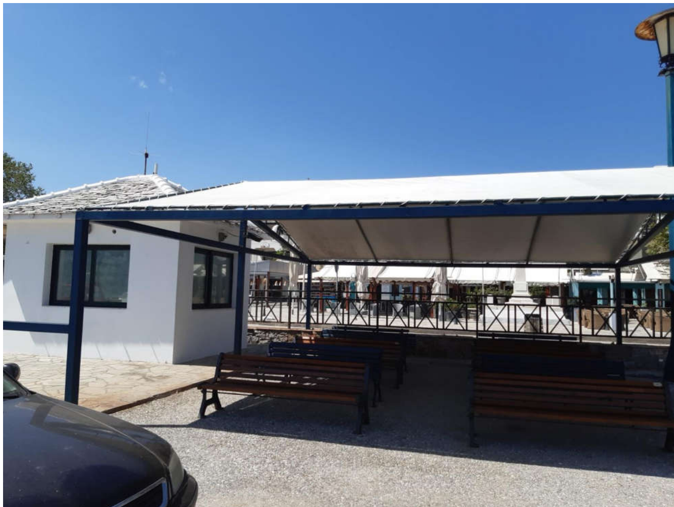
(Τοποθέτηση καινούργιων παγκακιών στο χώρο αναμονής των επιβατών του Λιμένα Σκοπέλου)
