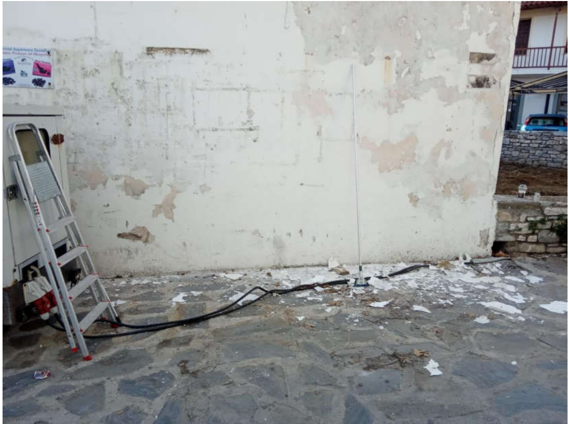
(Τοίχος κτιρίου ΞΕΝΙΑ- ΠΡΙΝ)
