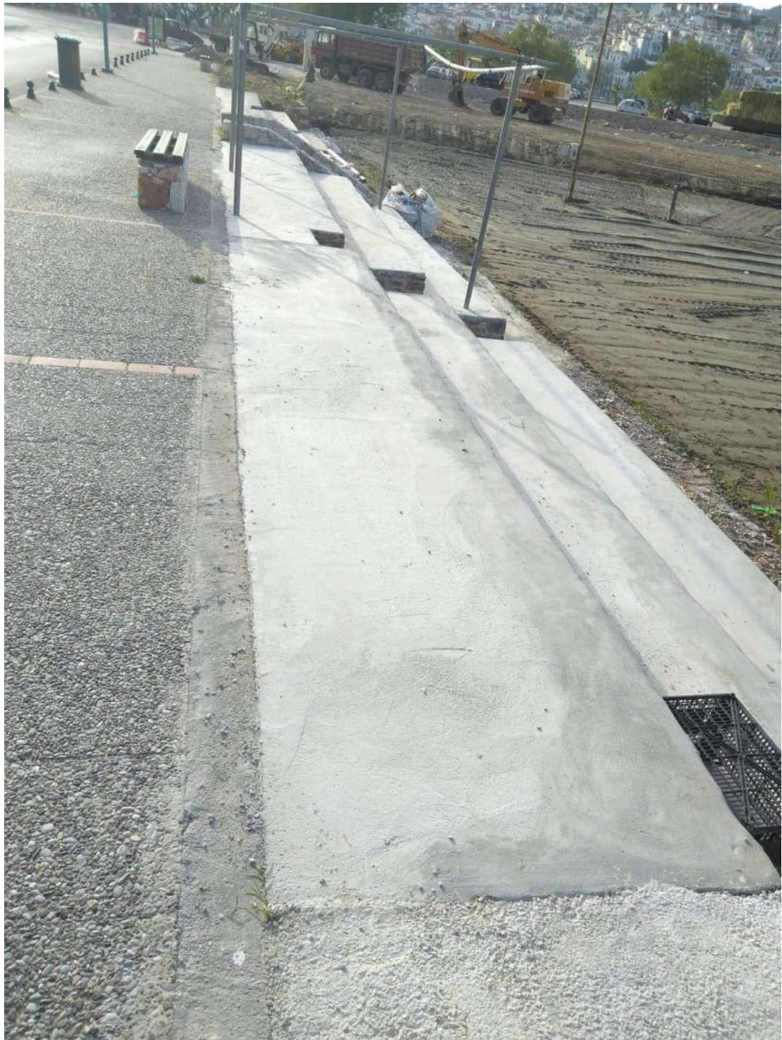
(Εργασίες κατασκευής κερκίδων)
