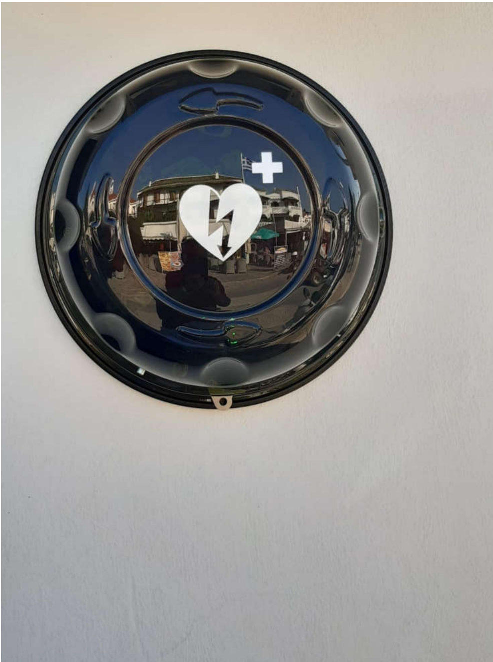
(Τοποθέτηση Απινιδωτή στο Λιμένα Σκοπέλου)
