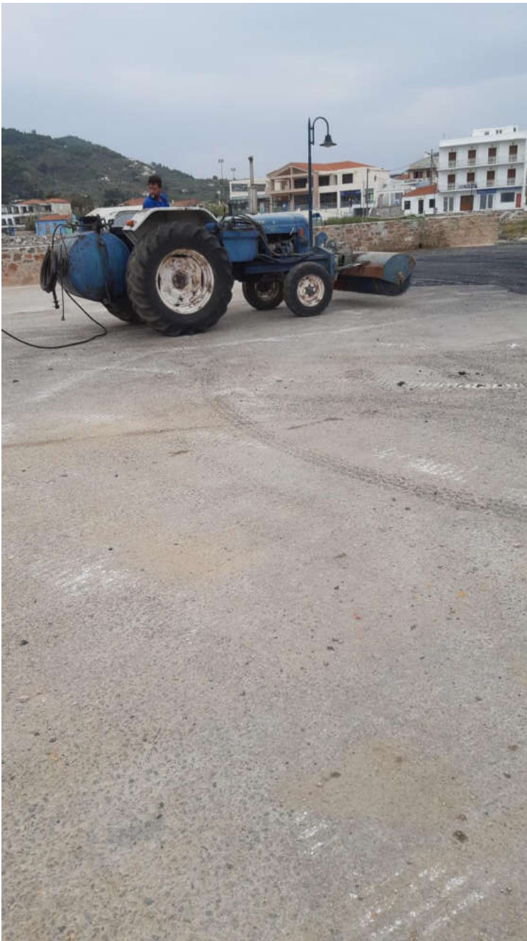
(Εργασίες στο λιμένα Σκοπέλου)
