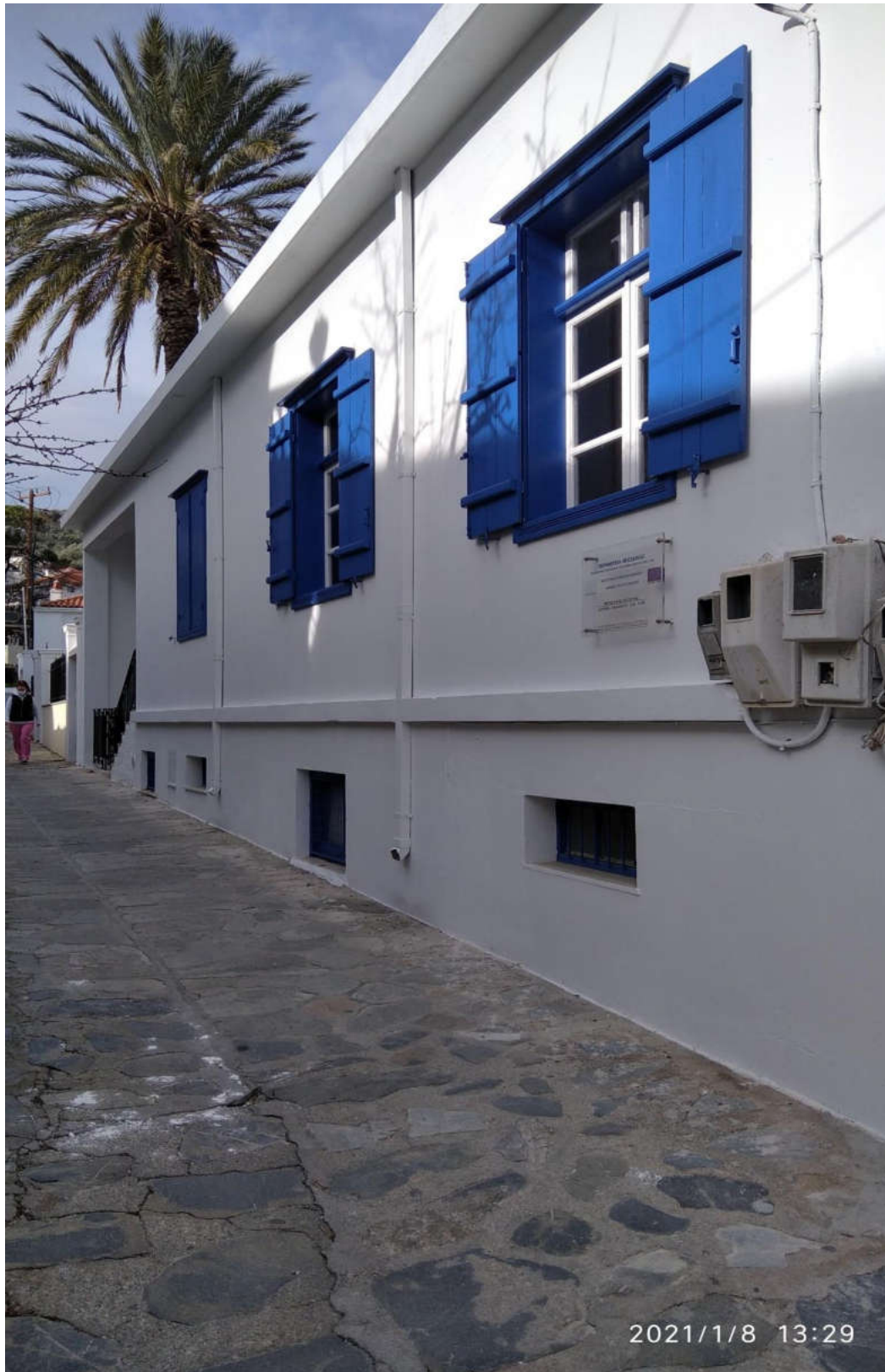
(Εργασίες ελαιοχρωματισμού - κτίριο ΒΟΥΓΙΑΛΑ - πρώην ΚΑΠΗ)
