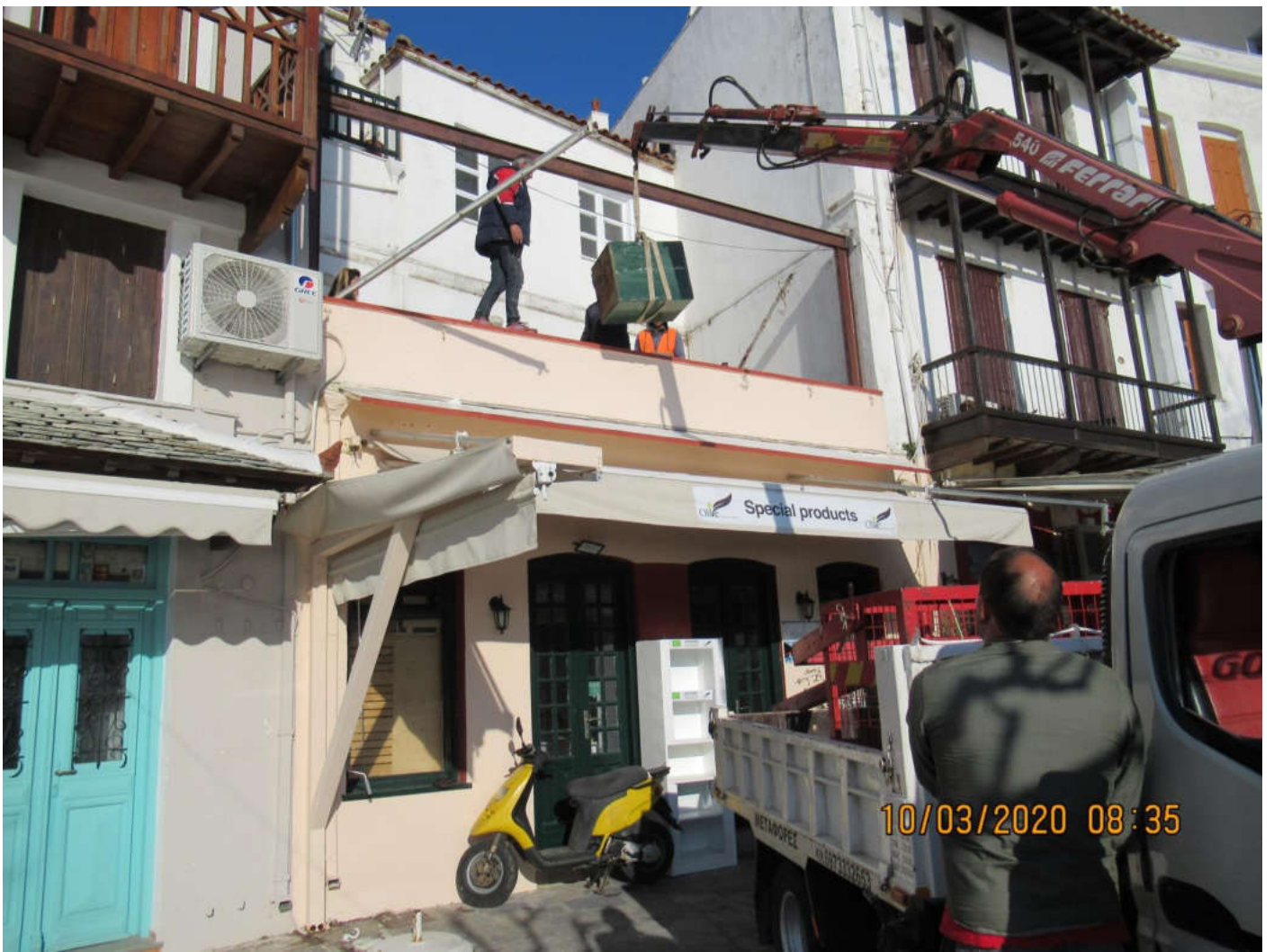
(Εργασίες μεταφοράς της υπηρεσίας ΚΕΠ Σκοπέλου)
