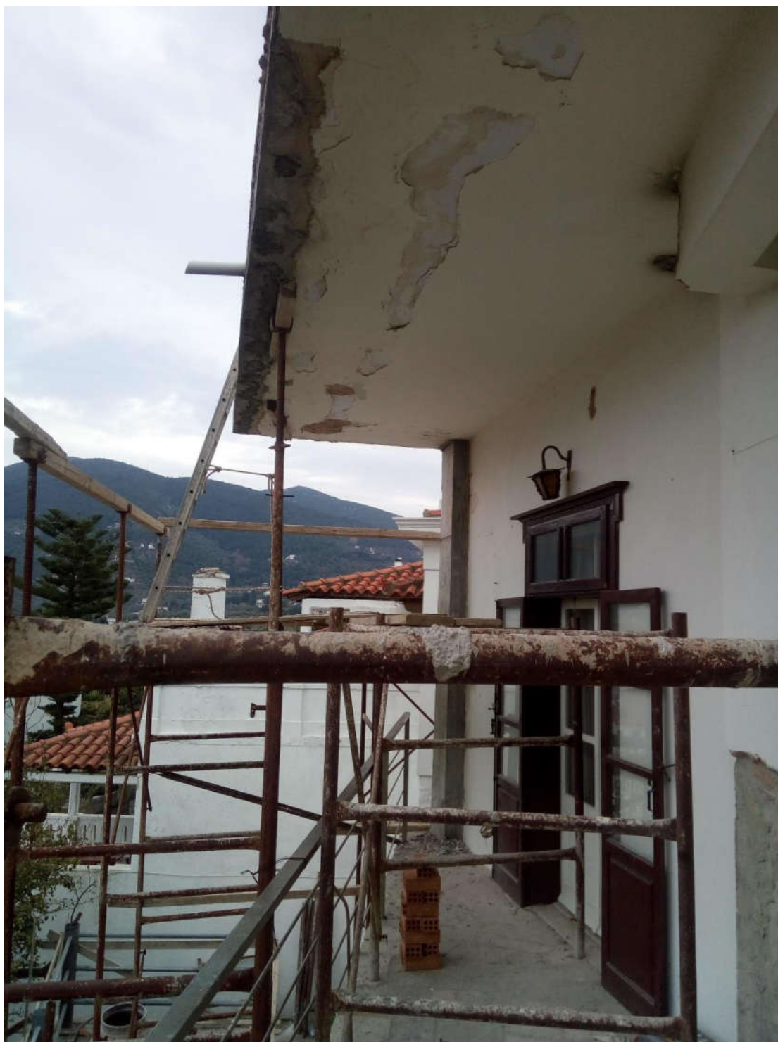
(Εργασίες πρώην στο κτίριο του ΚΑΠΗ)
