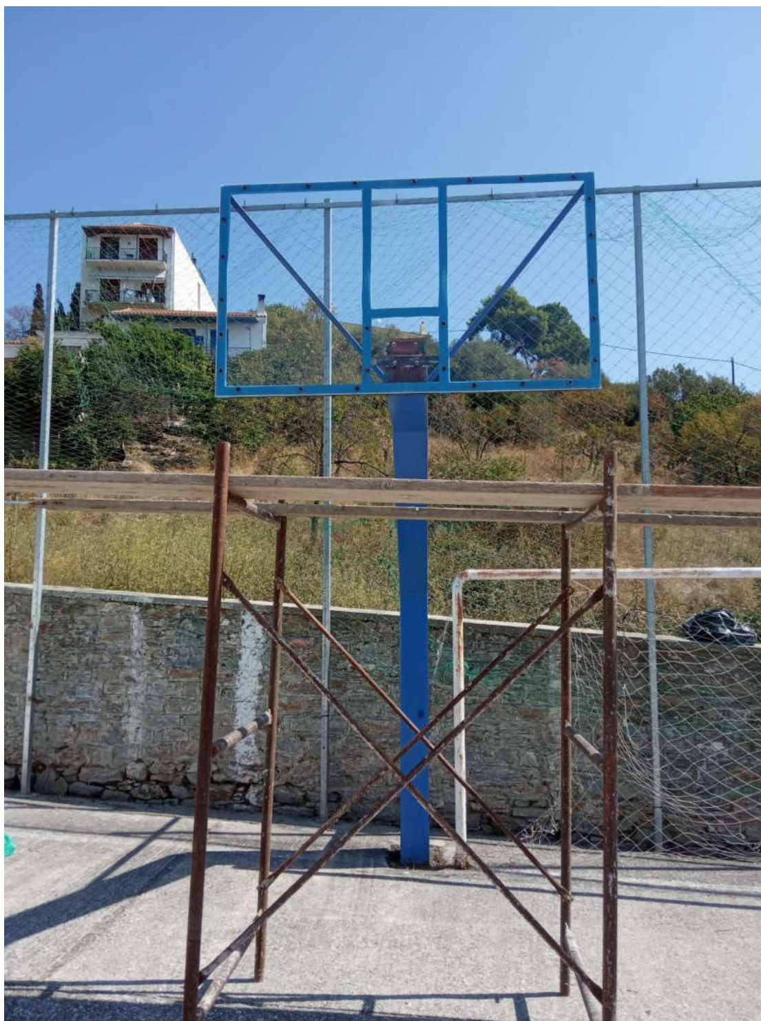
(ΕΠΙΣΚΕΥΗ ΜΠΑΣΚΕΤΑΣ ΣΤΗ ΓΛΩΣΣΑ)
