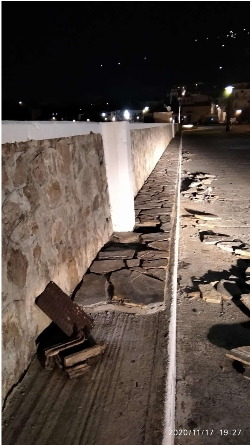
(Εργασίες καλλωπισμού του λιμένα Λουτρακίου)
