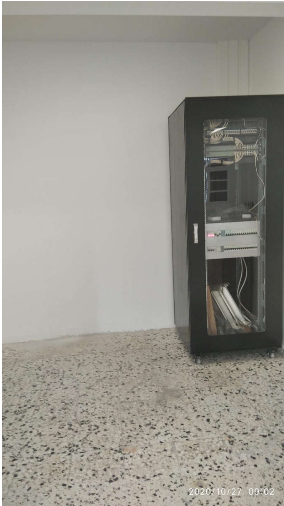
(ΟΛΟΚΛΗΡΩΣΗ ΕΡΓΑΣΙΩΝ ΚΤΙΡΙΟ ΒΟΥΓΙΑΛΑ – ΠΡΩΗΝ ΚΑΠΗ)
