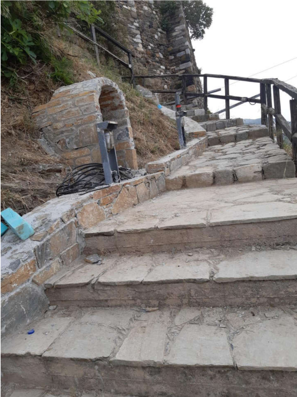
(Εργασίες στην περιοχή του Κάστρου Σκοπέλου 2020)
