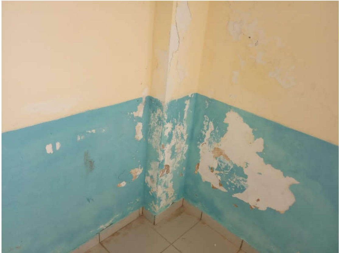
(Δημοτικό σχολείο Παλαιού Κλήματος)
