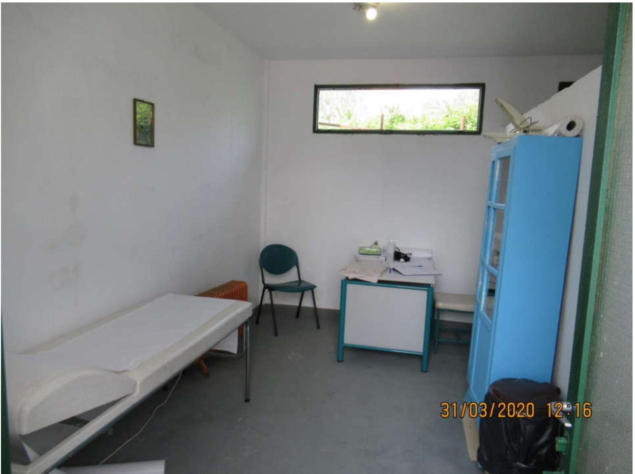
(Μετά - Κτίριο πλησίον Κέντρου υγείας Σκοπέλου)
