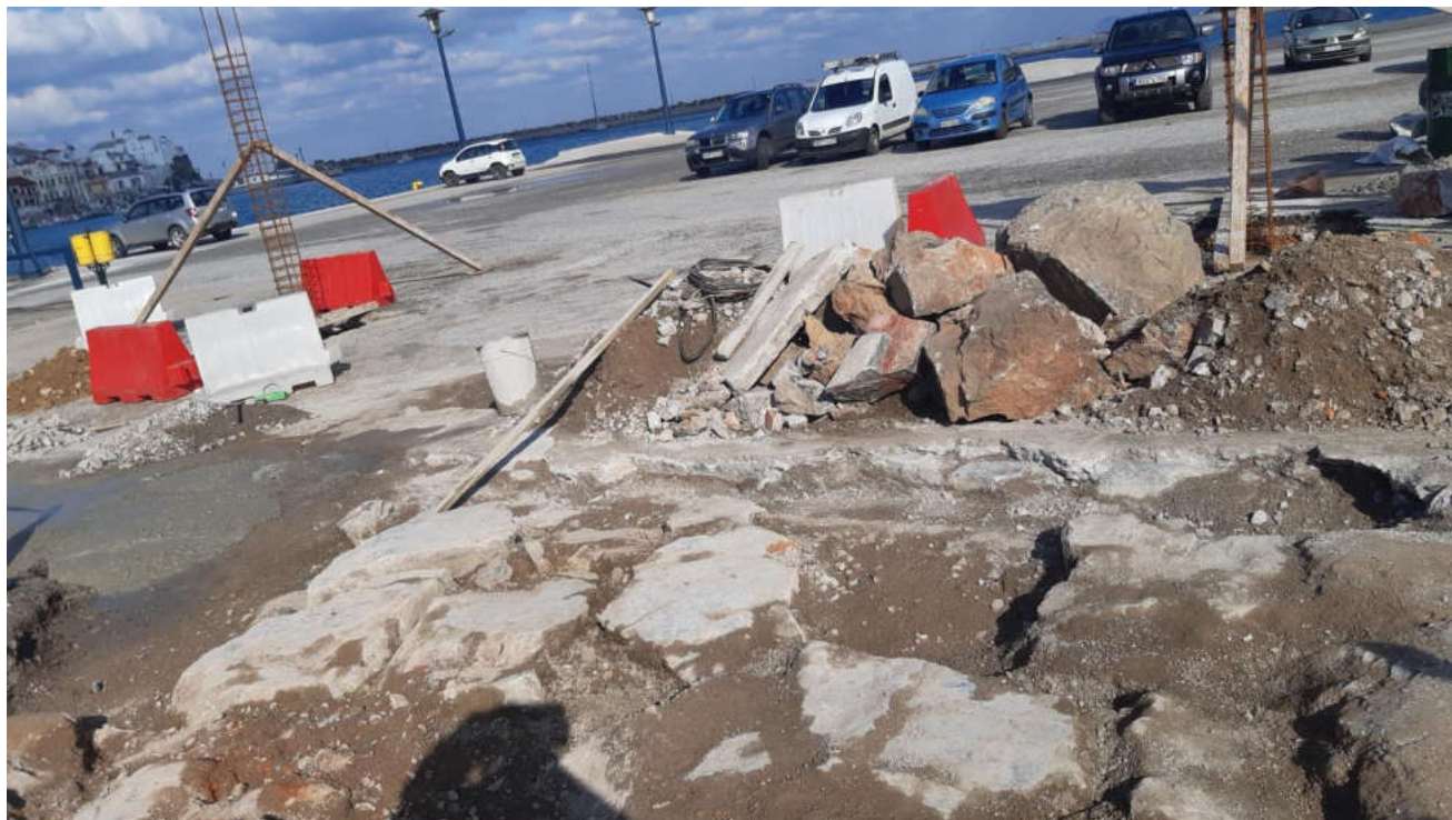
(Εργασίες διαμόρφωσης στο λιμένα Σκοπέλου)
