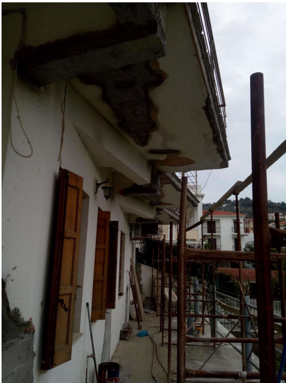
(Εργασίες πρώην στο κτίριο του ΚΑΠΗ)
