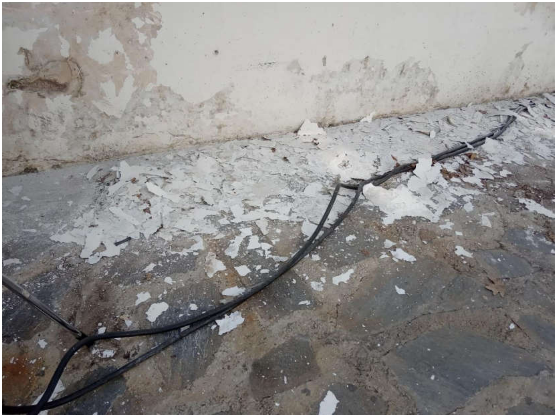
(Τοίχος κτιρίου ΞΕΝΙΑ- ΠΡΙΝ)
