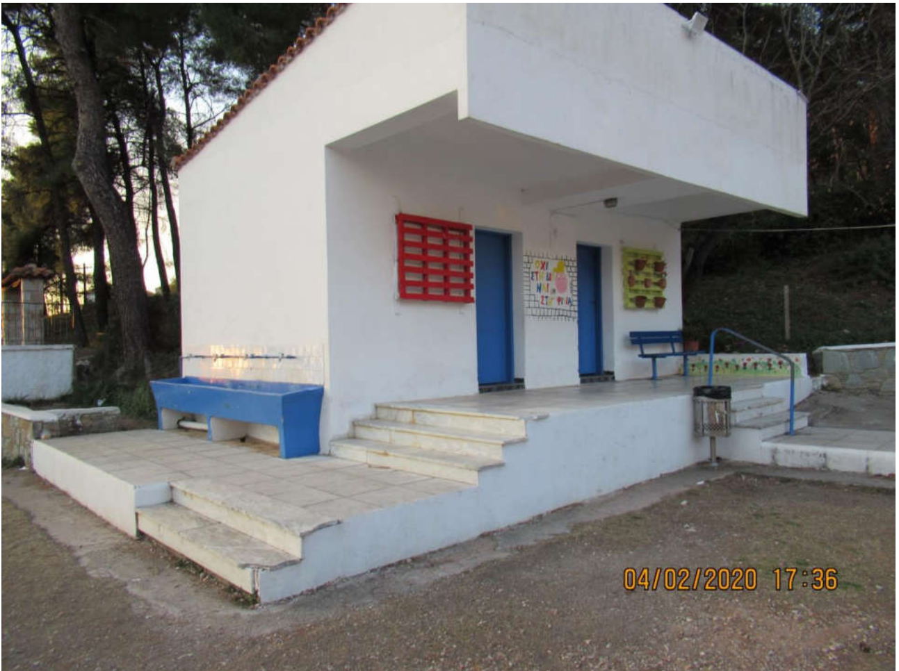
(Σχολείο Ν. Κλήματος πριν την τοποθέτηση κιγκλιδωμάτων ασφαλείας)
