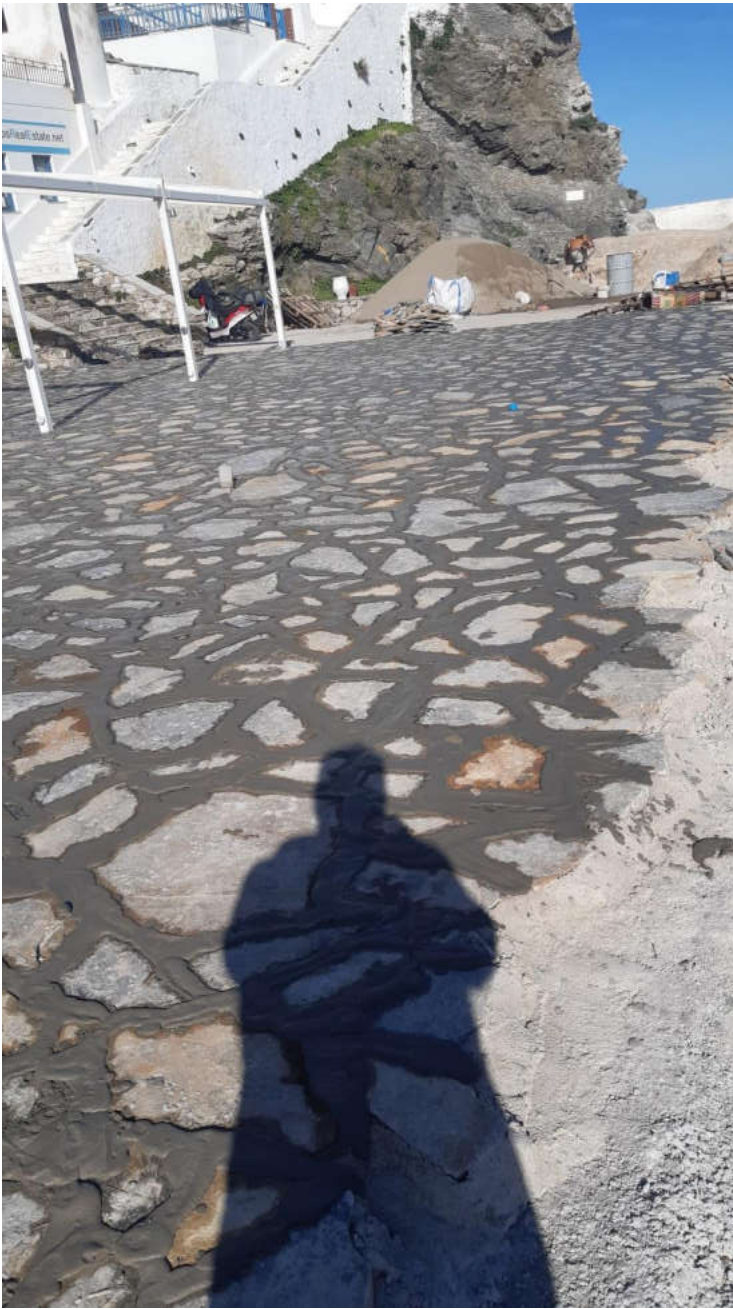
(Εργασίες διαμόρφωσης παραλιακού μετώπου Σκοπέλου )
