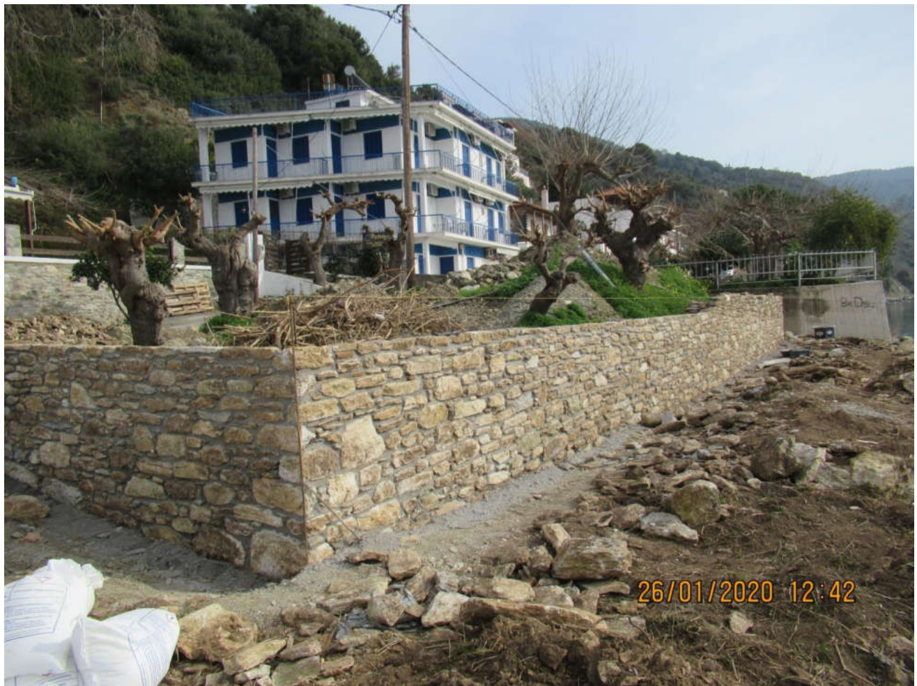
(Εργασίες κατασκευής τοιχίου στην περιοχή Πέτρινο στη Γλώσσα)
