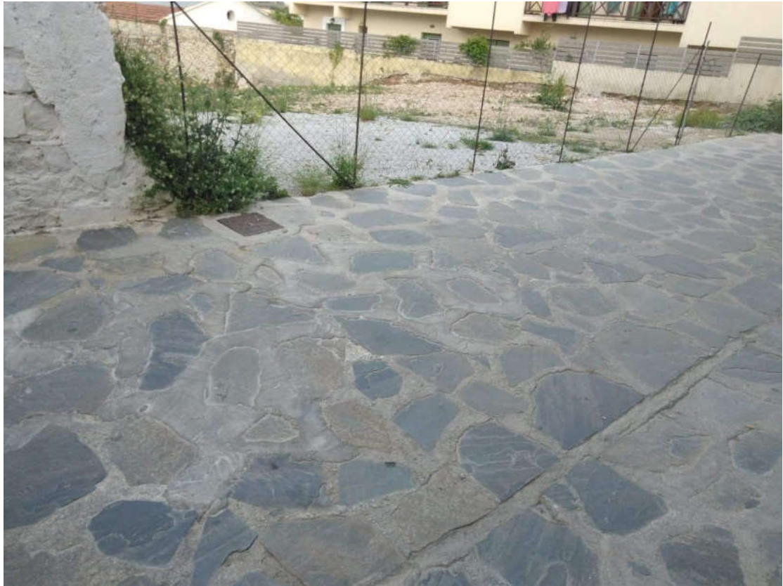
(Εργασίες αποκατάστασης πλακόστρωτου)
