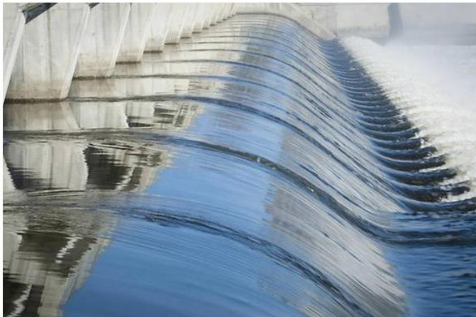
Grâce aux 1 million d'euros levés, une centrale hydroélectrique verra le jour en Ariège. Bulb in Town
