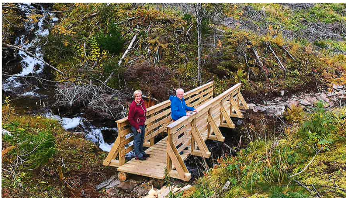
Kjøpsnes Turlag har bygd bru over Stortindselva På bilde ser vi Emma Kristensen og Svein Berg
