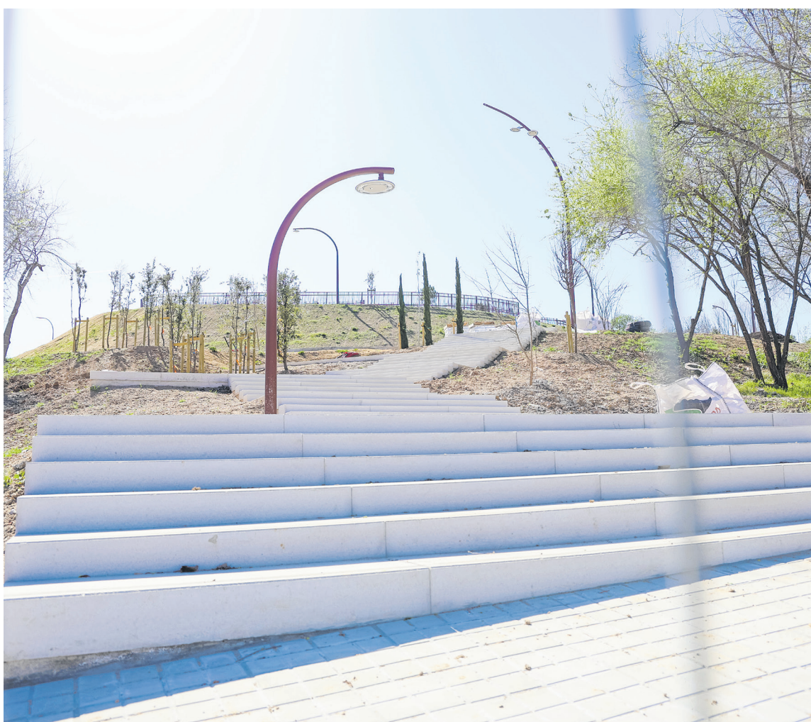
Les obres del parc de les Aigües encaren les últimes fases / VÍCTOR CASTILLO
