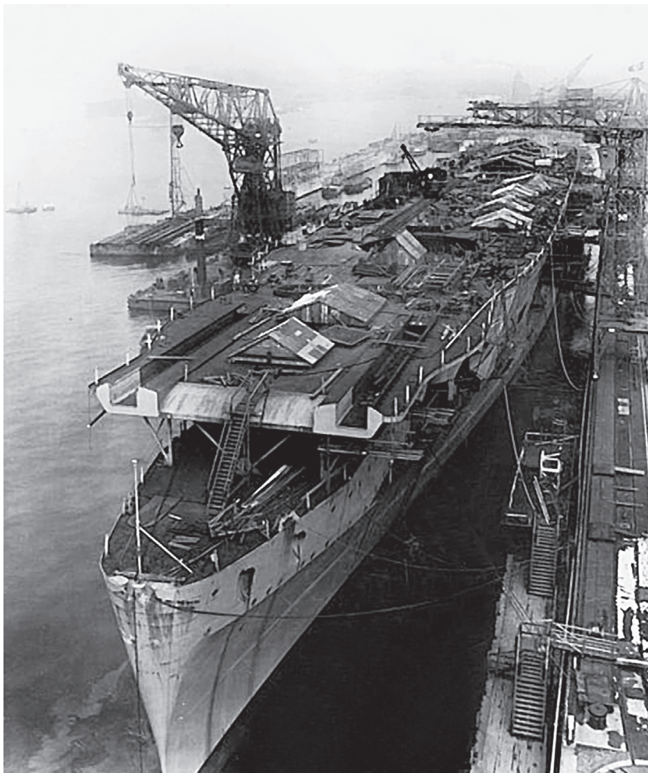
▲ Le Graf Zeppelin le 22 mars 1939. Les emplacements réservés aux deux catapultes sont bien visibles à l'avant du pont d'envol. La fin du chantier est alors prévue pour le 13 mars 1940, mais des retards amèneront à repousser la date au 1 er juin 1940. L'avenir en décidera autrement... (E-N Archives)
