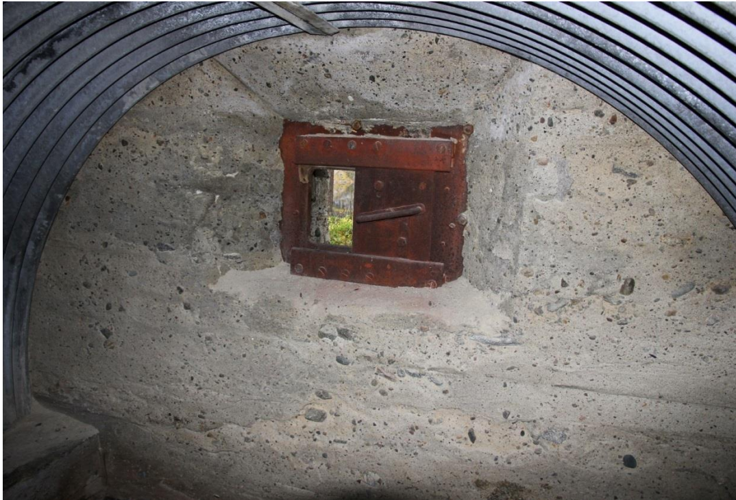
På innsiden av maskingeværbunker.
