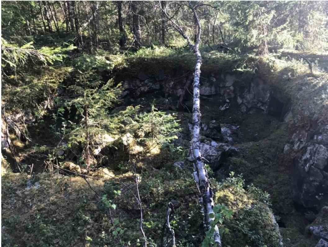
Anlegg TB-5. Søylene i midten har kollapse. Bilde fra Olav Mandt.
