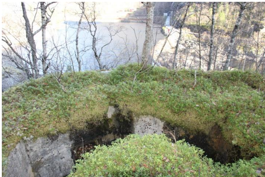
Maskingeværstilling oppført i armert betong.
