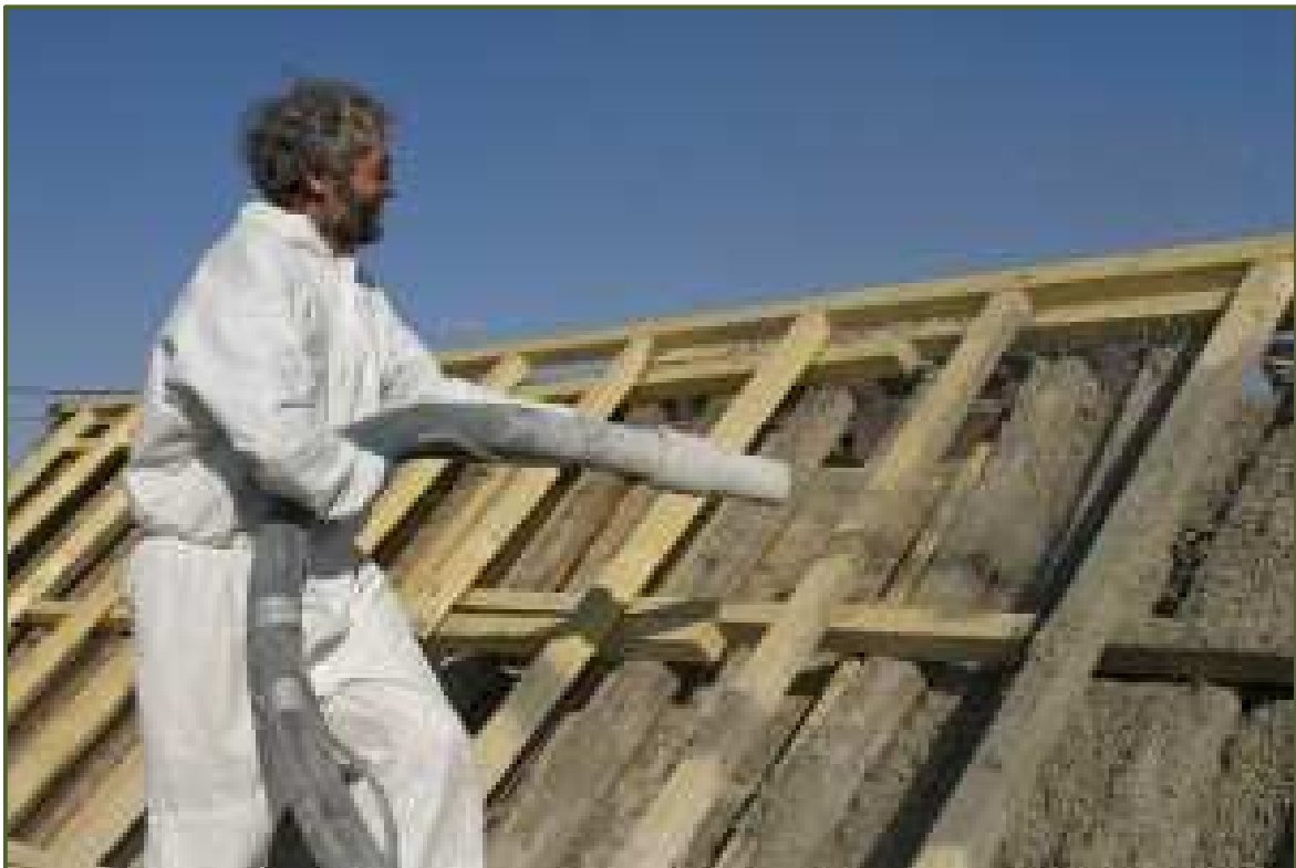
Béton de chanvre projeté pour une isolation de toiture - Construction en Chanvre
