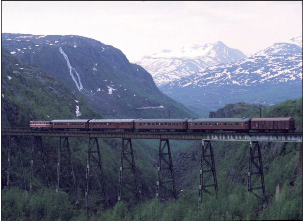
Ofotbanen er en spektakulær reise mellom vidda og fjorden. Banen ble bygd med formål å frakte jernmalm fra LKABs gruver i Kiruna til isfri havn i Narvik. Da banen stod ferdig i 1902 ble den kalt "Verdens 8. vidunder". Rallarveien og infrastrukturen i Rombaksbotn er en viktig del av banens historie. Foto: Trond Blomli.
