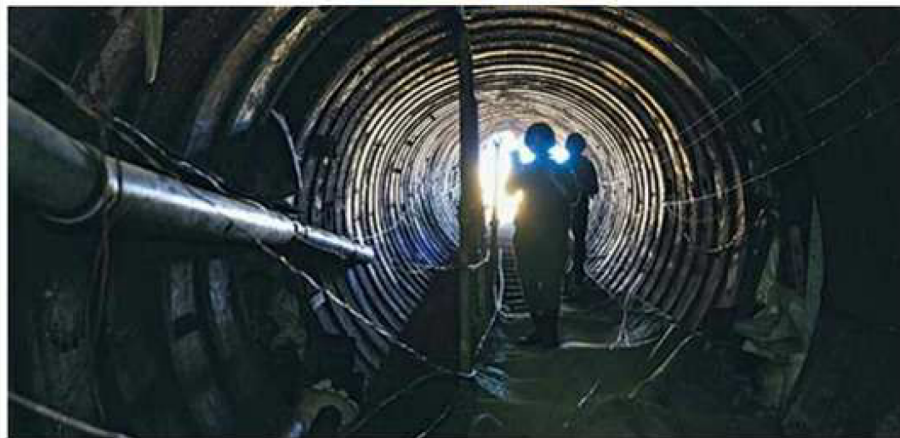
▲ Il tunnel Soldati israeliani nel tunnel di Hamas, nella parte nord della Striscia, vicino al valico di Erez
