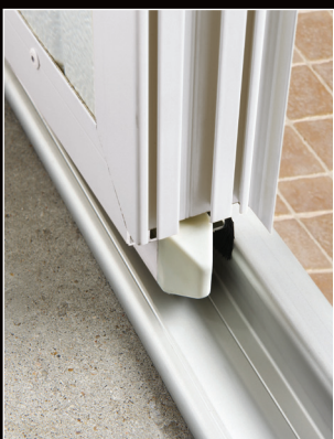
Rail de seuil aluminium anodisé.
