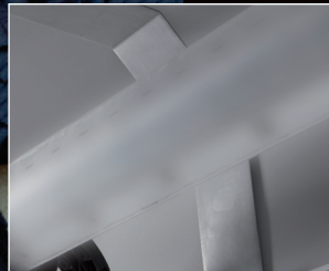
Renfort métallique assurant la rigidité et la planéité du coffre.
