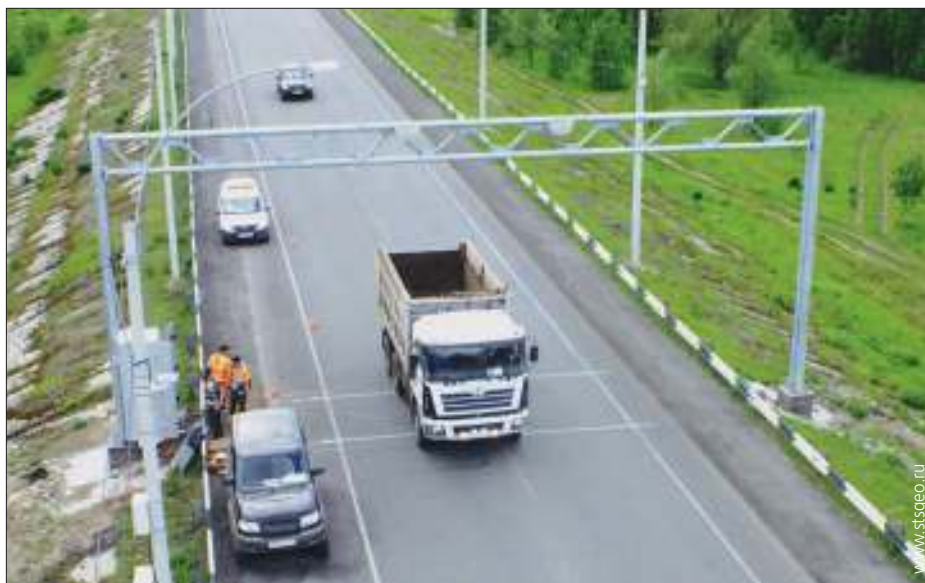
Автоматическая система весогабаритного контроля взвешивает и обмеряет грузовики во время их движения через специальные рамки на трассах
