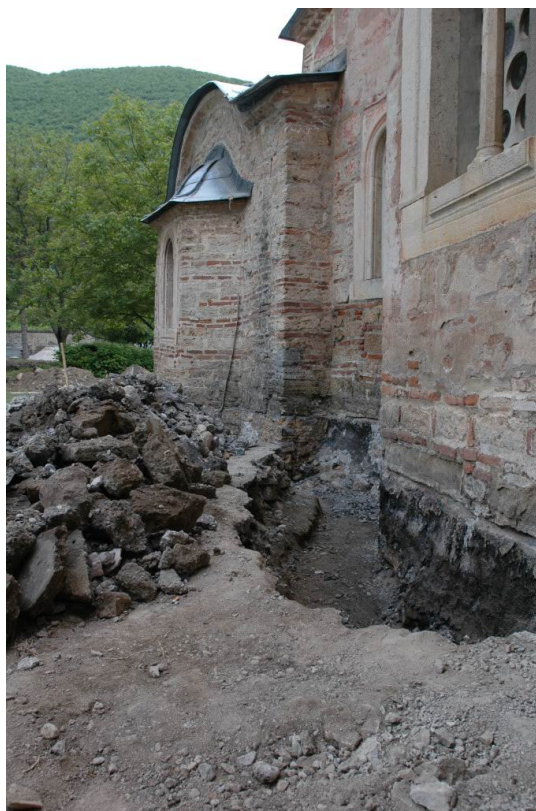
Слика 2: Ослобађање темељне зоне црква манастира Пећке Патријаршије од неконструктивног бетона
