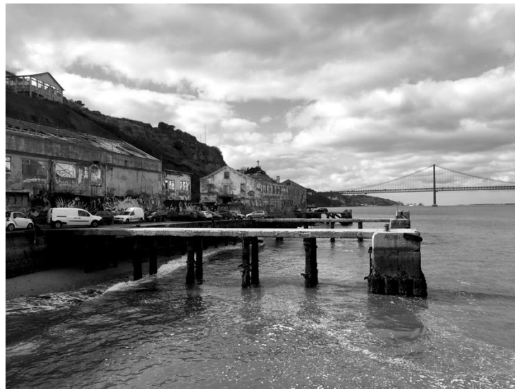
Fig. 01_Cais do Ginjal pier.
