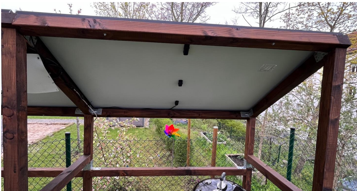
Abbildung 12: Photo der Befestigung der horizontalen Pfosten
