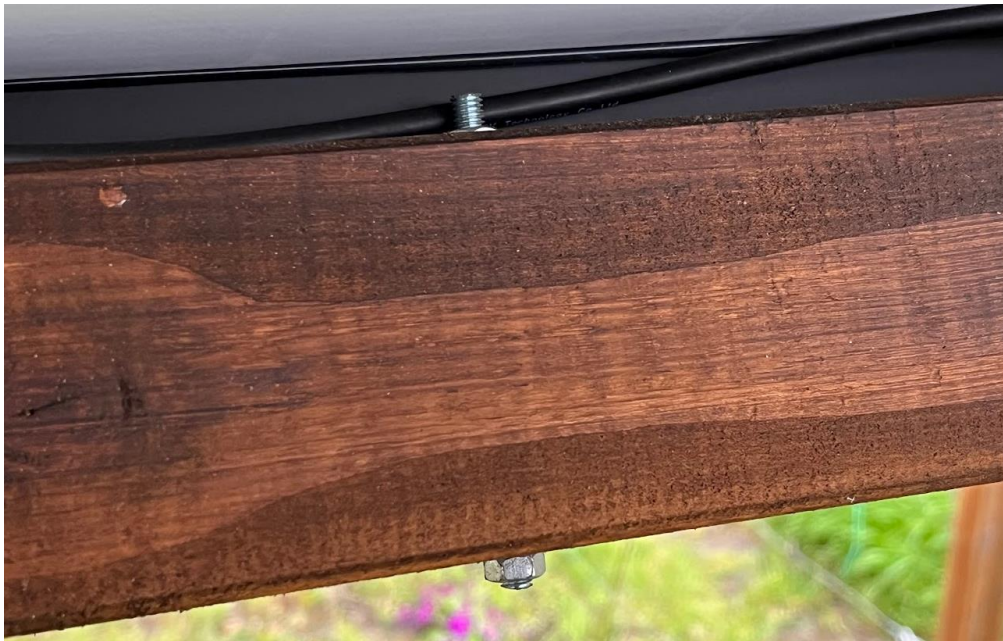
Abbildung 13: Photo der Modulbefestigung
