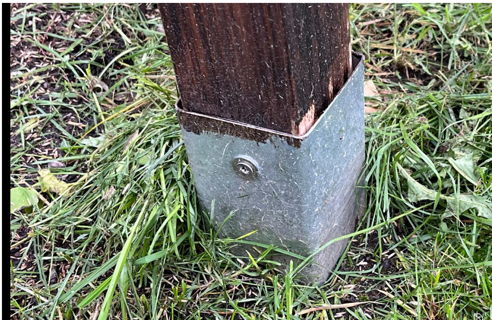
Abbildung 10: Bodenhülse mit Schraube
