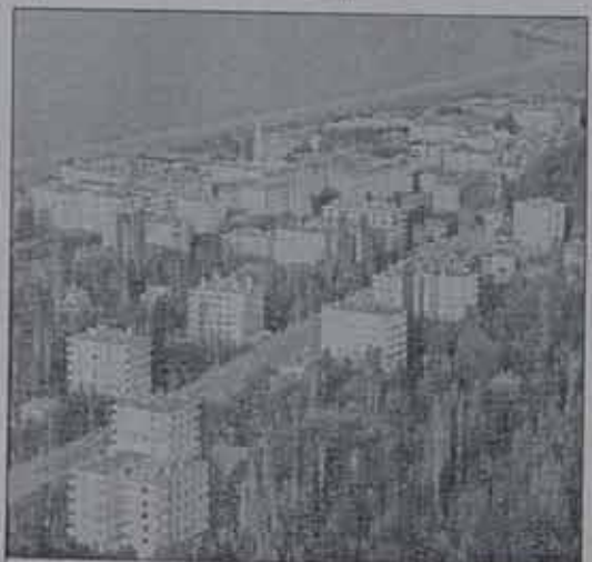
BETONLAŞMADA SON DURUM 18 Eylül'de Kaldırım Tepesi'nden çekilen bu fotoğrafta çarşı için betonlaşmasıyla son durumu görülmüştür. (Foto: Abana)
