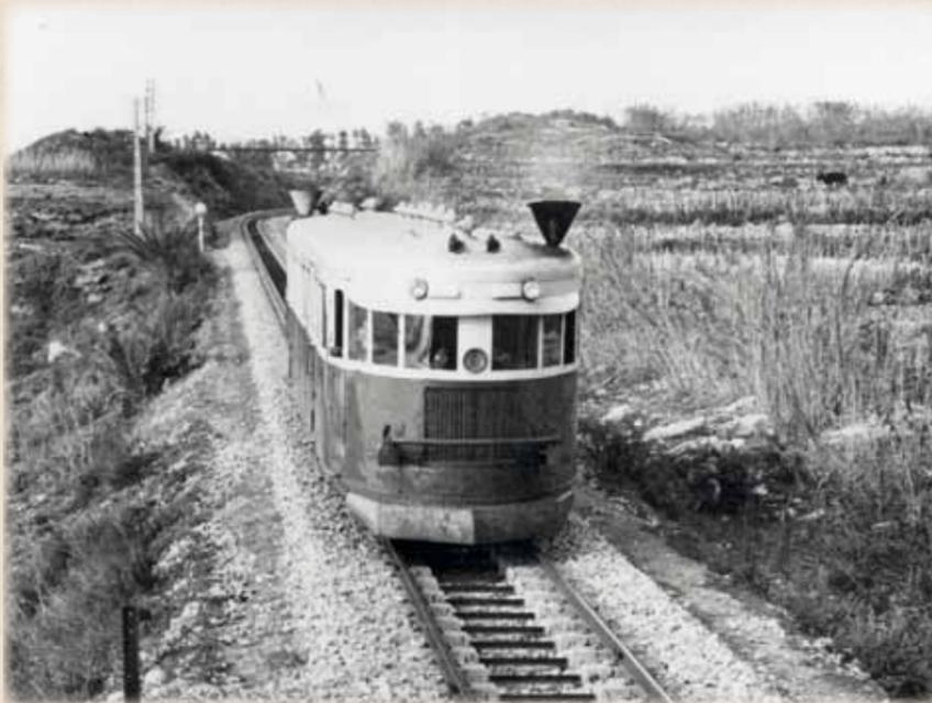
**A gauche :** Cette photo, prise au cours des années 1960 pour vanter les traverses bi-bloc de conception française, venant d'être posées sur la section libanaise Tripoli - Beyrouth, est l'une des rares montrant un autorail de 210 ch des anciens Etats du Levant en fin de carrière. Les écopes de prise d'air sont bien visibles. Collection Pascal Bejui
