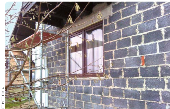
► Dom zbudowany z pustaków żużlobetonowych
