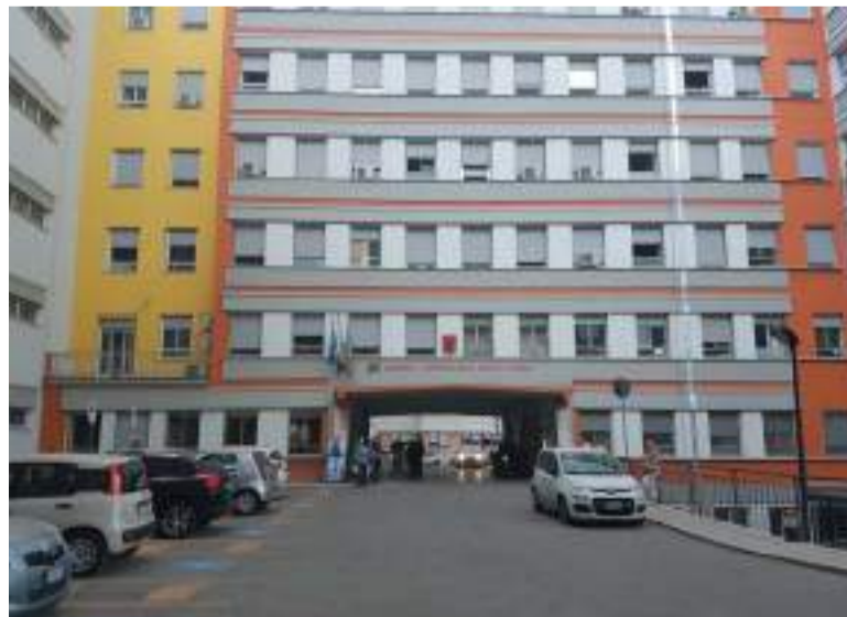
Santa Maria Malgrado i continui interventi di manutenzione e ammodernamento, la struttura ha comunque oltre 40 anni e segna il passo
