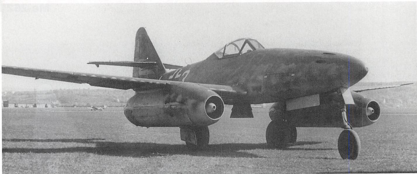
**Le Me 262 récupéré intact par les Suisses, en avril 1945. Il pouvait emporter 1 700 l de carburant dans deux réservoirs, consommait 3 420 l par heure à plein régime et 2 630 à 80 % de la puissance maximale ! Il restait 80 l quand l'avion s'est posé.**
