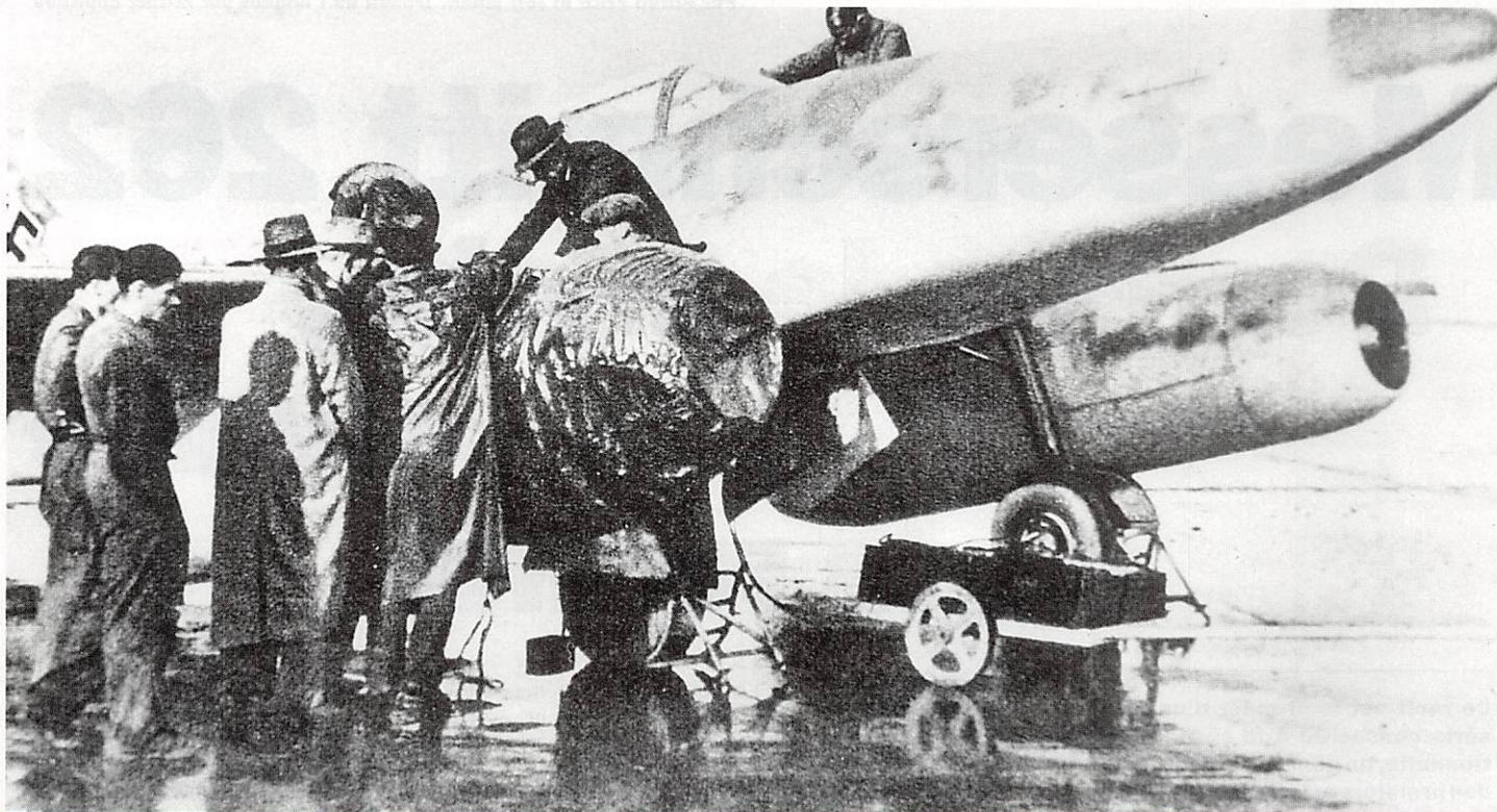
La préparation du Messerschmitt 262 V3, le prototype n° 3, encore à train classique, avant la mise en route des turboréacteurs. Des batteries sont déjà en place, sur un chariot glissé sous le fuselage.
