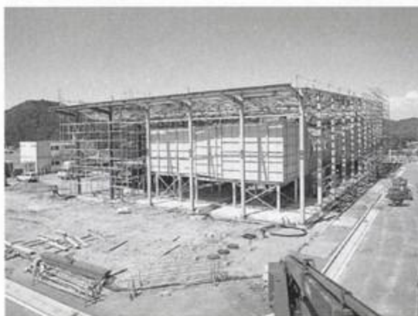
風洞完成後、外側の骨組みが徐々に組まれ、建物が形作られていく
