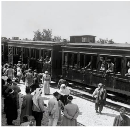
الصورة [4-41]: محطة بغداد في حمص عام 1930.
