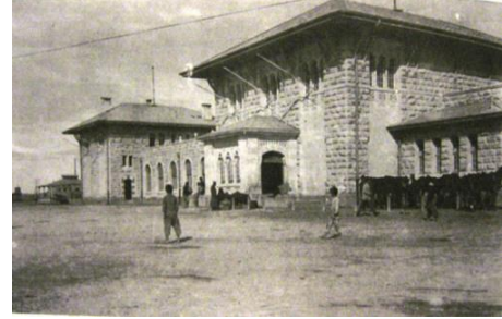
الصورة [4-39]: محطة بغداد في حلب.
