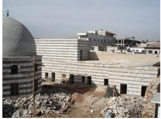
الصورة [3-47]: عمليات الترميم لتكية العسالي
