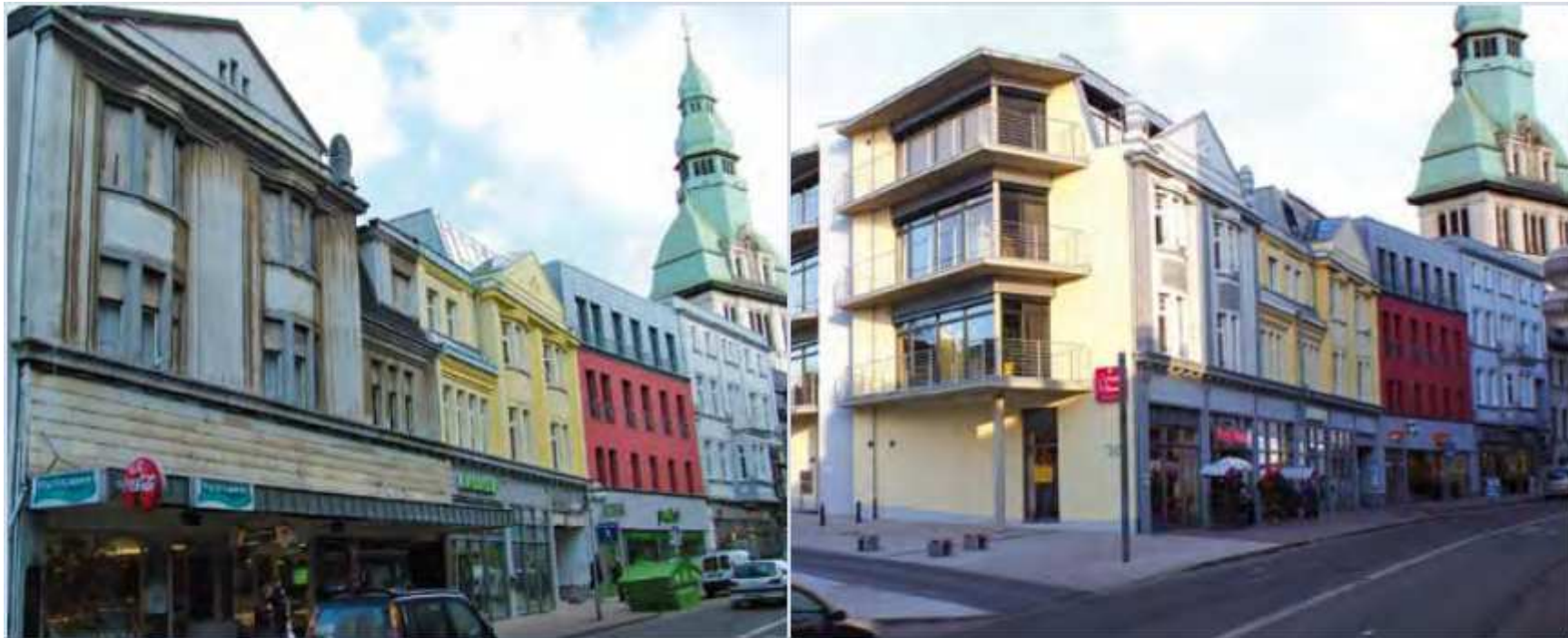
Vor und nach der Sanierung Fotos: Stadt Völklingen
