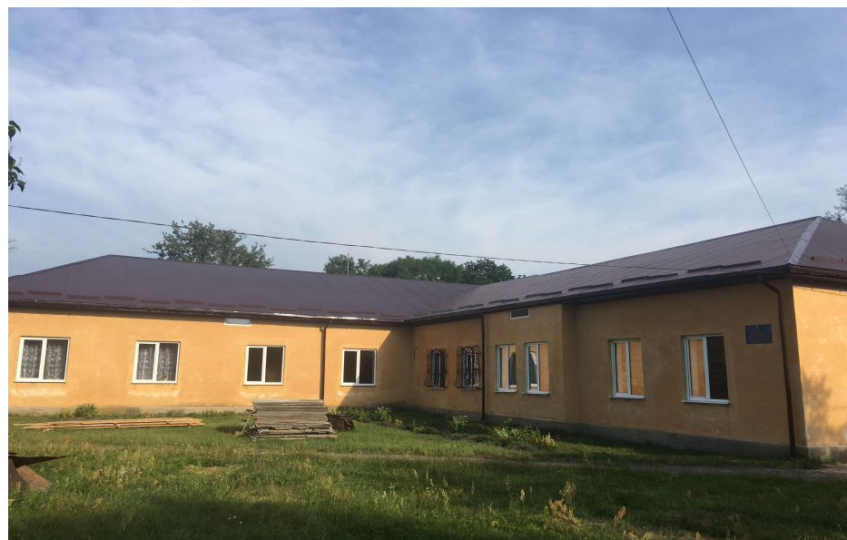
Капітальний ремонт шатрового даху Синьковицької ЗОШ - 400 тис.грн.
