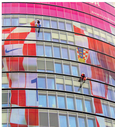
ALPINIZAM Nema snijega, ali alpinistička ekipa u dva je dana svladala izazov postavljanja golemog dresa na zgradu
