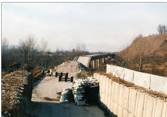
Порушен мост у с. Чекрчићи, на путу Зеница - Сарајево (1993. год.)
