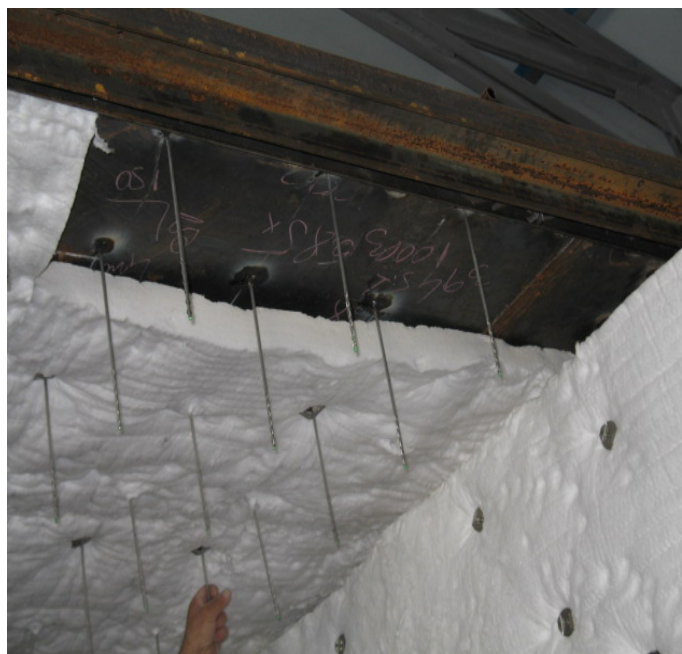
Figura 5.3. Modul de prindere a vatei ceramice.
