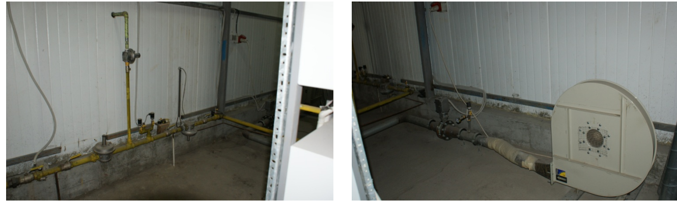
Fig. 5.30. Alimentarea cuptorului cu amestec gaz-aer în vederea funcționării după curba standard.
