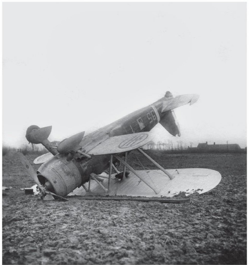
▲ Retour de mission difficile pour ce CR.42 de la 95 e Squadriglia, qui a rompu son train lors d'un atterrissage forcé quelque part en Belgique. Le « 1 » sur le fuselage et la bande entourant l'arrière du fuselage indiquent qu'il s'agit du chef d'escadrille, le capitano Gino Lodi. (Collection de l'auteur)
