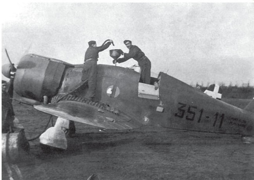
▲ Maintenance d'un G.50 de la 351 e Squadriglia sur la piste de Maldegem. Quand les matériels de piste les plus basiques n'ont pas pu être fournis par les Allemands, les mécanos italiens doivent avoir recours à la combinazione : ici, ils font les pleins « à l'ancienne » à partir de fûts avec des pompes à main, voire par gravité. (Vigna)
