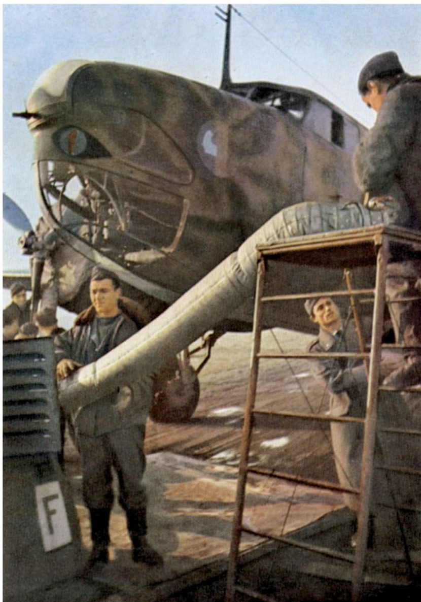
▲ Maintenance d'un G.50 de la 351 e Squadriglia sur la piste de Maldegem. Quand les matériels de piste les plus basiques n'ont pas pu être fournis par les Allemands, les mécanos italiens doivent avoir recours à la combinazione : ici, ils font les pleins « à l'ancienne » à partir de fûts avec des pompes à main, voire par gravité. (Vigna)
