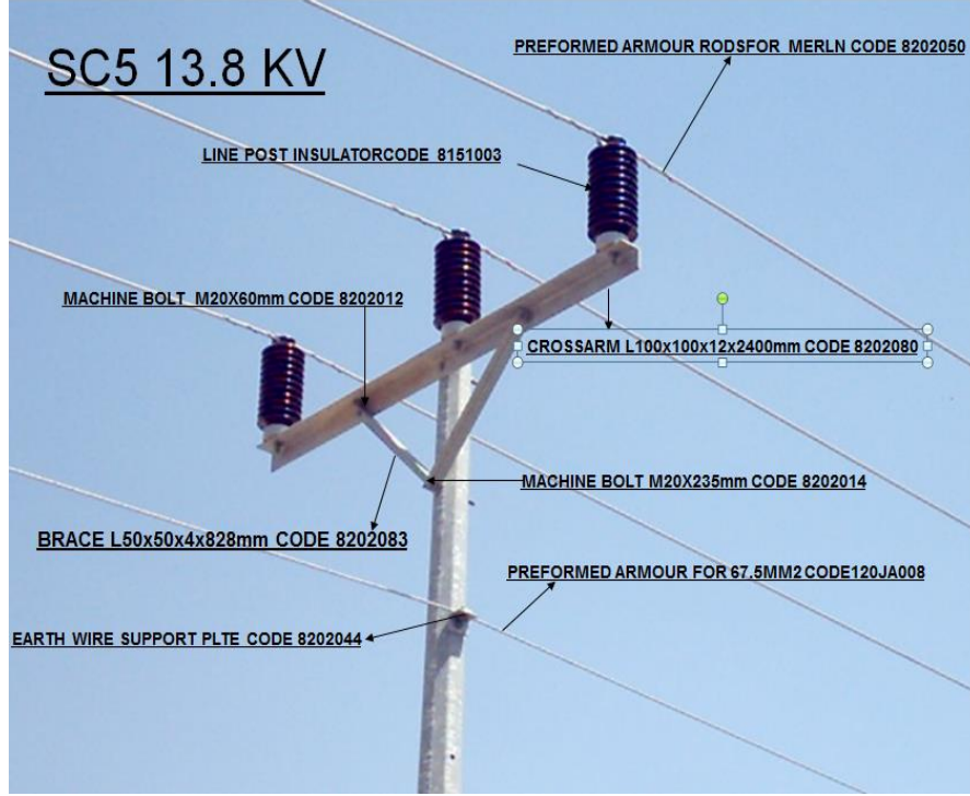
شكل ( ٥٥ - ٤ ) عمود ضغط متوسط بعوازل رفع
