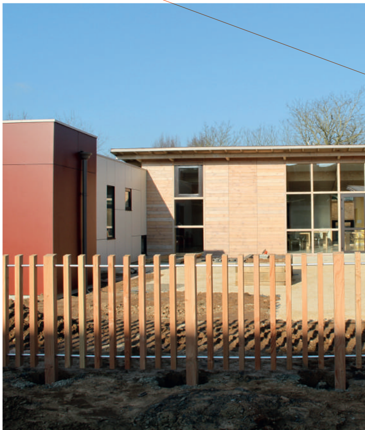
LA MAISON D'ACCUEIL DE LA SÉGUINIÈRE - FRANCE MAISON DE RETRAITE (Ad Hoc Architecture: B Migeon & JF Leroy)
