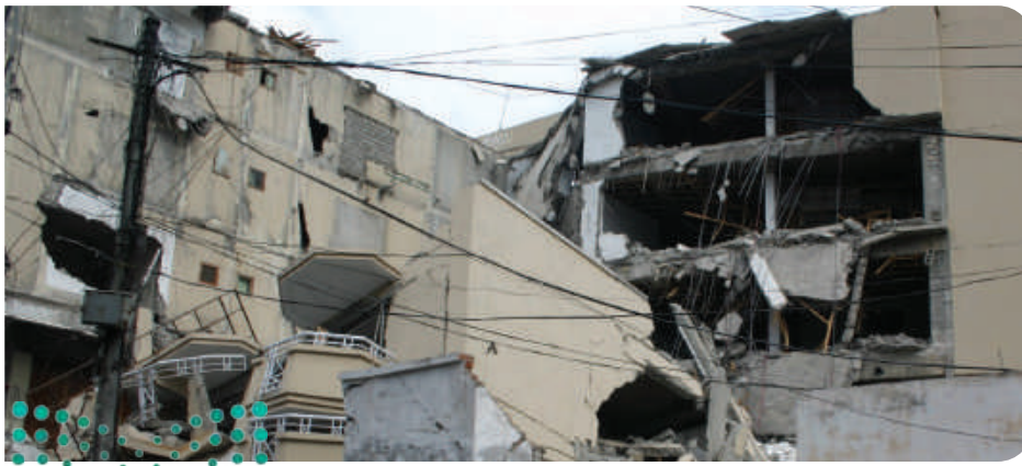
الشكل 27-6 دمار ناجم عن زلزال قوته 7.6 درجة على مقياس رختر، وهو زلزال قوي ضرب الباكستان في شهر يناير من عام 2005 م.
