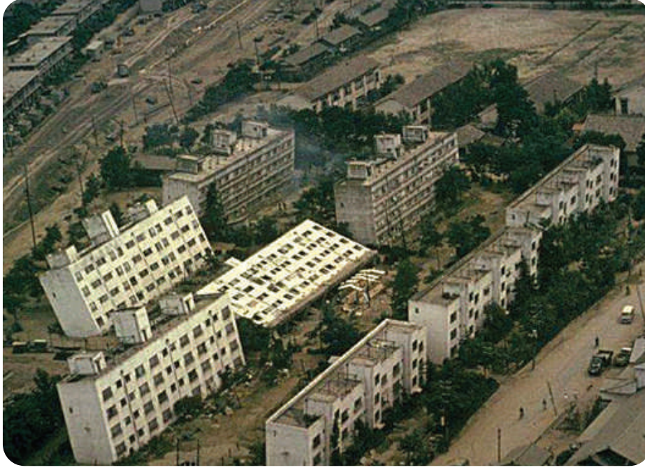
الشكل 35-6 يحدث تسييل في التربة الضعيفة التماسك عندما تنتشر اهتزازات زلزالية فيها، فتسلك سلوك الرمال المتحركة.
