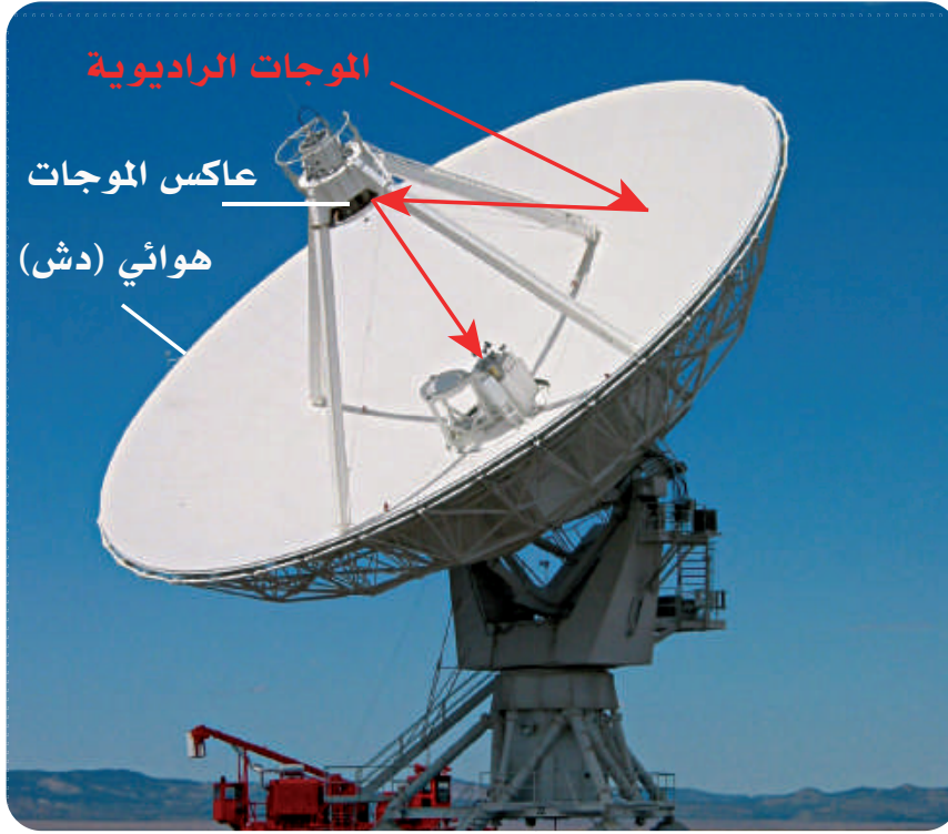
الشكل 14-3 تركيب المنظار الراديوي.
