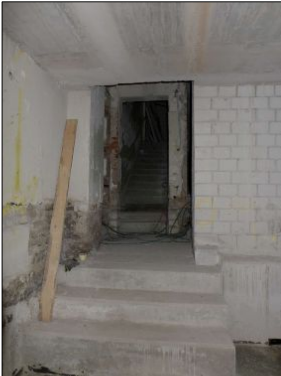
Distanztreppe im Bereich der Flur im Kellergeschoss zum Ausgleich von Niveauunterschieden von Bestand und Neubau/Erweiterung
