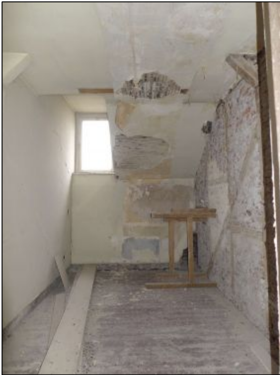
Umbau Bestand, hier im Dachgeschoss
