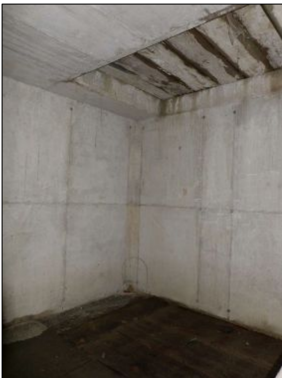
Bereich des geplanten Lastenaufzugs vom Keller zum Erdgeschoss
