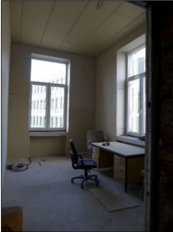
Umbau Bestand im Obergeschoss, hier Büro- räume
