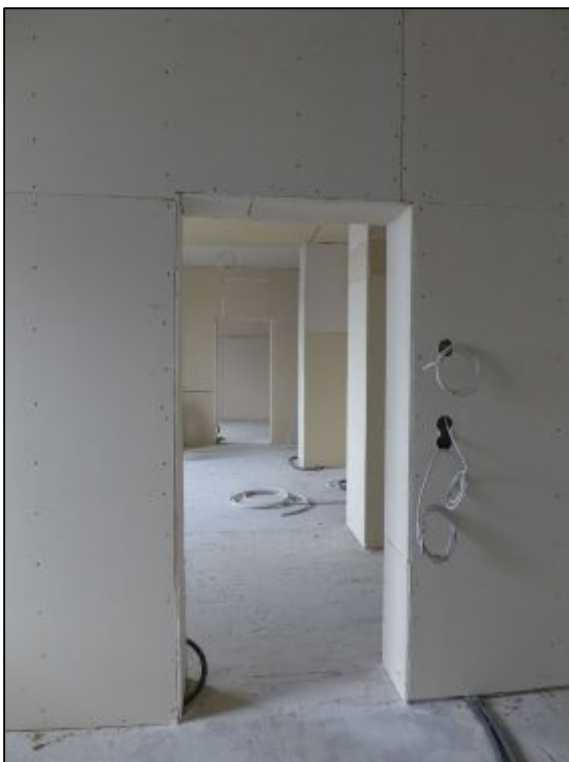
Umbau Bestand, hier im Dachgeschoss
