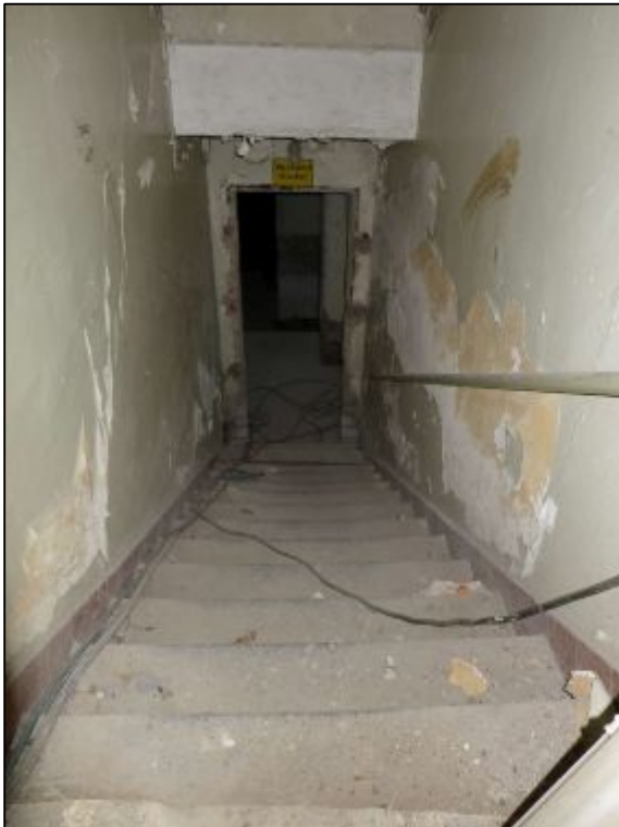
Kellertreppe Bestand (Holztreppe)
