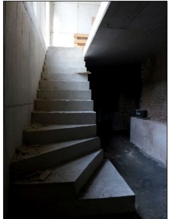
Treppe vom Erdgeschoss (Küchenbereich) zu den Nebenräumen (Müll, Technik, Getränke, Kühlzellen, Hebeanlage, Fettabscheider, Personalräume etc. ) im Kellergeschoss
