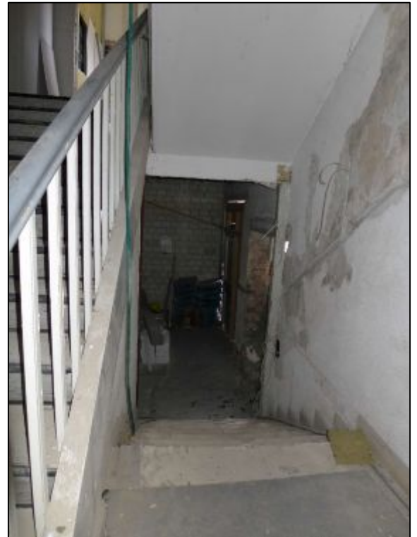
Treppenhaus Bestand (Holztreppe)
