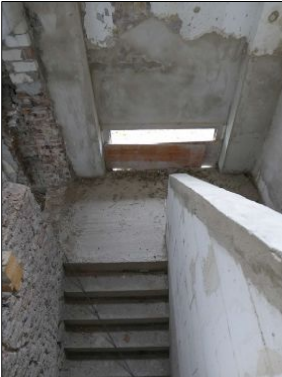
Umbau Bestand, Stahlbetontreppe vom Erdgeschoss zum Obergeschoss
