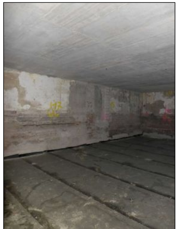
Geplanter Müllsammelraum im Kellergeschoss
