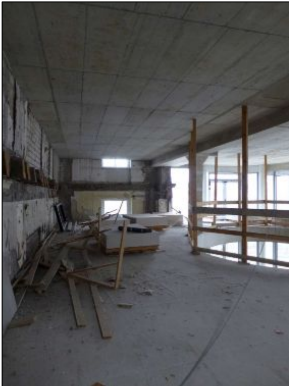
Nutzungseinheit 1 (Gastronomie), hier Bereich im Obergeschoss
