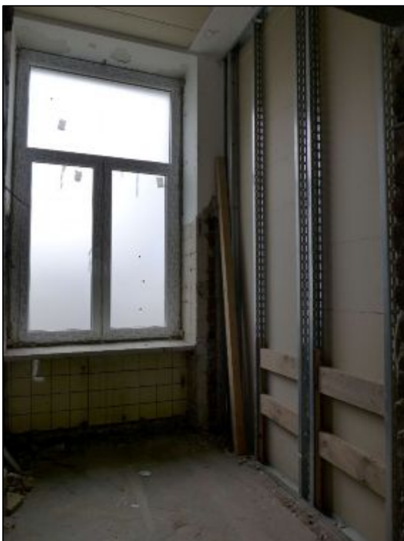
Umbau Bestand im Erdgeschoss (Westseite)
