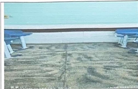
Foto 01- piso em granilite
