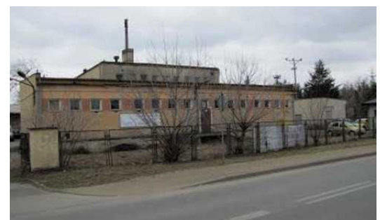
Widok nieruchomości budynkowej od strony ulicy Grunwaldzkiej.
