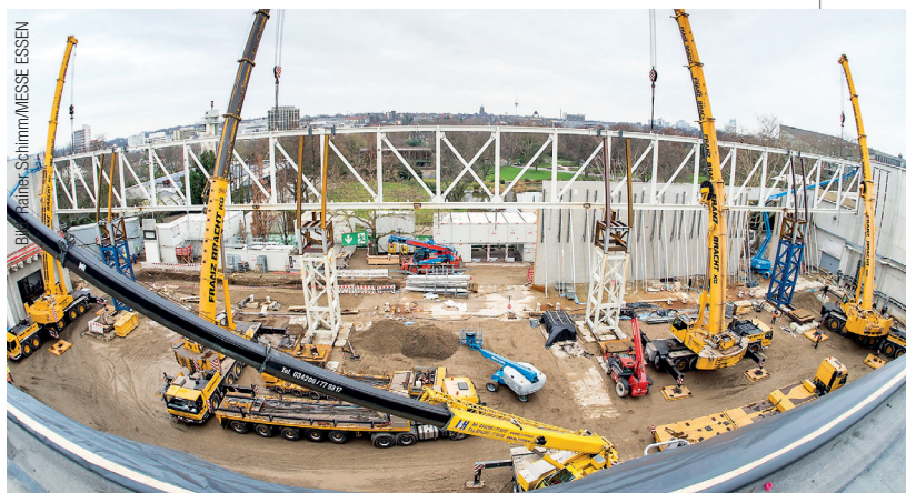
Das Rückgrat der neuen Halle 5 als Meilenstein in der letzten Bauphase der NEUEN MESSE ESSEN.
