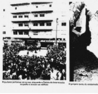
Fotografia da embaixada de Cuba em Lisboa, destruída por uma bomba explosiva.
