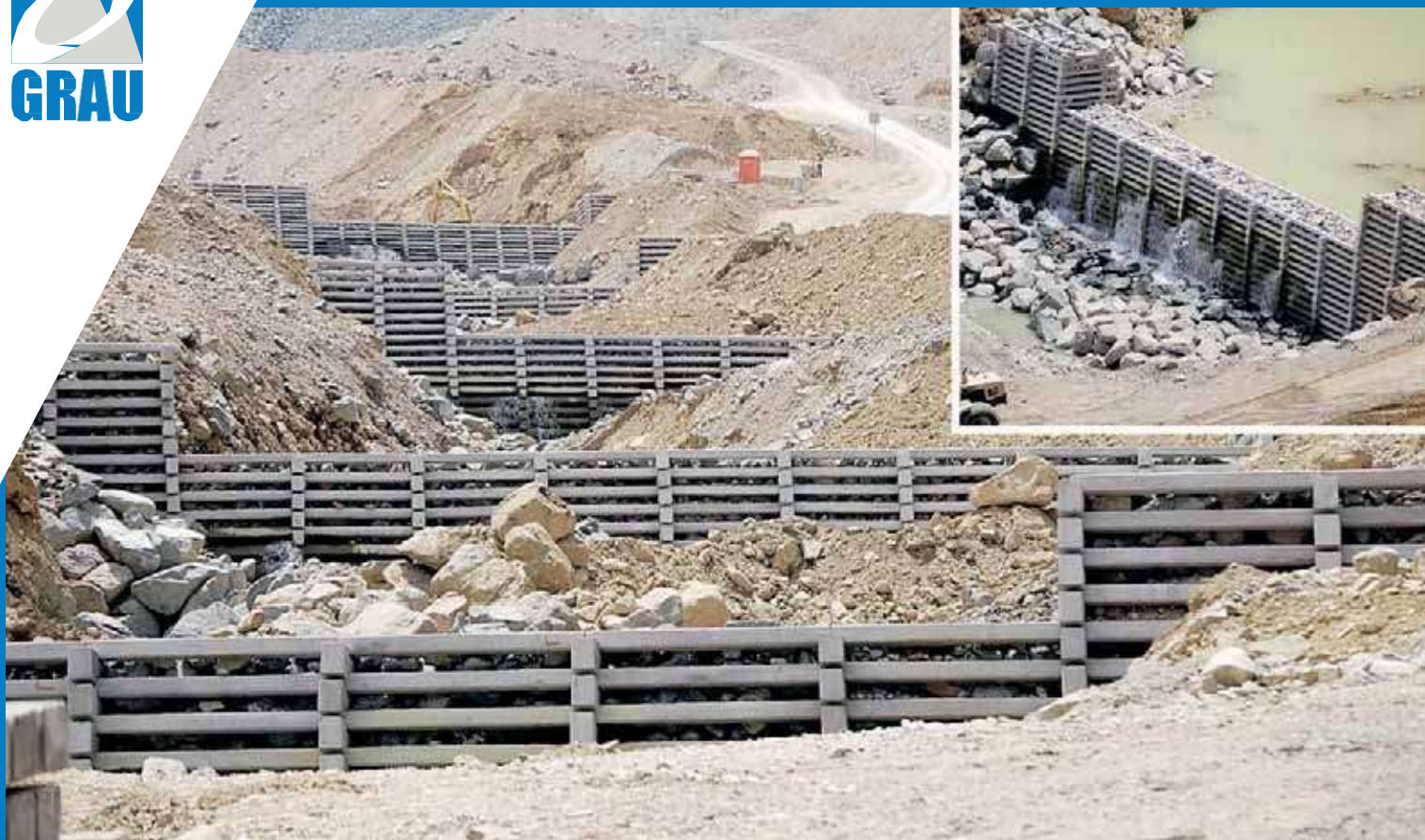
▲ Barreras de Control aluvional Río Coya • Sewell
