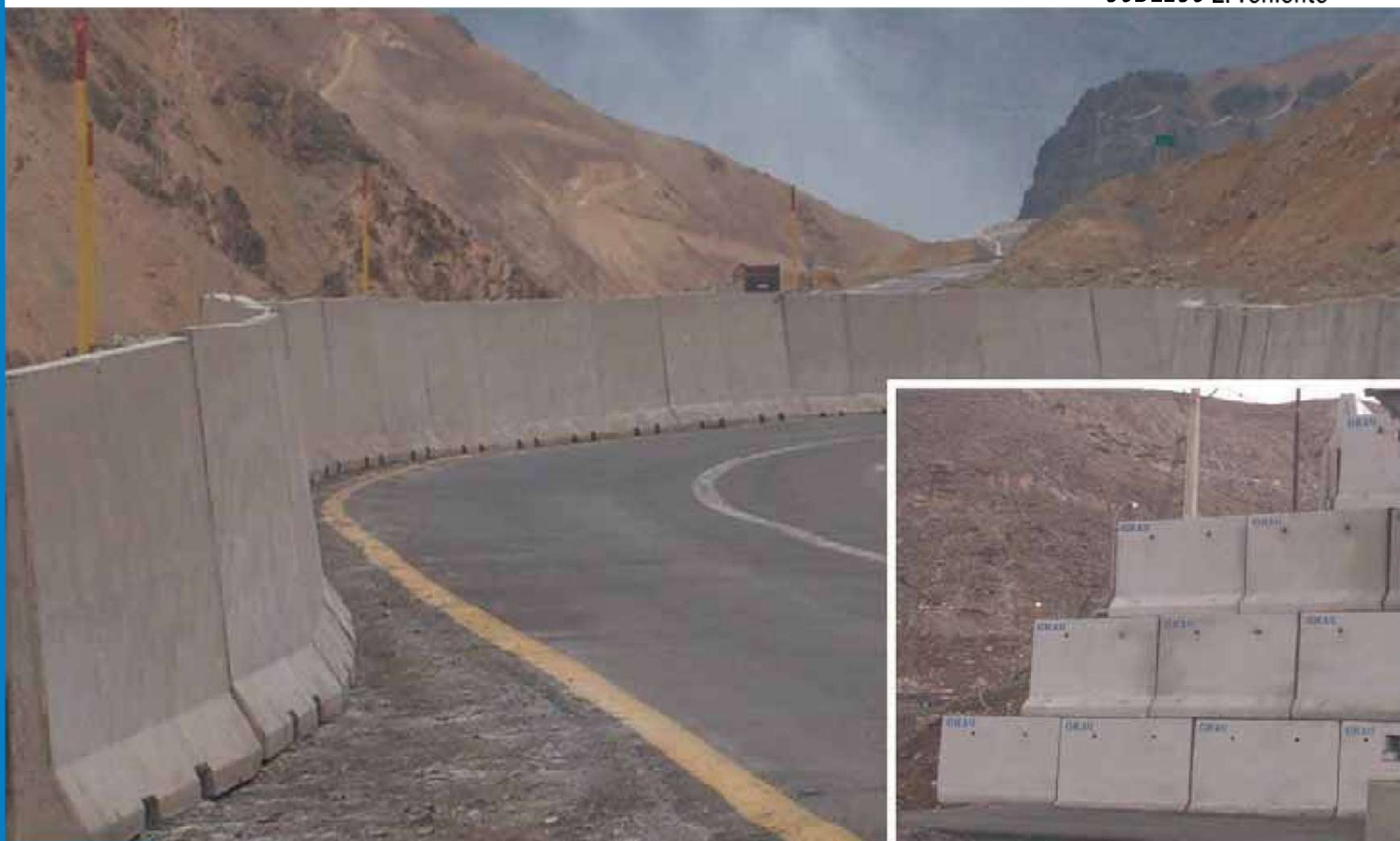
Muro Camellón • Los Pelambres • CODELCO El Teniente ▼
