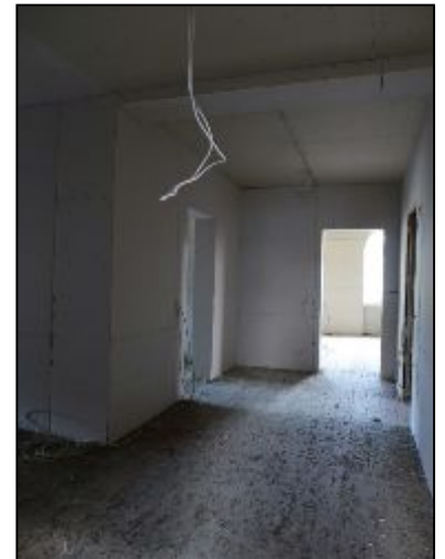
Umbau Bestand, Dachgeschoss
