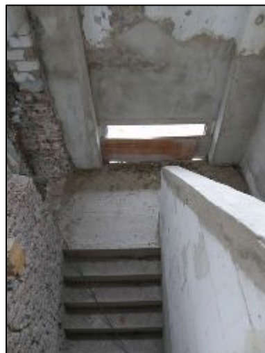
Bestand, Einbau Stahlbeton- treppehaus
