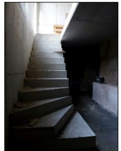
Erweiterung, Treppe zum KG
