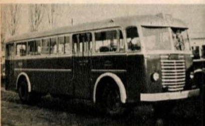
A MÁVAG M—5-ös 1950-ben állt forgalomba. Ez a busz 110 lóerővel dízelvezethető, 52 személyesre vizsgáztatták és 55 km/óra sebességet ért el
