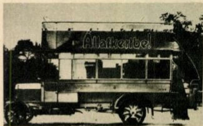
Az 1916-os Benz ugyan modernebb kivitelű volt, mint a Marta busz, de műszaki jellemzői — így a favázás építés is — azonosak. De ez már reflektort is kapott!
