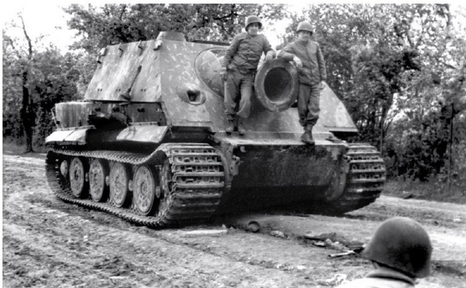
▲ et ▼ Victime d'une panne d'essence, ce Sturmörser de la Kp. 1002 sera sabordé par son équipage à l'aide d'un Panzerfaust le 11 avril 1945, sur la route entre Brumby et Calbe, à 27 km au sud de Magdebourg et 17 km à l'ouest de l'Elbe, quelques heures avant l'arrivée de la 8th US Infantry Division . La détonation de la charge creuse a désolidarisé du châssis l'arrière de la casemate et fait sauter l'éclisse de maintien à l'avant. Archives Caractère
