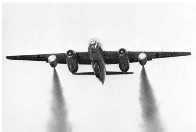
▲ Sous la poussée supplémentaire des fusées d'aide au décollage, l'Ar 234 V2 prend rapidement de l'altitude.
