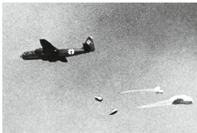
▲ En trois vues tirées d'un film d'usine, l'Ar 234 V2 larguant ses fusées épuisées après le décollage.
